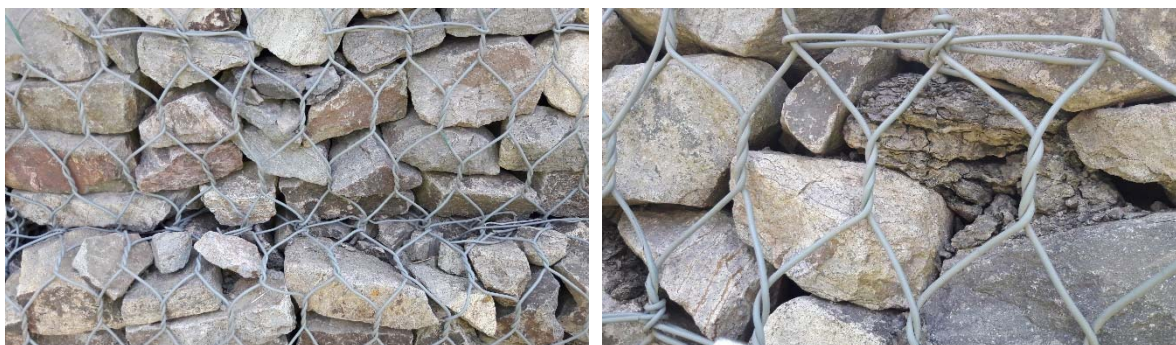
Figura 8 Presencia de piedras o rocas susceptibles al intemperismo o meteorización
