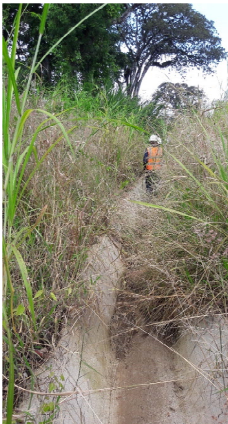
(a) Contracuneta localizada sobre el talud derecho (sentido ruta 1 – ruta 106)
