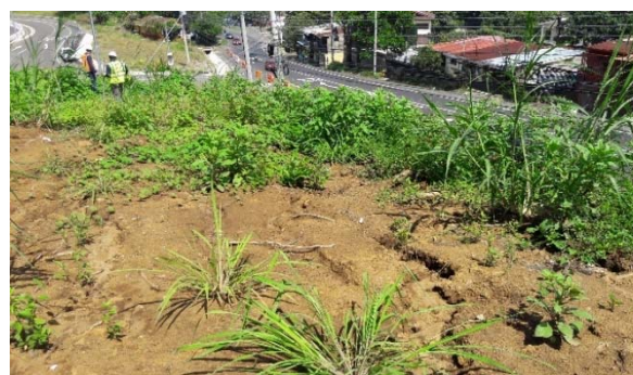
(b) corona del talud
