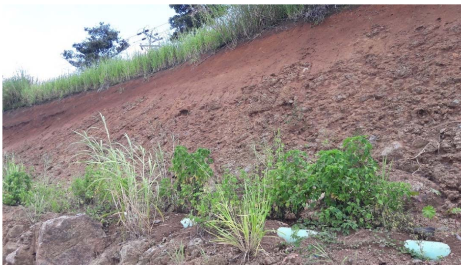
Figura 13 Talud con material rocoso en el talud derecho (sentido San Ramón – San José) en las cercanías de las terminales y aduanas Santamaria
