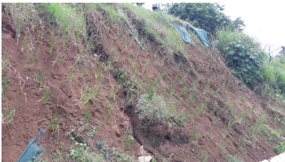
Figura 12 Medida adoptada de estabilización con vegetación del talud derecho (sentido San Ramón – San José) en las cercanías de las terminales y aduanas Santamaria
