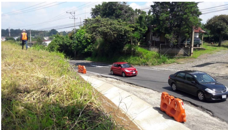
Figura 7 Taludes sin actividades de construcción de suelo cosido indicados en planos
