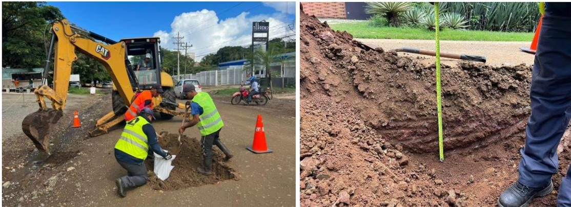
**Figura 3:** Ejecución de sondeos a cielo abierto en Calle Guanacaste.
