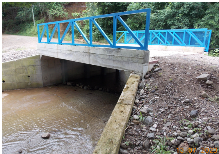
Figura 2: Vista general del puente. Fuente: LanammeUCR
