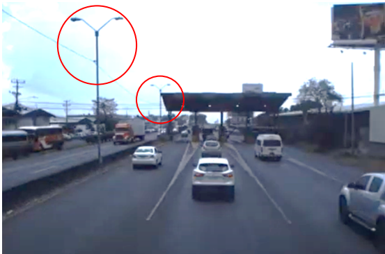
(A) Sector previo al peaje con luminarias
