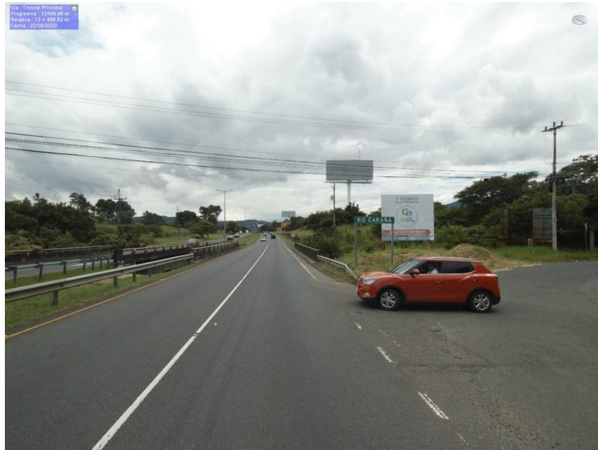
Figura 104. Accesos inseguros a Ruta Nacional 27, aledaño al puente sobre el río Caraña
