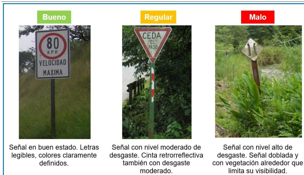
Figura 1. Clasificación visual en función del estado del señalamiento vertical
