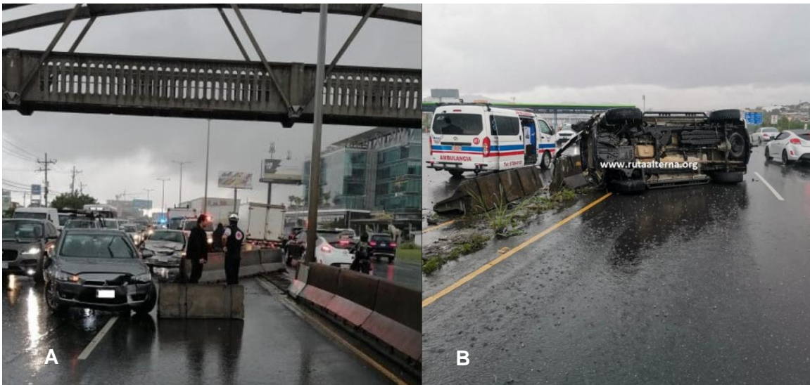
Figura 105. Choques viales contra sistemas de contención vehicular de concreto deficiente
