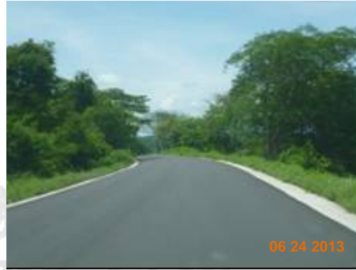
Fotografía 7. Ruta Nacional 18, 500 m después de Loma Bonita hacia el Río Tempisque. Fecha: 24/06/2013
