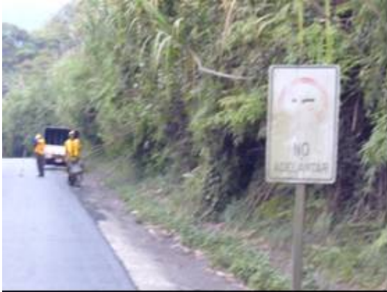
Fotografía 23. Señal de "NO ADELANTAR" no es visible. Ubicación: Ruta Nacional 32
