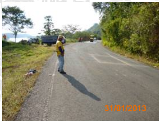
Fotografía 16. Personal encargado de la seguridad sin banderolas. Ubicación: Ruta Nacional 2, Aproximadamente Km 3+000 desde Intersección con Ruta 34, Palmar Norte hacia Buenos Aires
