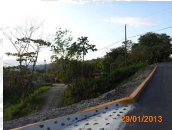
Fotografía 12. Punto que requiere de un diseño para instalar una barrera de contención Vehicular.
