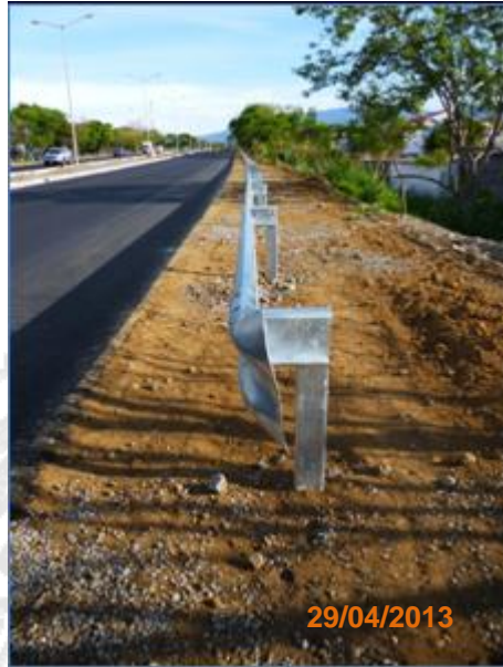
Fotografía 8. Uso de terminal tipo "cola de pez", no hay abatimiento ni esviaje.
