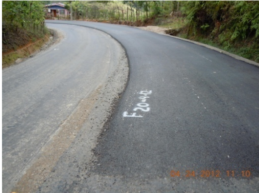
Fotografía 2. Ruta Nacional 244, proyecto Juntas de Pacuar-Pejibaye. Aprox. Km 11+900 desde intersección con Ruta Nacional 2. Fecha: 24/04/2012
