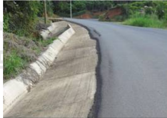
Fotografía 3. Ruta Nacional 244, proyecto Juntas de Pacuar-Pejibaye. Aprox. Km 12+000 desde intersección con Ruta Nacional 2. Fecha: 29/01/2013
