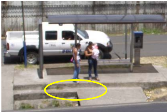
Fotografía 8.1. Presencia de obstáculos en la parada de autobús. Autopista General Cañas. (Fecha: 26 de febrero del 2009)
