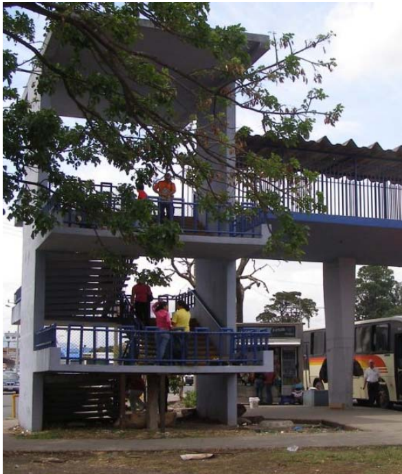
Fotografía 8.3 y 8.4. Puentes peatonales en la Autopista General Cañas sin rampas. Puente del Hospital México y Saret, respectivamente. (Fecha: 6 de mayo del 2009)
