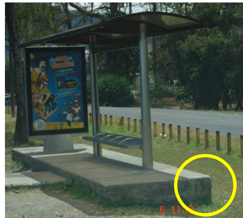
Fotografía A.6.5 y A.6.6. Paradas de autobús en la Autopista Florencio del Castillo, las cuales no cuentan con un acceso adecuado para todos los usuarios. (Fecha: 6 de marzo del 2009)
