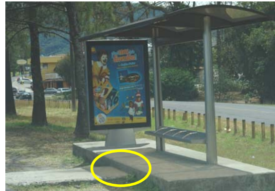
Fotografía 8.2. Presencia de obstáculos en la parada de autobús. Autopista Florencio del Castillo. (Fecha: 6 de marzo del 2009)
