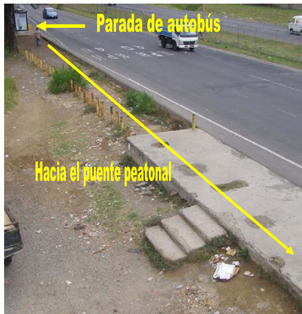
Fotografía A.7.5 y A.7.6. Acceso inadecuado entre el puente peatonal y la parada de autobús. Autopista Florencio del Castillo. (Fecha: 6 de mayo del 2009)
