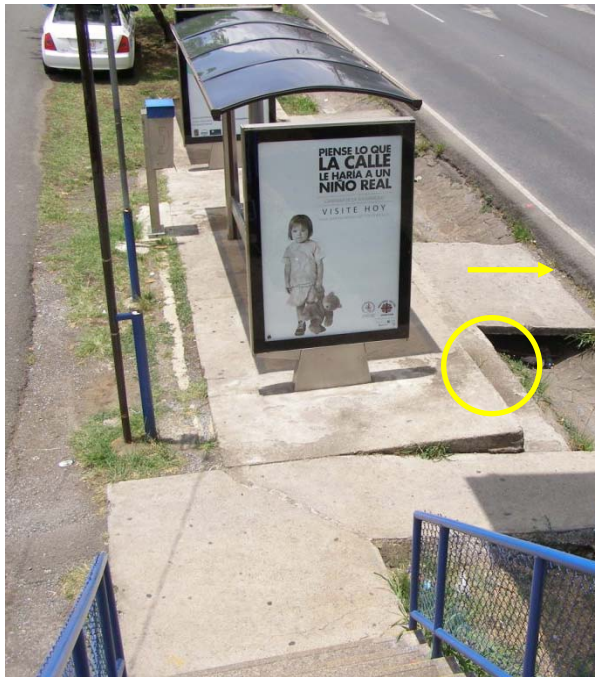
Fotografía A.7.1 y A.7.2. Acceso inadecuado entre el puente peatonal y la parada de autobús, Ruta 1, en el INA y en el Real Cariari, respectivamente. (Fecha: 6 de mayo del 2009)
