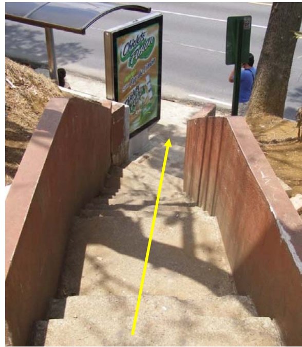
Fotografía A.7.1 y A.7.2. Acceso inadecuado entre el puente peatonal y la parada de autobús, Ruta 1, en el INA y en el Real Cariari, respectivamente. (Fecha: 6 de mayo del 2009)
