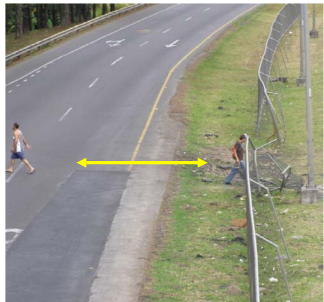
Fotografía A.7.5 y A.7.6. Acceso inadecuado entre el puente peatonal y la parada de autobús. Autopista Florencio del Castillo. (Fecha: 6 de mayo del 2009)
