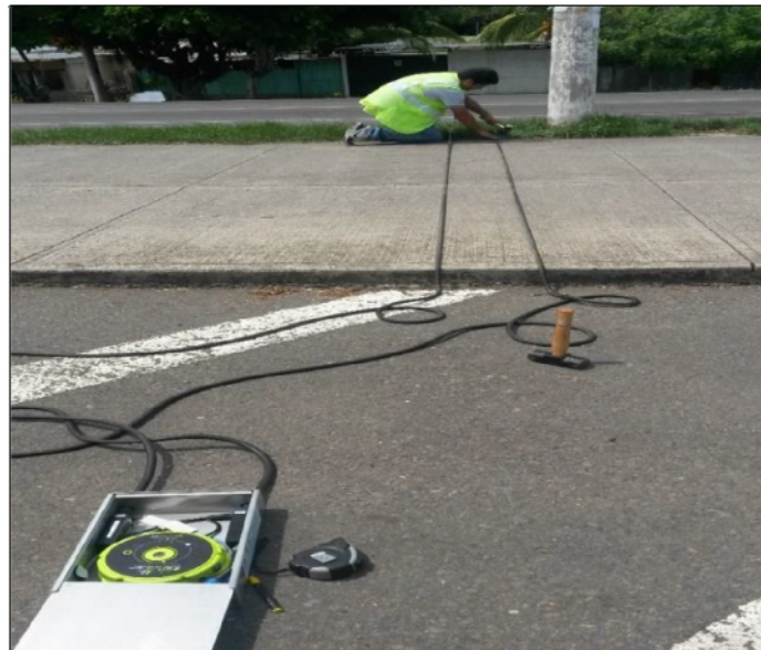
Figura 4. Ejemplo de la colocación de contadores de bicicletas Fuente: (Espinoza, 2015)
