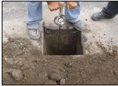
Figura 22. Prueba de CBR en sitio
