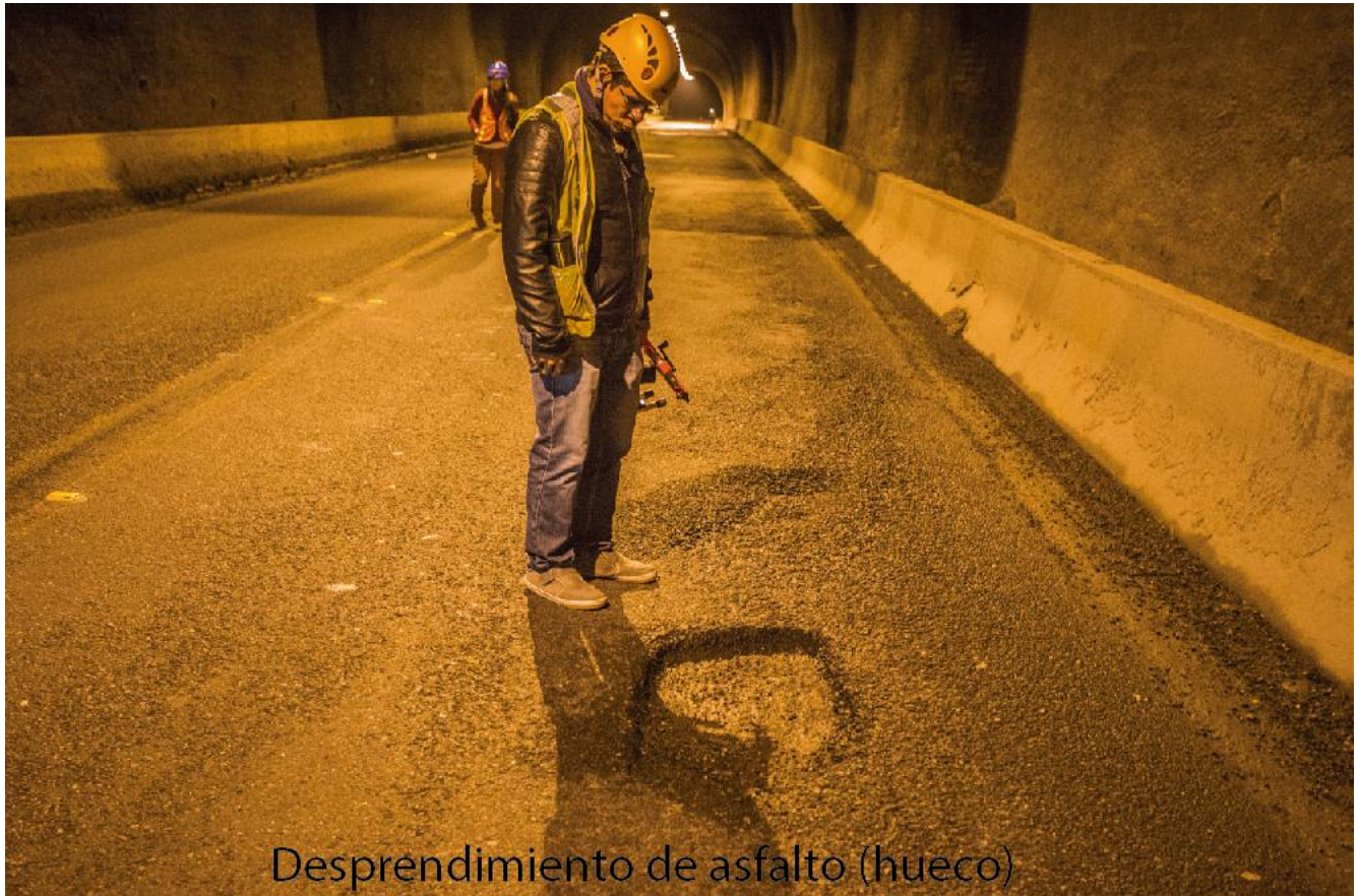
Figura 13. Desprendimiento de pavimento
