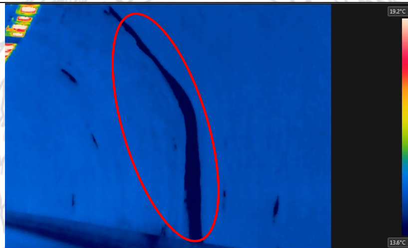
Figura 30. Est. 0+580 se presenta una infiltracion en la pared del LI
