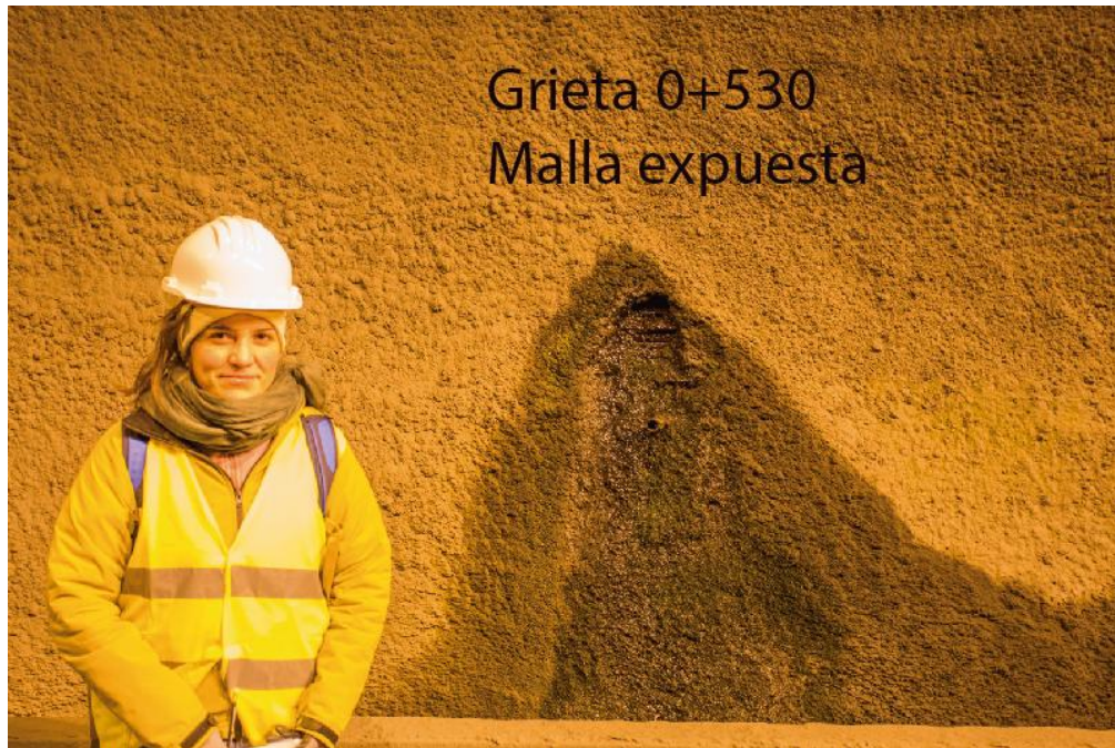
Figura 14. Malla expuesta en sitio con goteo estacionamiento 0+530
