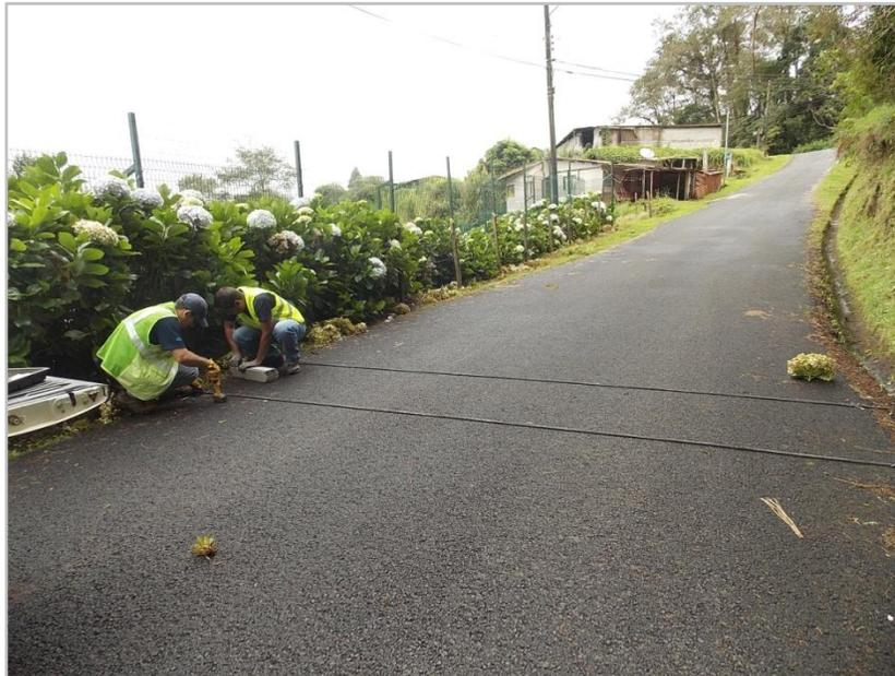
**Figura 5.** Contadores automáticos en red vial del distrito de Vara Blanca
