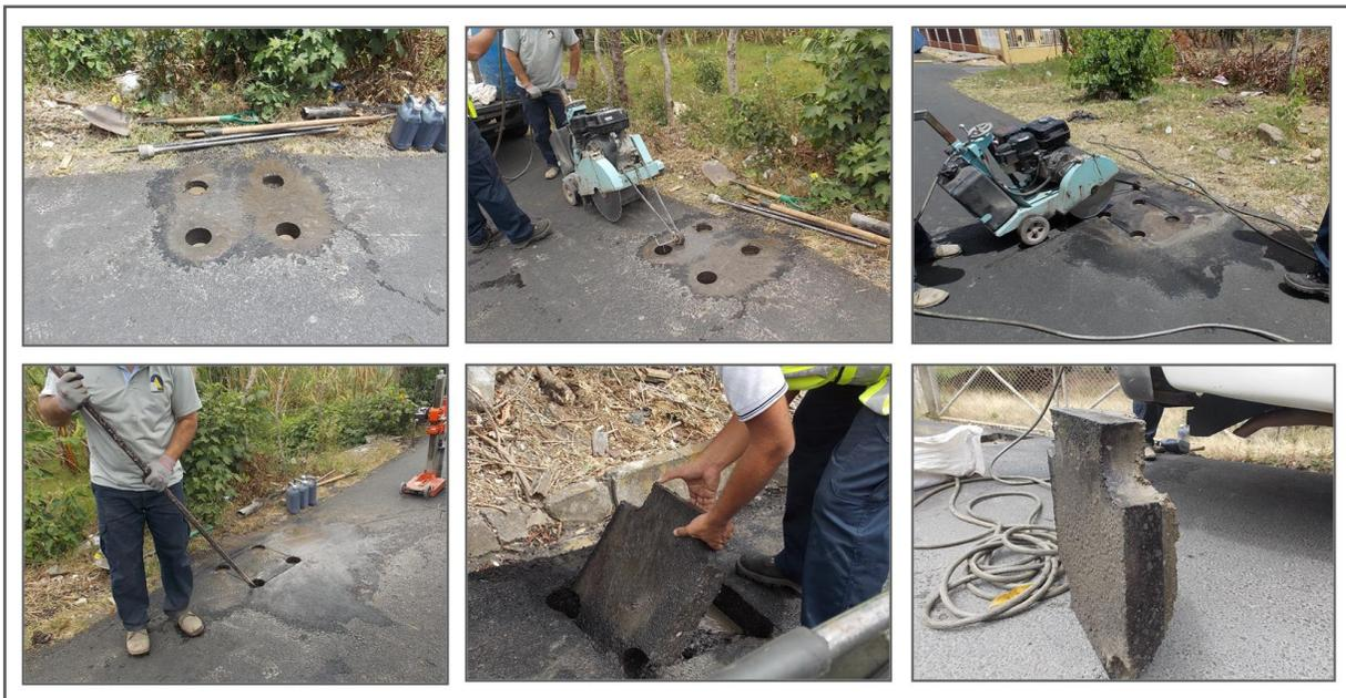
**Figura 22.** Procedimiento de extracción del bloque en los sondeos
