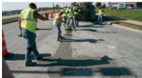
(g) Colocación del material de relleno, vibrado y acabado
