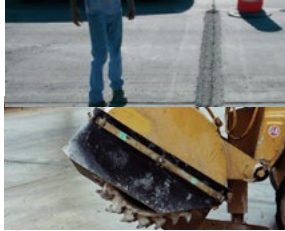
(c) Demolición y remoción del concreto perfiladora
