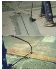
(h) Corte y sellado de juntas
