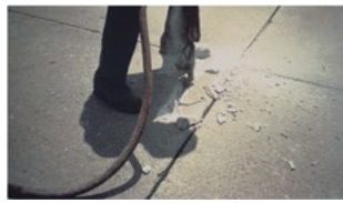
(b) Demolición y remoción del concreto martillo neumático
