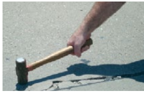
(a) Demarcación del área a reparar
