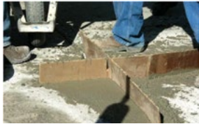
(e) Preparación de las juntas
