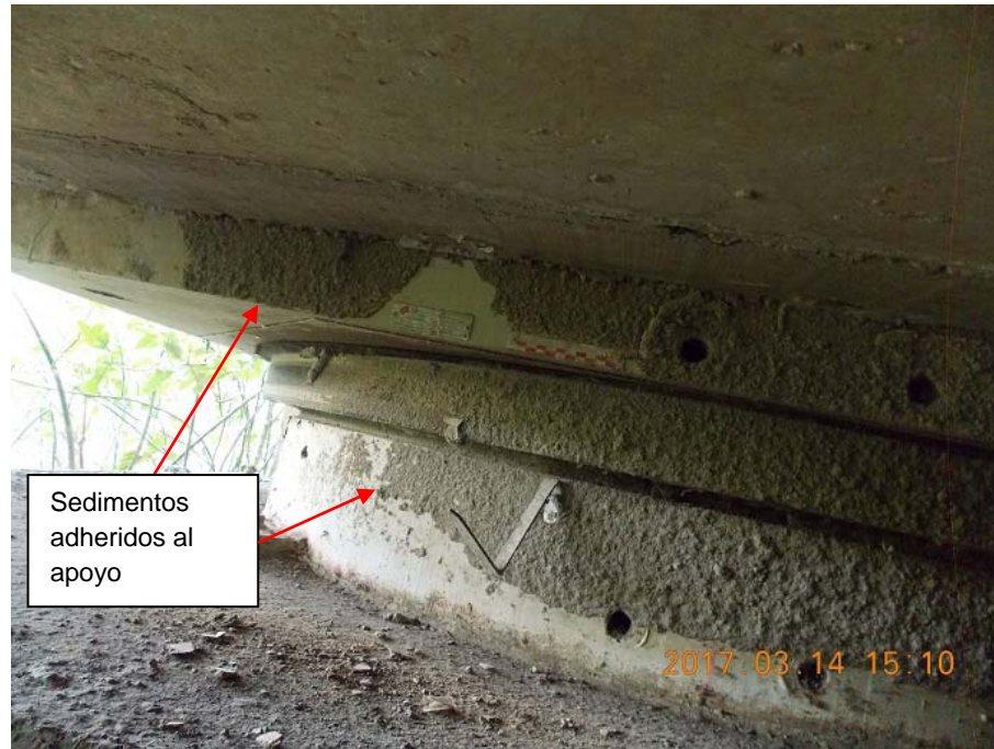
Figura 13. Apoyo sobre el bastión 1 en contacto con sedimentos
