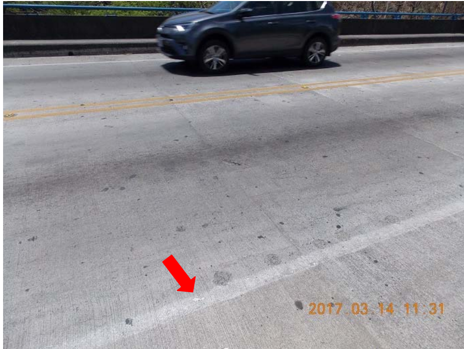
Figura 5. Demarcación horizontal en mal estado
