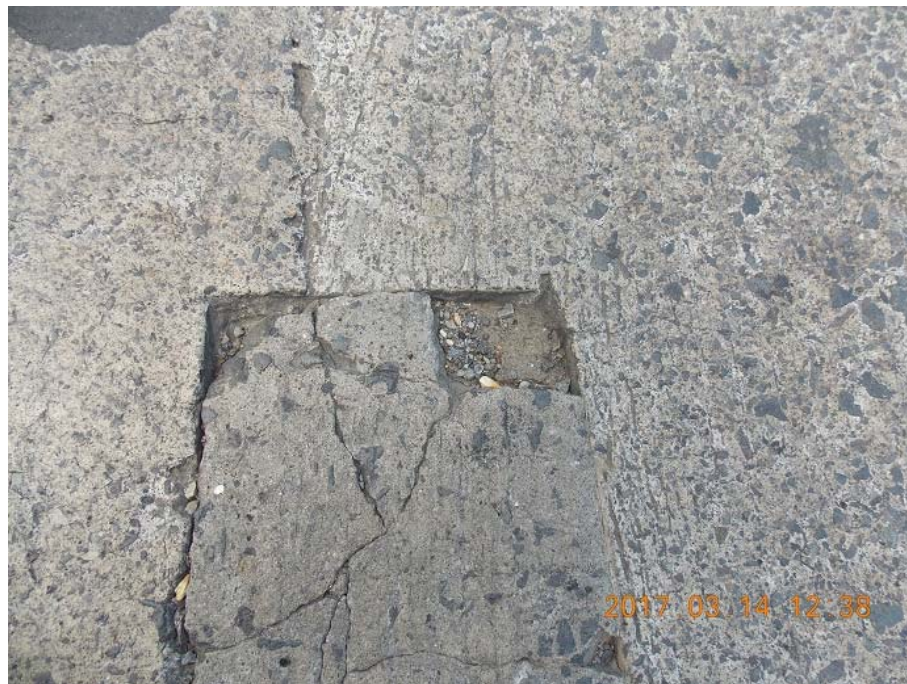
Figura 14. Desprendimiento de concreto en una reparación realizada al tablero
