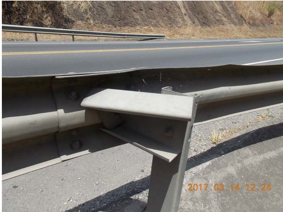
Figura 3. Deformación de elementos del guardavías aparentemente por impacto.
