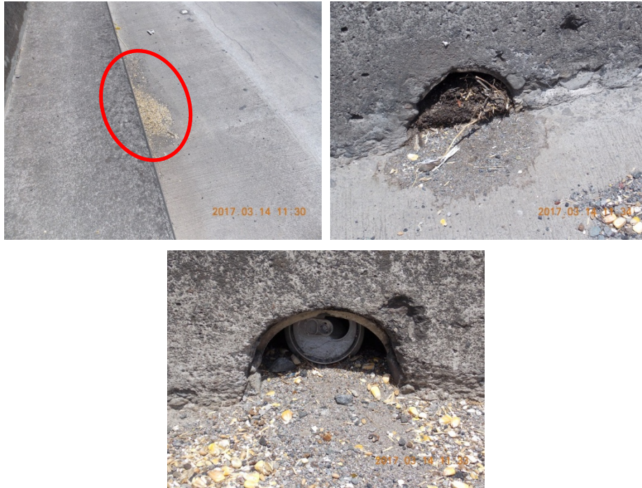
Figura 7. Acumulación de sedimentos en bordillo y obstrucción de drenajes
