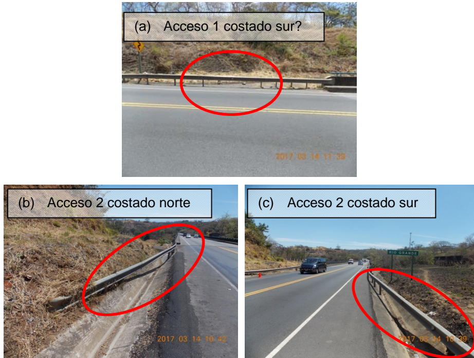
Figura 1. Faltante de elementos verticales de los guardavías.
