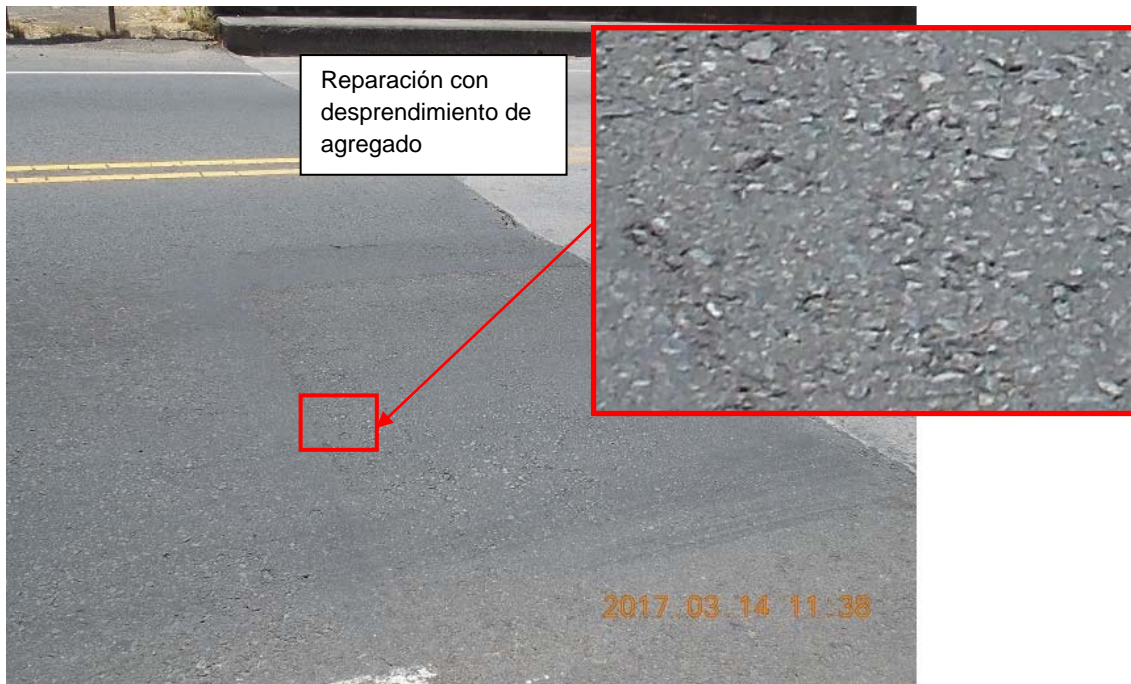
Figura 10. Condición del pavimento del acceso 1
