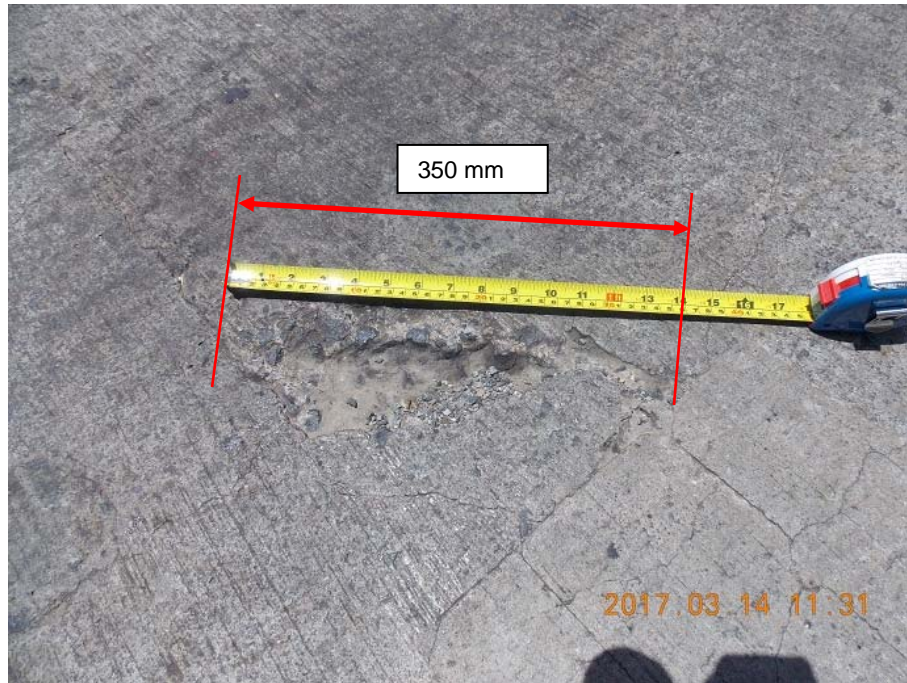
Figura 13. Desprendimiento del recubrimiento del tablero sin exposición del acero de refuerzo.
