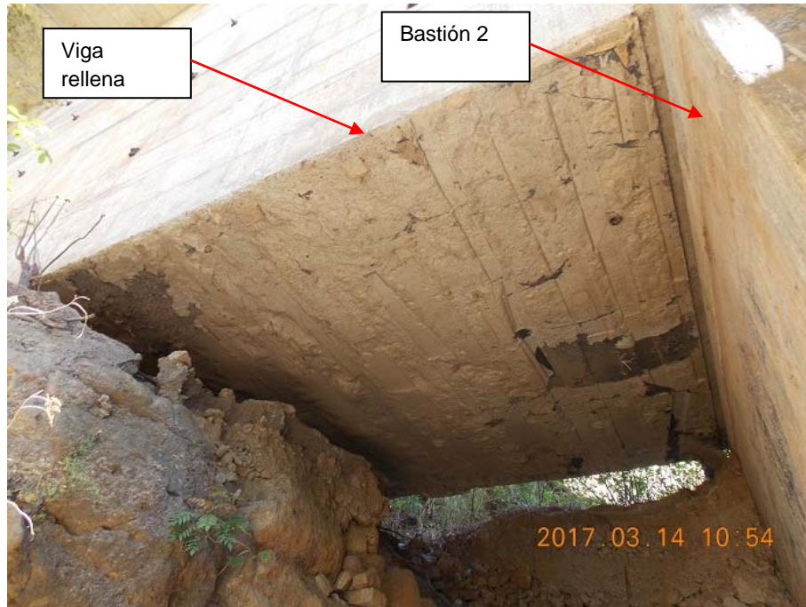
Figura 15. Pérdida de relleno bajo el tramo de viga rellena detrás del bastión 2.
