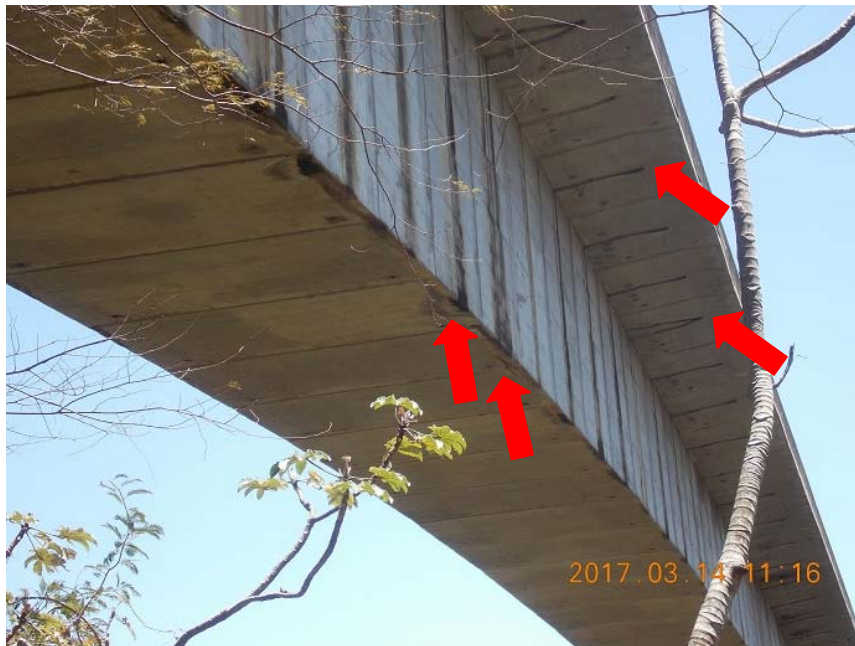
Figura 8. Drenajes sin tubos de extensión y evidencia de descarga de agua sobre la viga principal
