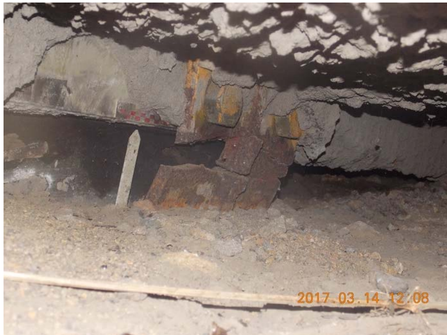
Figura 18. Apoyo norte sobre el bastión 1 en contacto con sedimentos. Nótese el indicador de desplazamiento longitudinal marcando el borde de la cinta graduada.
