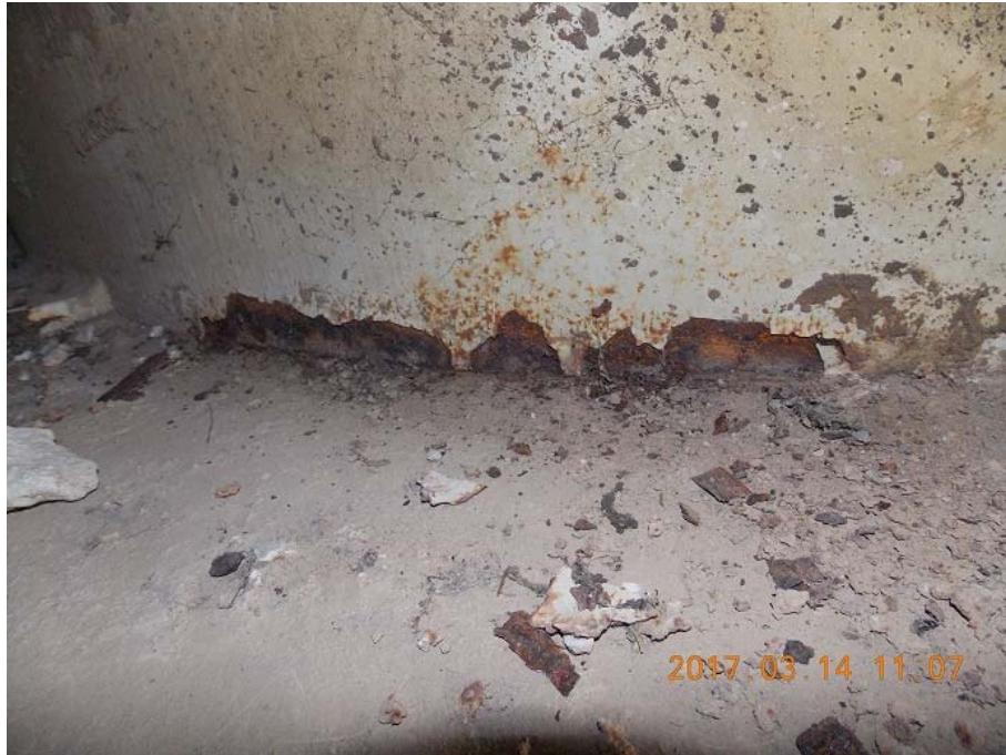
Figura 17. Oxidación y corrosión de la placa inferior del apoyo norte sobre el bastión 2.
