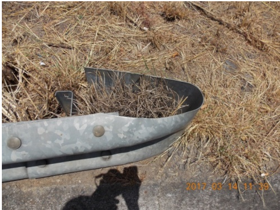
Figura 4. Terminal de barrera no anclado al terreno y con terminación en apariencia inadecuada.
