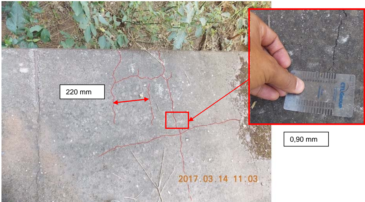
Figura 19. Agrietamiento en la cara superior de la llave de cortante del costado norte del bastión 2.
