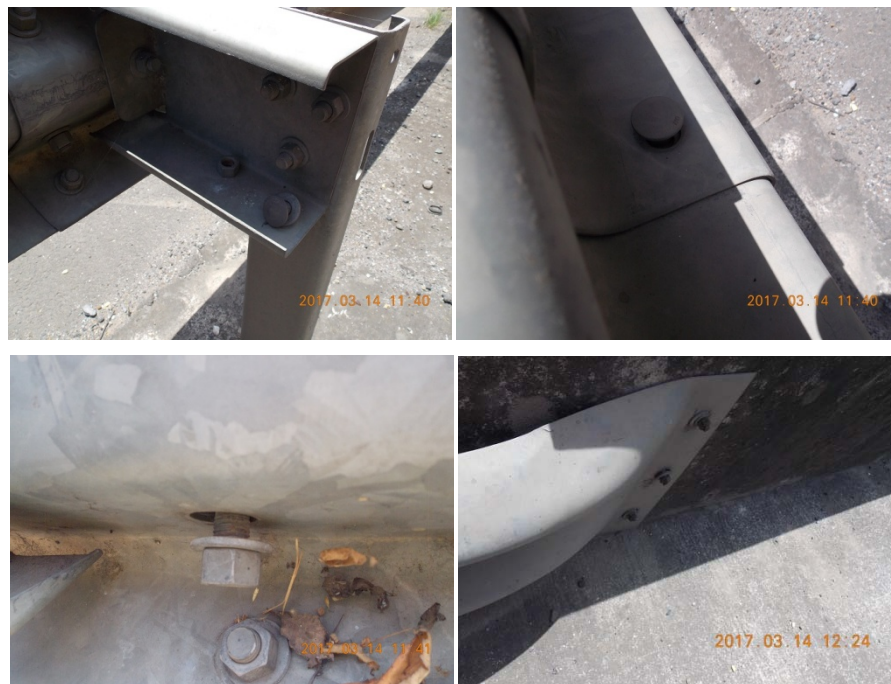
Figura 2. Ejemplos de pernos sueltos o flojos en conexiones del guardavías.
