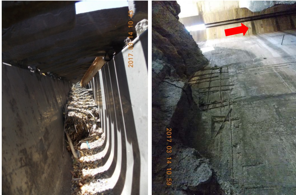
Figura 9. Acumulación de sedimentos y evidencia de filtraciones en la junta de expansión del acceso 2
