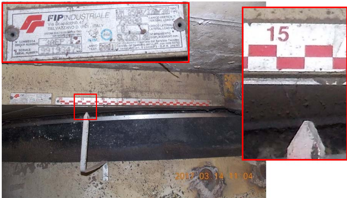
Figura 16. Desplazamiento longitudinal de 140 mm del apoyo norte sobre el bastión 2
