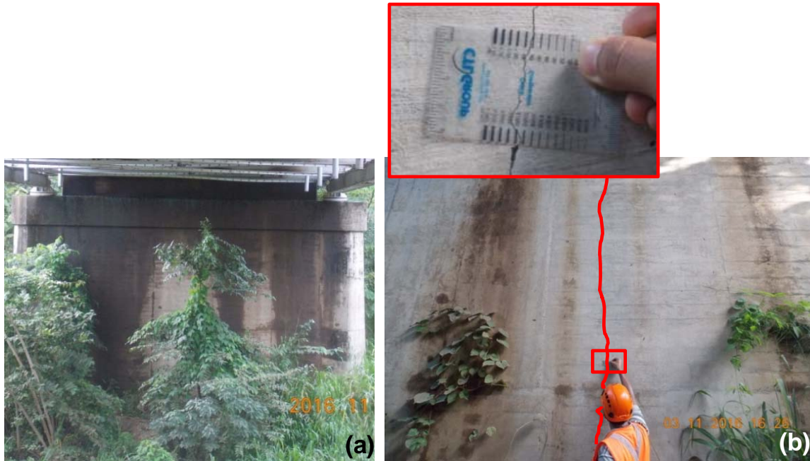
Figura 15. Pila P1: (a) Filtración de agua en aproximadamente 100% del área de superficie sur; (b) Grieta vertical de todo el alto del cuerpo de la pila.
