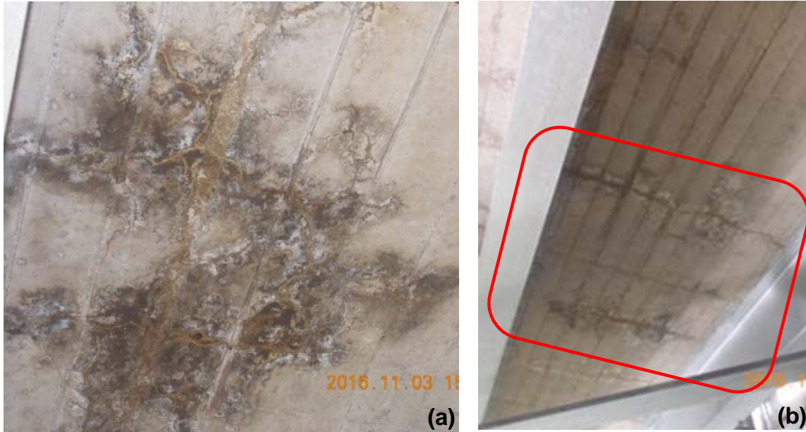
Figura 7. Losa de concreto superestructura 1: (a) Deterioro avanzado con alta incidencia de humedad y eflorescencia ; (b) Agrietamiento transversal con evidencia de eflorescencia.
