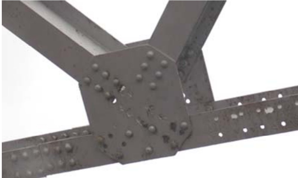
Figura 11. Elementos de los portales con zonas con puntos de corrosión así como deterioro del sistema de protección de pintura.
