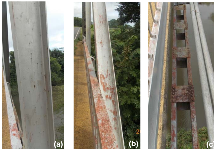
Figura 8. Armaduras de la superestructura 1: (a) Zonas con puntos de oxidación; (b) Deterioro del sistema de protección de pintura en diagonal; (c) Deterioro del sistema de protección de pintura en cuerda inferior de armadura este.
