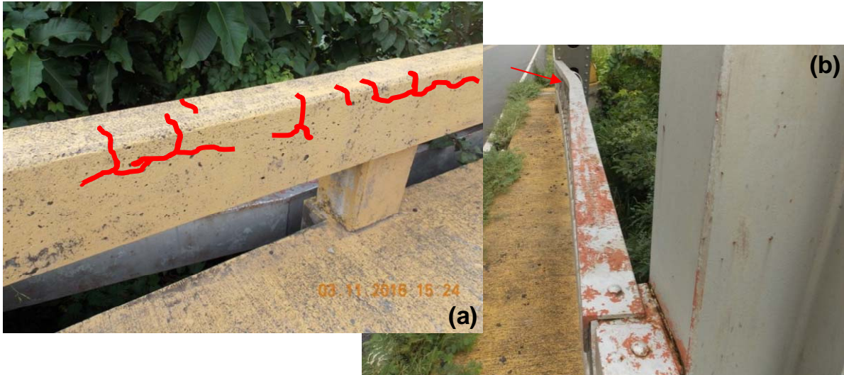
Figura 1. Barrera de contención vehicular: (a) Agrietamiento aleatorio en barrera de contención vehicular de concreto; (b) Zona impactada, deterioro del sistema de protección de pintura y puntos de corrosión en barrera de contención vehicular de acero.
