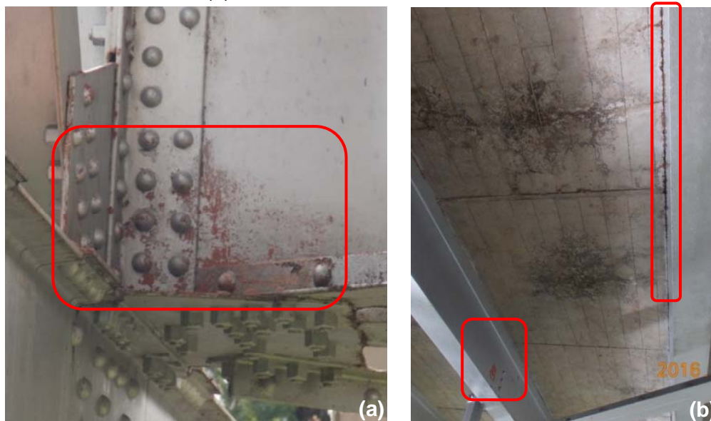
Figura 9. Elementos deformados en superestructura 1: (a) Elemento diagonal de armadura oeste; (b) Elemento vertical de armadura este.
