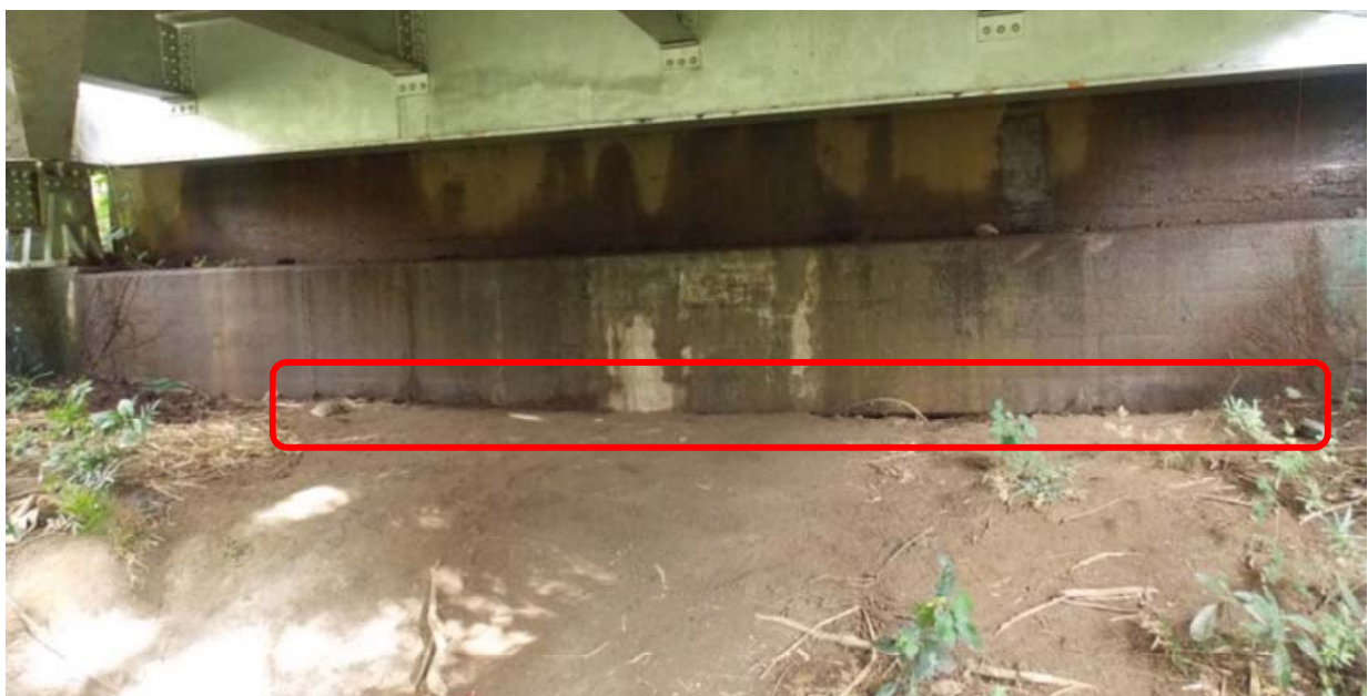
Figura 14. Filtración de agua en 100% del área de viga cabezal de bastión B1, así como exposición de pequeña sección de superficie inferior de viga cabezal.
