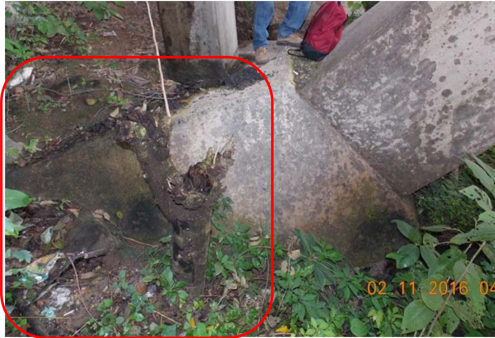
Figura 12. Sección expuesta de la cimentación sureste del arco noreste.
