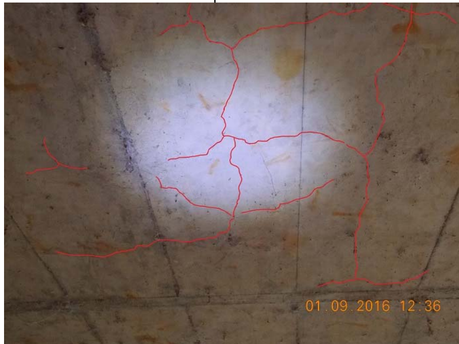
Figura 12. Detalle de agrietamiento en la cara inferior del tablero.
