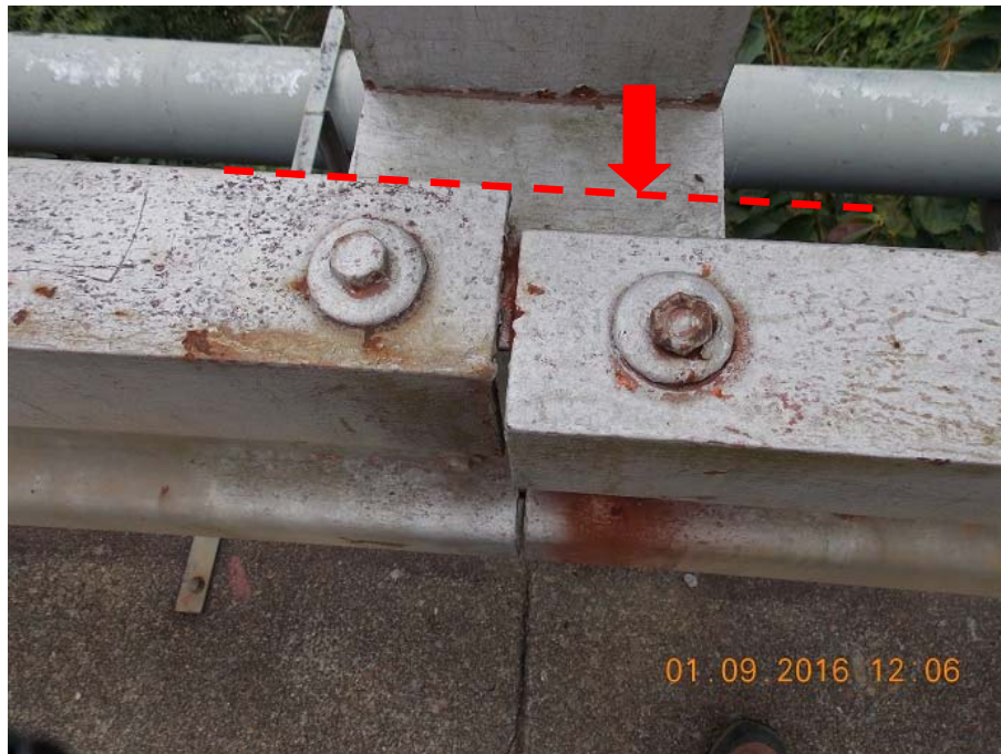
Figura 2. Desplazamiento horizontal de la barrera vehicular
