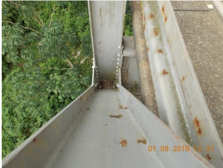
Figura 3. Puntos de oxidación en elementos de cercha (izquierda) y barrera vehicular.
