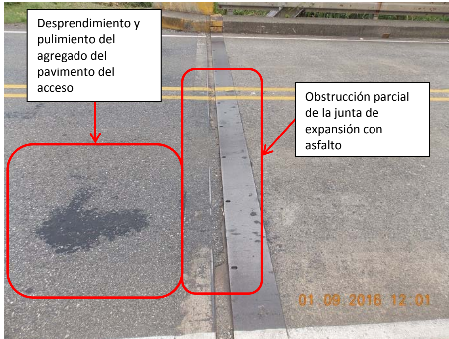
Figura 9. Obstrucción parcial en la junta de expansión del acceso 1 y estado del pavimento del acceso.
