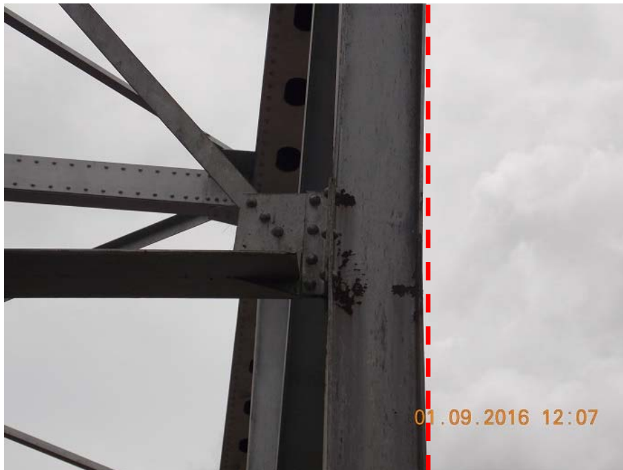
Figura 14. Puntos de oxidación y deformación de elemento vertical de la armadura.
