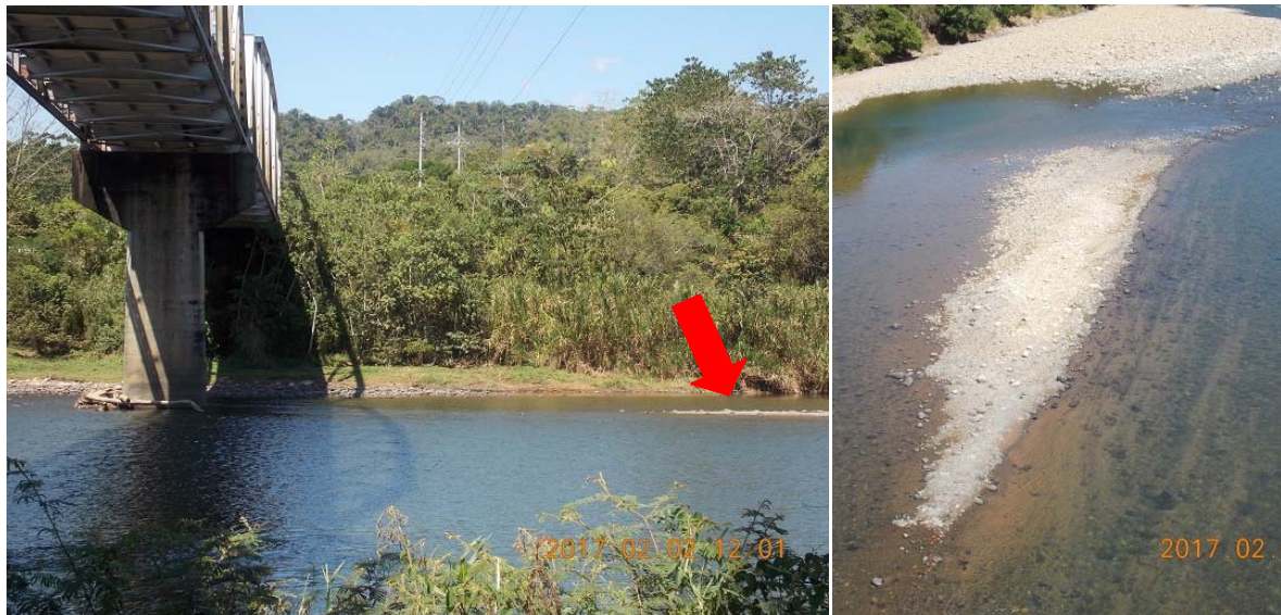
Figura 22. Acumulación de sedimentos aguas debajo de la pila 1.
