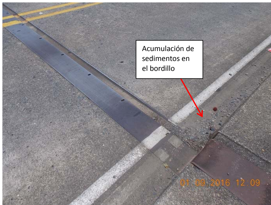
Figura 6. Acumulación de sedimentos en el bordillo.
