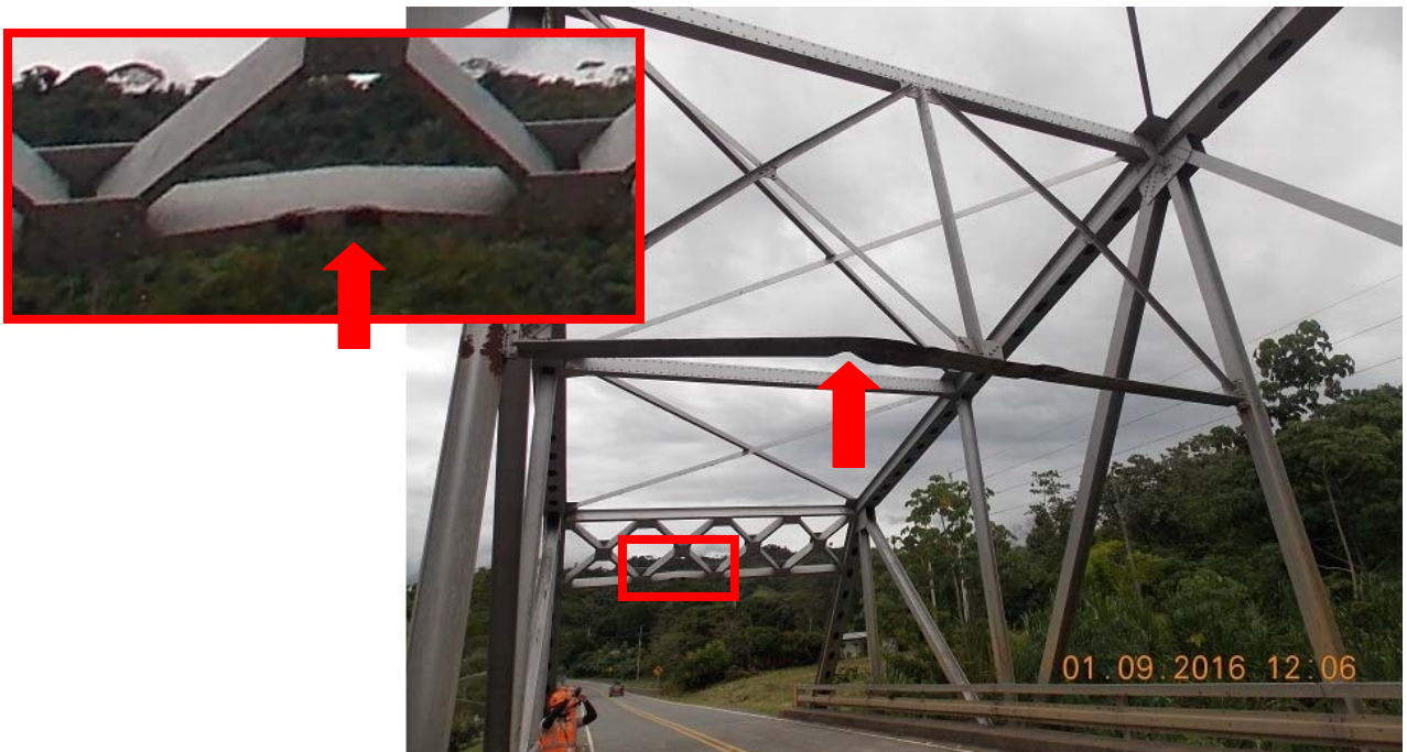
Figura 18. Deformación en el portal del acceso 1 y en sistema de arriostamiento vertical.
