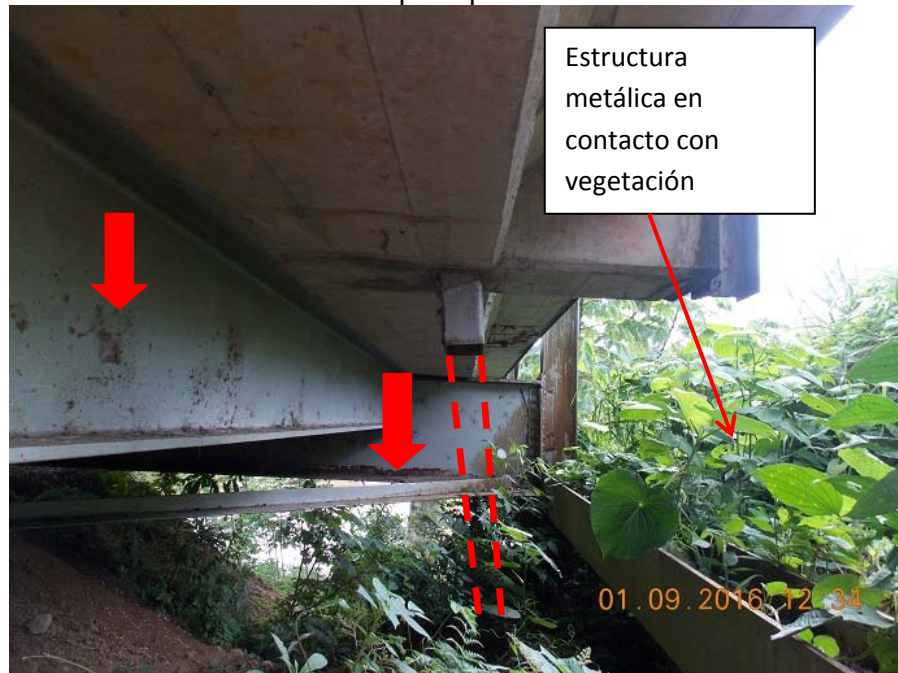
Figura 16. Deterioro del sistema de protección de pintura y oxidación puntual en vigas de piso y transversal.
