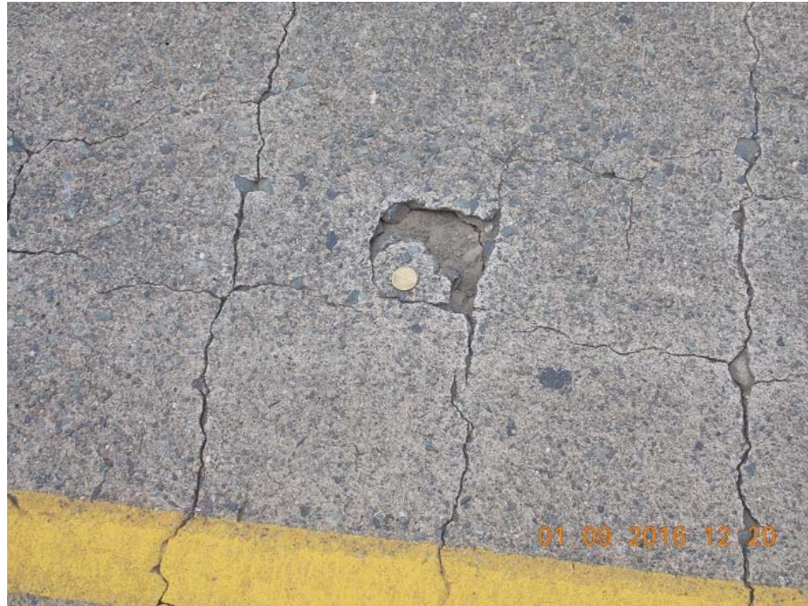
Figura 11. Detalle de agrietamiento con desprendimiento en la cara superior del tablero. La moneda de 100 colones tiene aproximadamente 30 mm de diámetro.
