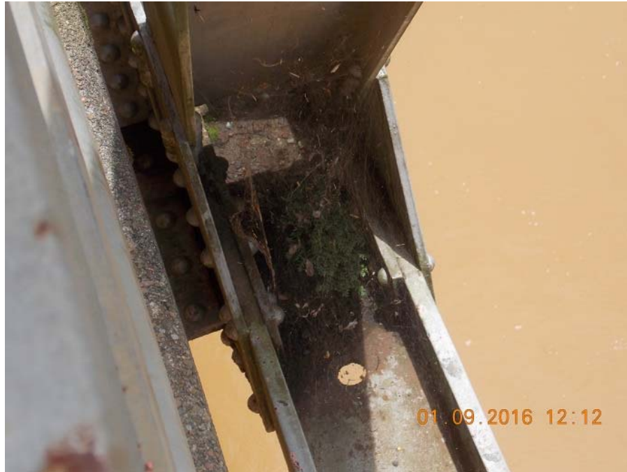
Figura 15. Acumulación de sedimentos y presencia de vegetación en conexión de armadura principal.
