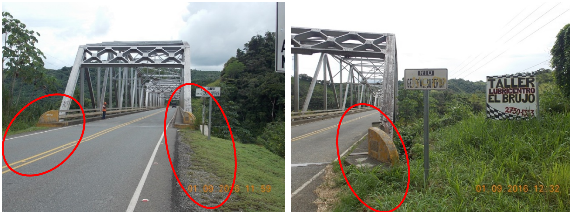
Figura 4. Ausencia de sistema de contención vehicular y marcadores de objeto en los accesos
