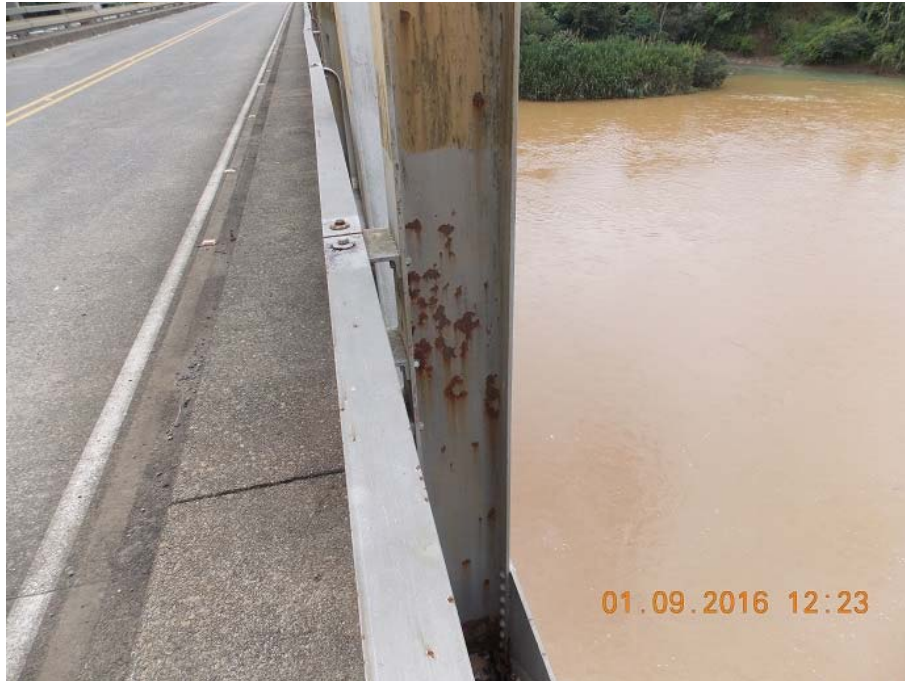
Figura 13. Deterioro del sistema de protección contra la corrosión y presencia de puntos de oxidación en elemento vertical de cercha principal.
