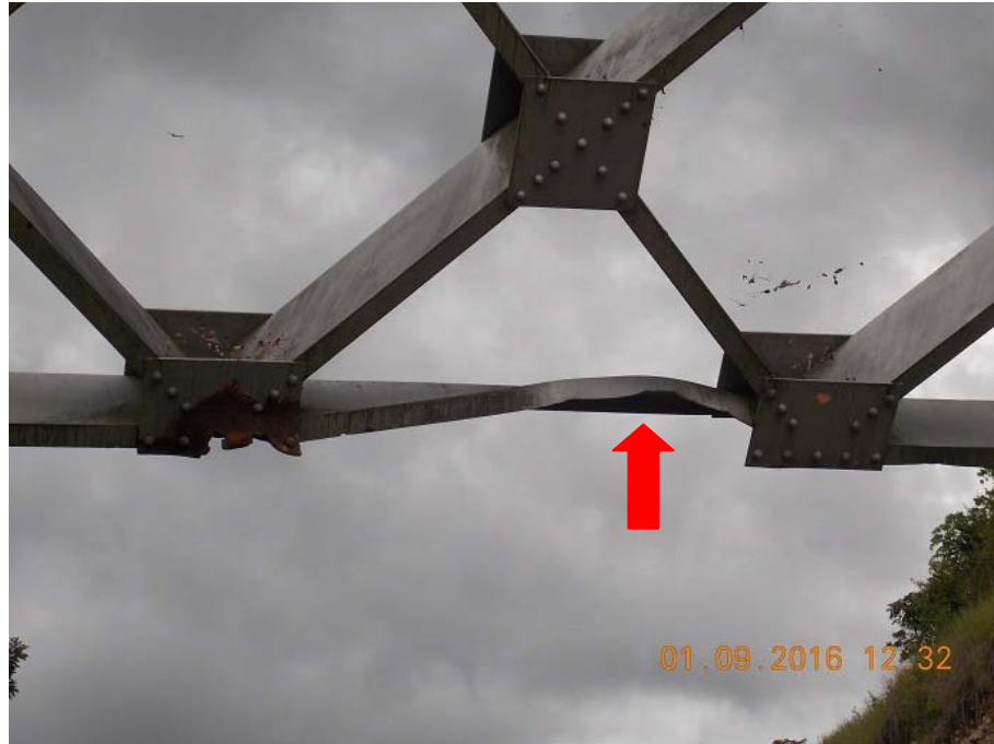
Figura 17. Deformación en el portal del acceso 2.
