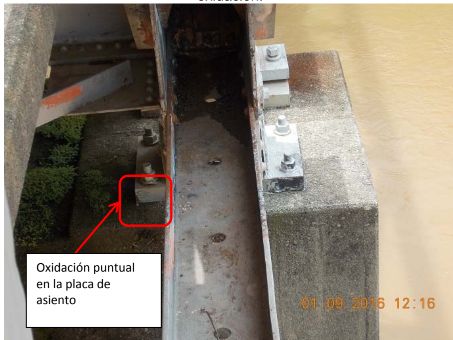
Figura 20. Oxidación puntual en apoyo sobre la pila 2.
