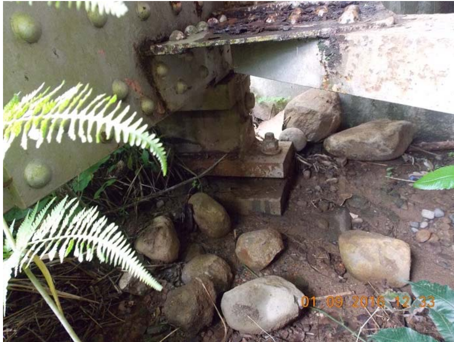
Figura 19. Apoyo sobre el bastión 2 en contacto con sedimentos y con presencia de oxidación.
