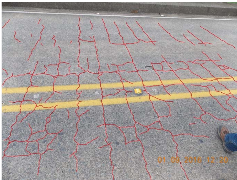
Figura 10. Patrón de agrietamiento de la cara superior del tablero
