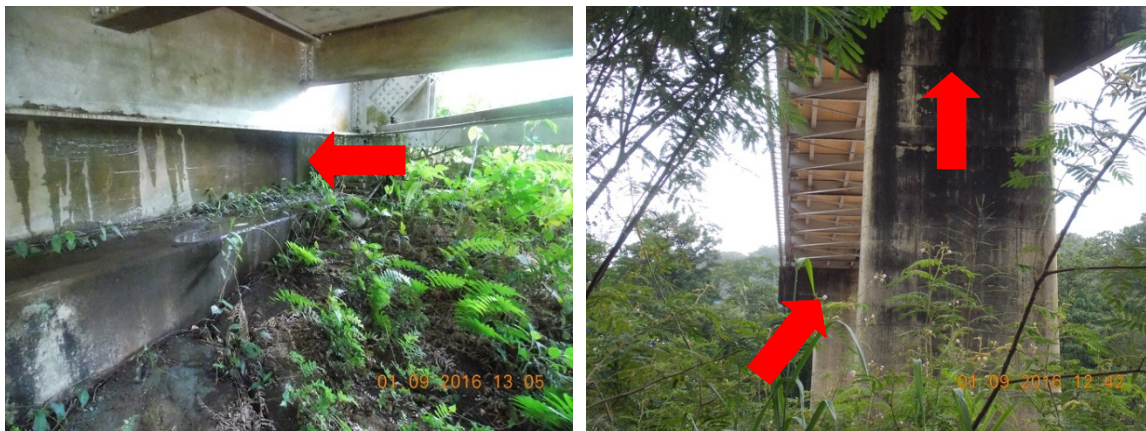
Figura 8. Evidencia de filtración de agua sobre la el bastión 2 (izquierda) y las pilas.
