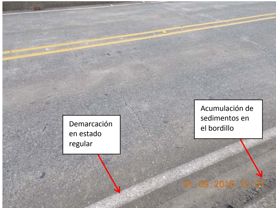
Figura 5. Demarcación horizontal en estado regular.
