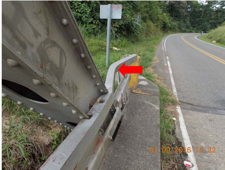
Figura 1. Deformación en la barrera vehicular del costado Este del acceso Sur
