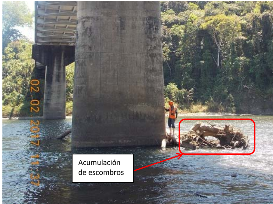
Figura 21. Acumulación de escombros aguas arriba de la pila 1. Nótese al inspector verificando si la placa de cimentación es visible.
