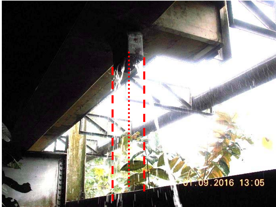
Figura 7. Tubo de extensión de los drenajes con longitud insuficiente.
