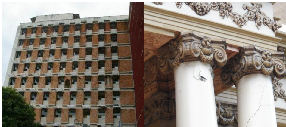
Figura 5.4. DAÑOS EN FACHADA DEL HOSPITAL MONSEÑOR SANABRIA Y COLUMNAS DE LA IGLESIA DE NARANJO (LIS, 2015)
