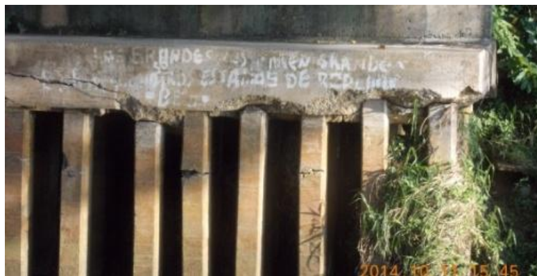
c) cemento dañado
