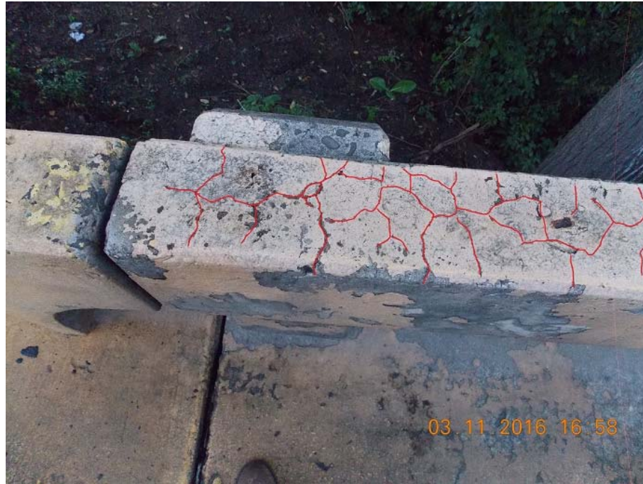
Figura 1. Patrón de agrietamiento en la barrera vehicular.
