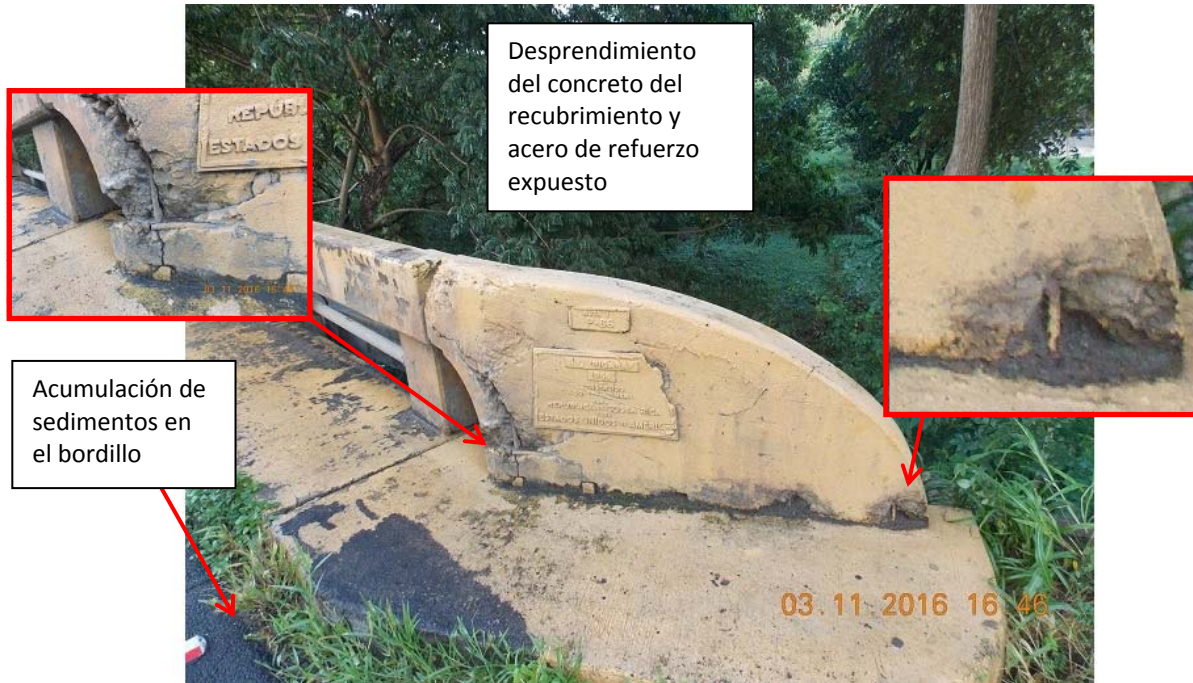
Figura 3. Daños por aparente impacto en la barrera vehicular y acumulación de sedimentos en el bordillo.
