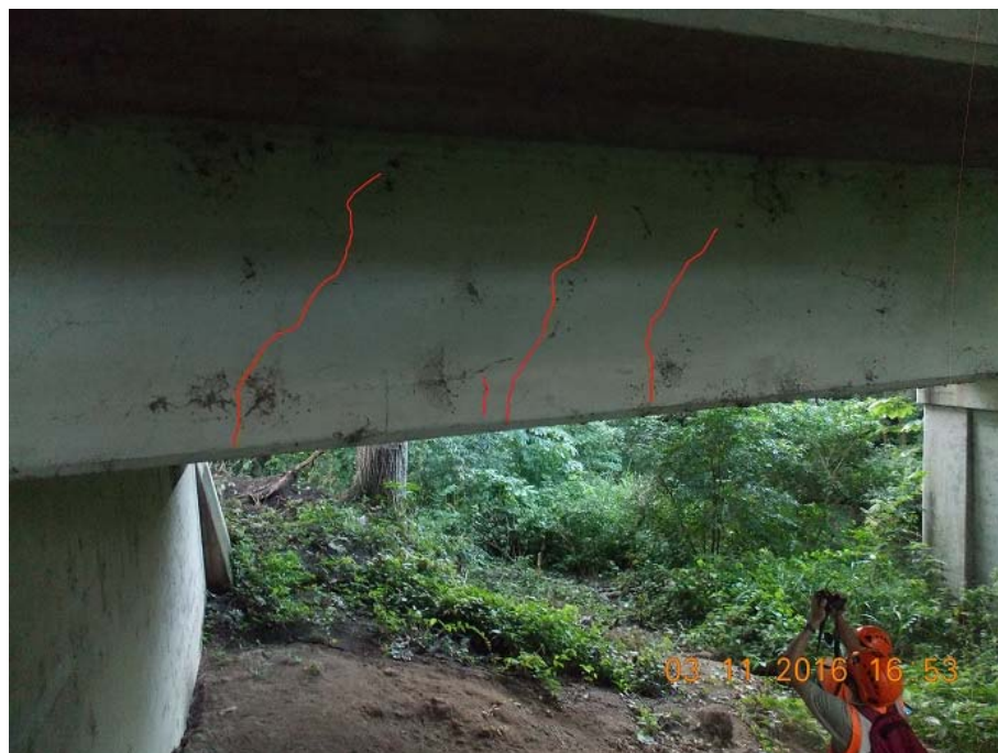
Figura 8. Patrón de agrietamiento observado en el extremo de las vigas apoyado en los bastiones
