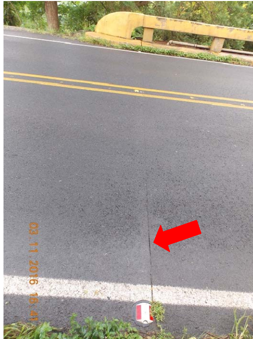
Figura 7. Junta de expansión cubierta con asfalto
