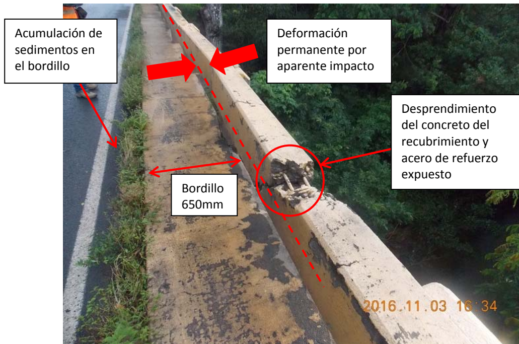
Figura 2. Daños por aparente impacto en la barrera vehicular y acumulación de sedimentos en el bordillo.
