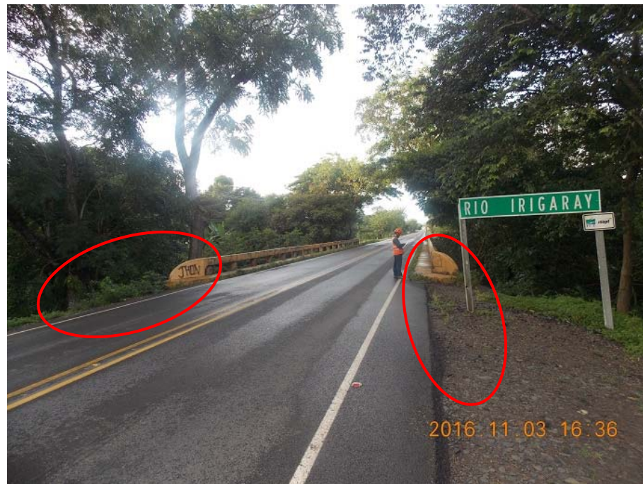
Figura 4. Ausencia de guardavías y marcadores de objeto en acceso.
