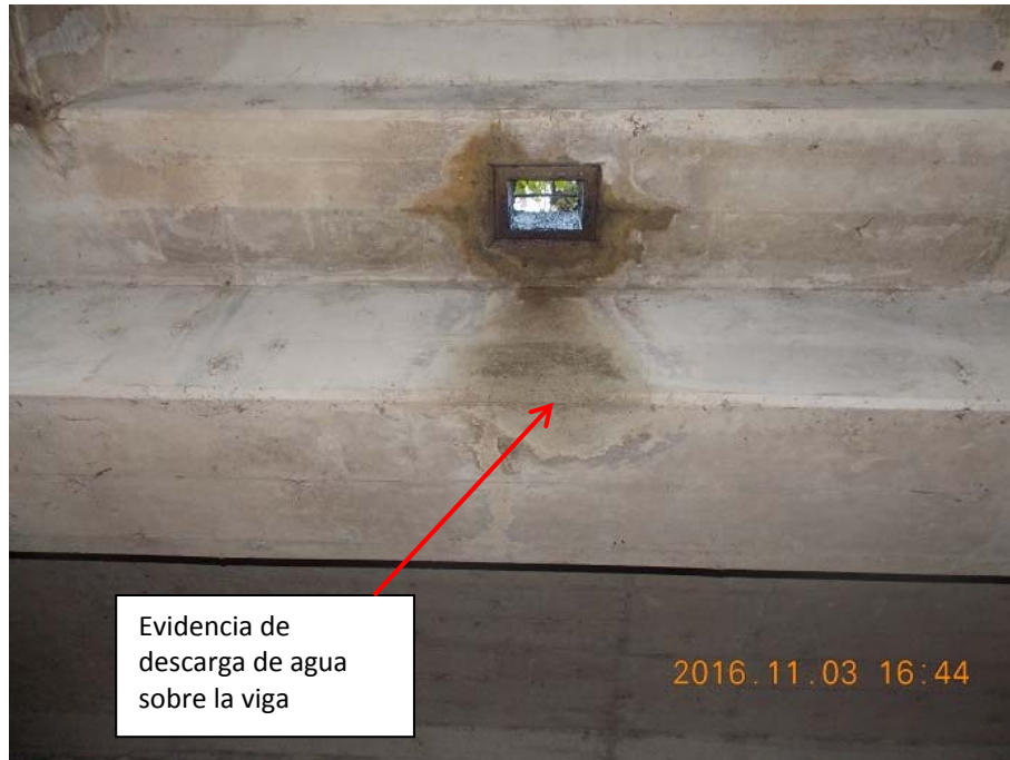
Figura 5. Ducto de drenaje sin tubos de extensión
