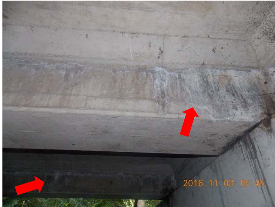
Figura 9. Eflorescencia con acumulación de carbonato de calcio en vigas
