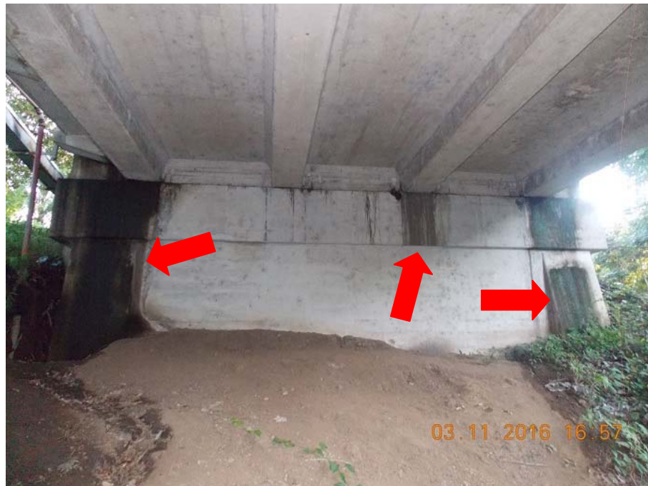
Figura 6. Evidencia de filtración de agua sobre los bastiones.
