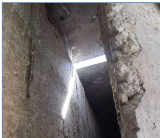
(a) Ausencia de drenaje en las juntas del puente.
