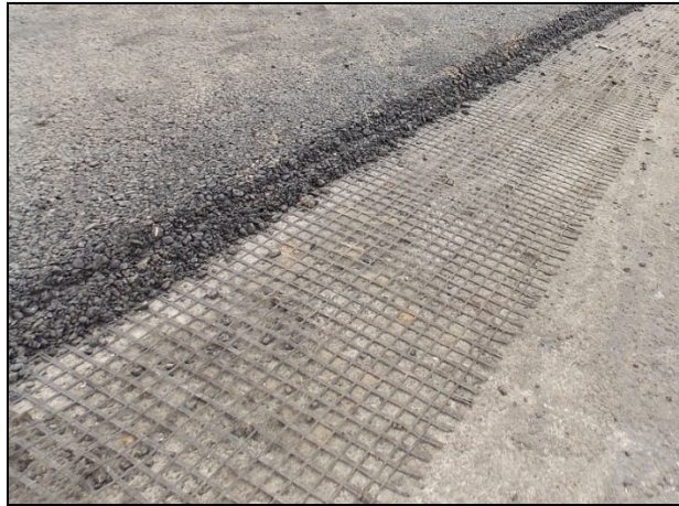
Fotografía 12. Geomalla entre capas de mezcla asfáltica en el eje No. 3.
