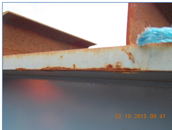
Fotografía 26. Corrosión en los bordes de las vigas de acero a colocar en el puente. Fecha: 20 de noviembre de 2015. Fuente: LanammeUCR.
