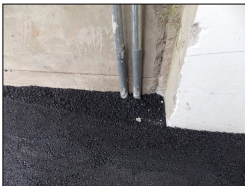
Fotografía 13. Zonas laterales compactadas con equipo menor.
