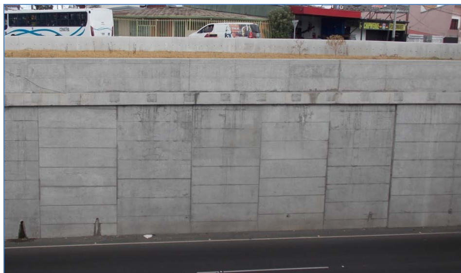
Fotografía 18. Salida de material fino por las grietas en el muro Norte. Fecha 07 de febrero de 2017. Fuente: LanammeUCR.
