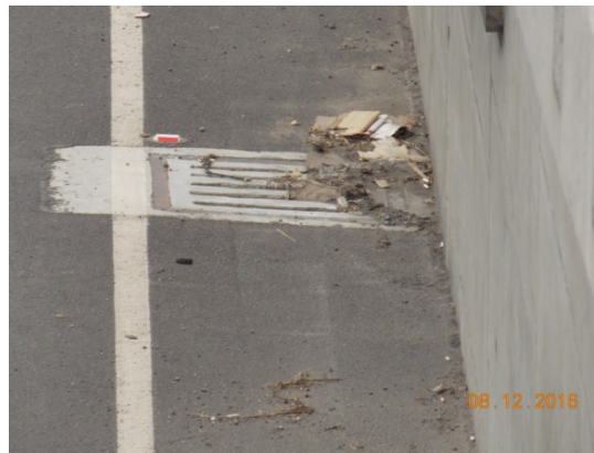
(b) Sedimentos y basura acumulados en la rejilla. Fecha: 08 de diciembre 2016
