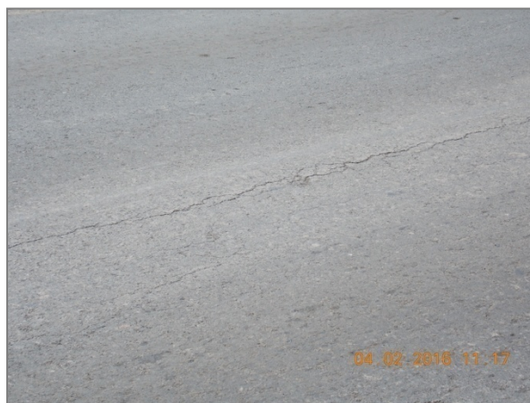
Fotografía 9. Grieta longitudinal en el Eje No. 5. Fecha: 4 de febrero de 2016. Fuente: LanammeUCR.
