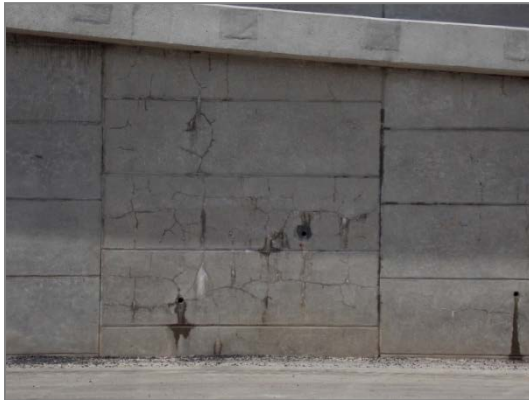
(a) Salida de material fino y agua por las grietas
