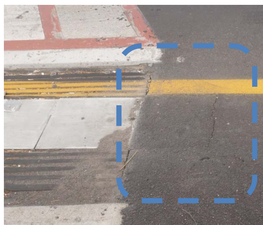
(b) Junta de expansión Norte del puente Este
