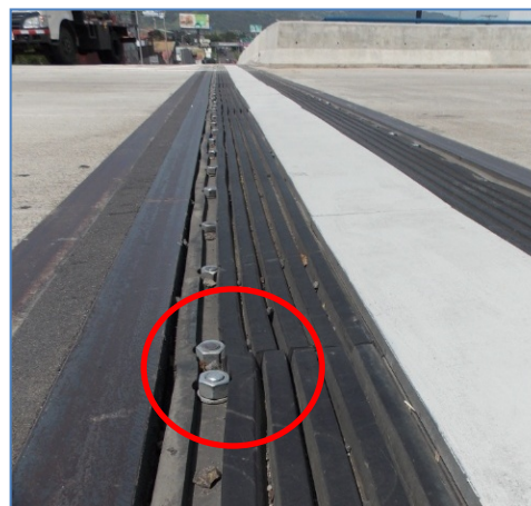
(b) Junta de expansión del puente Este
