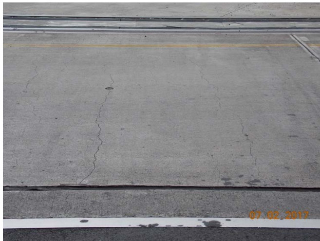
Fotografía 24. Condición de agrietamiento observada en la losa noroeste en el año 2017. Fecha: 7 de febrero de 2017. Fuente: LanammeUCR.
