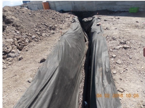
Fotografía 4. Construcción de sub-drenajes en el Eje No. 1 sector Oeste. Fecha 04 de febrero 2016. Fuente: LanammeUCR
