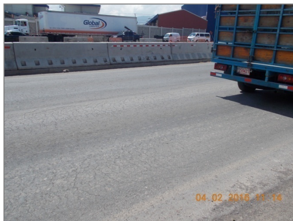
Fotografía 8. Agrietamientos tipo "cuero de lagarto" en el Eje No. 5. Fecha: 4 de febrero de 2016. Fuente: LanammeUCR.
