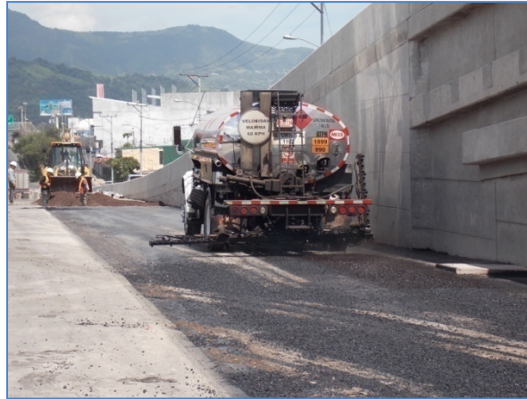
Fotografía 7. Aplicación de riego de liga y uso de "traba". Fecha: 5 de junio de 2016. Fuente: LanammeUCR.
