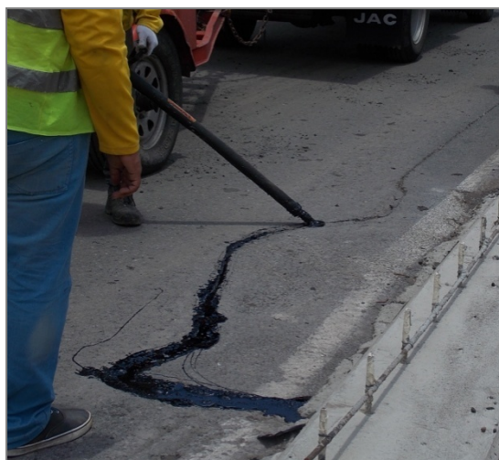
Fotografía 10. Sello de grietas en el Eje No. 6 (Rampa). Fecha 04 de agosto 2016. Fuente: LanammeUCR.
