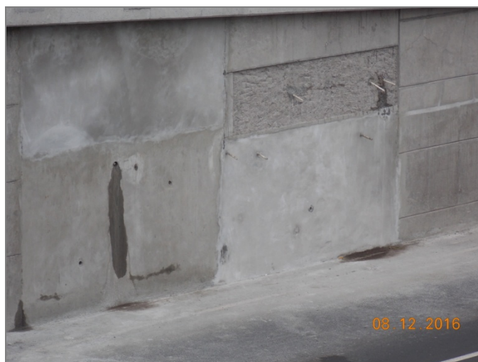
Fotografía 17. Reparaciones de los agrietamientos de los muros. Fecha 08 de diciembre de 2016. Fuente: LanammeUCR.
