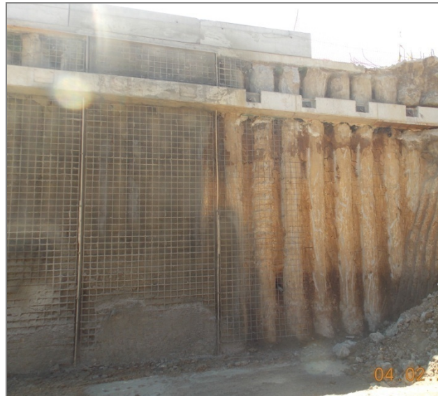
Fotografía 19. Etapa constructiva del muro de concreto lanzado. Fecha: 04 de febrero de 2016. Fuente: LanammeUCR.
