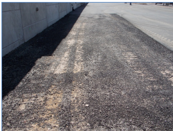
Fotografía 5. Capa delgada o "traba" durante la colocación de mezcla asfáltica en caliente.
