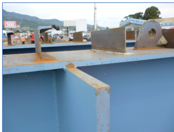
Fotografía 25. Bordes afilados y corrosión en las vigas de acero a colocar en el puente. Fecha 16 de julio de 2015. Fuente: LanammeUCR.
