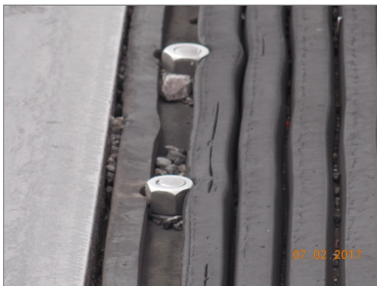
Fotografía 22. Deterioros en la junta sureste del puente. Fecha: 7 de febrero de 2017. Fuente: LanammeUCR
