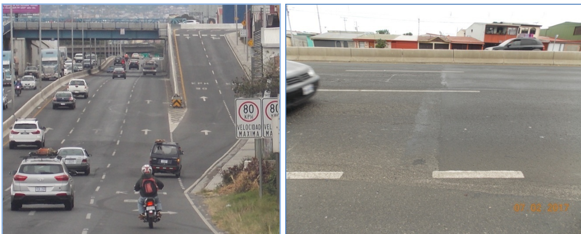
Fotografía 1. Inicio del tramo intervenido sector Oeste del viaducto. Fecha: 07-02-2017. Fuente: LanammeUCR
