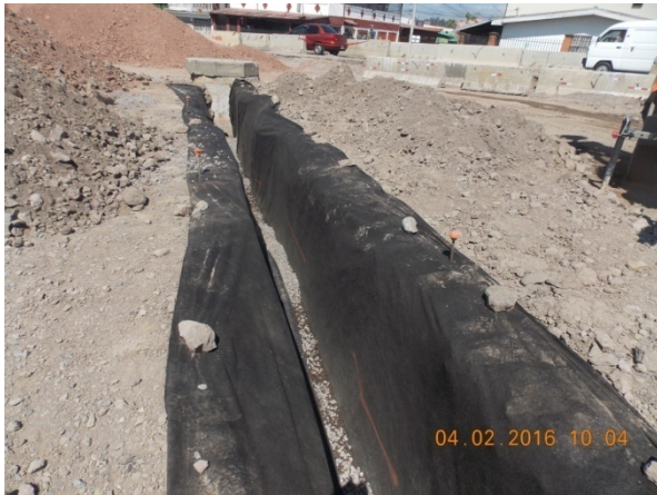
Fotografía 4. Construcción de sub-drenajes en el Eje No. 1 sector Oeste. Fecha 04 de febrero 2016. Fuente: LanammeUCR
