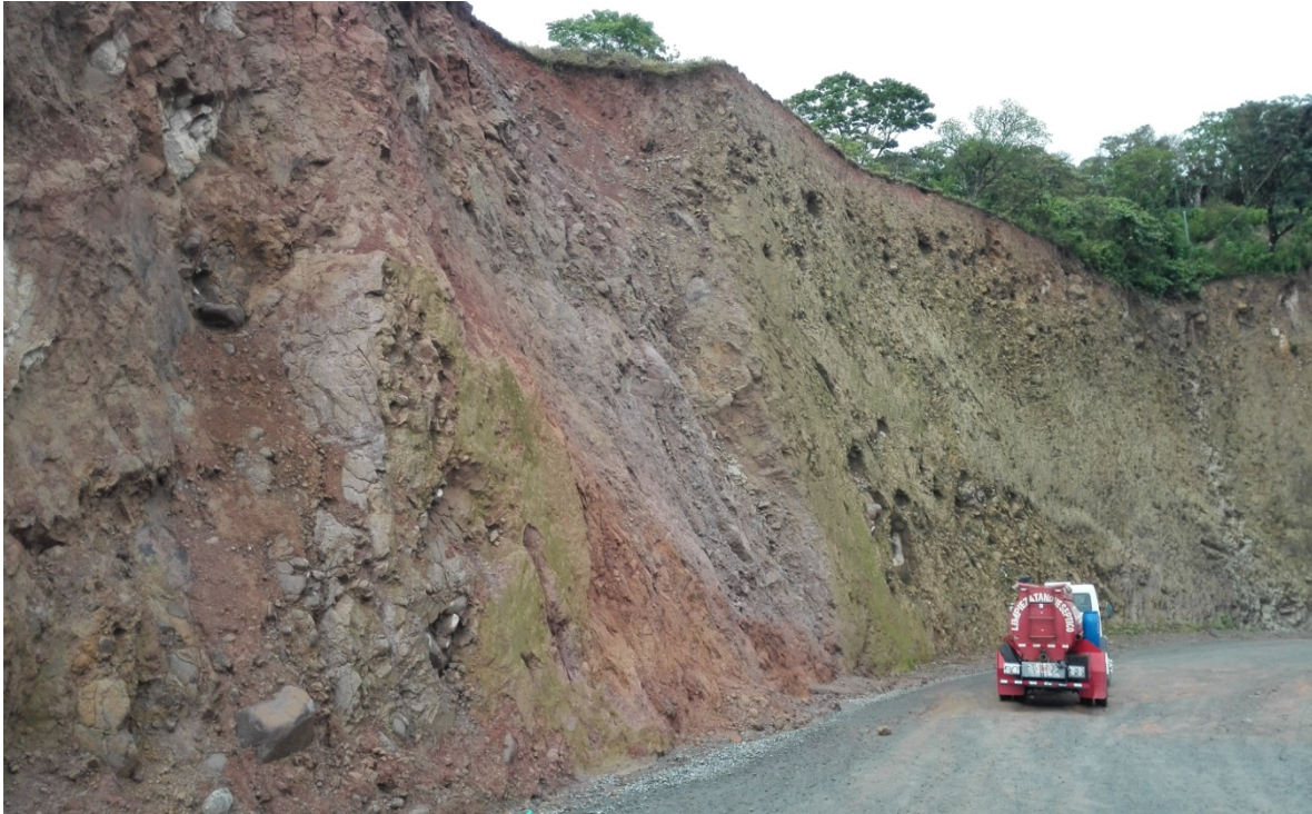
Figura 8. Talud de corte en estacionamiento km 22+000, lado derecho.
