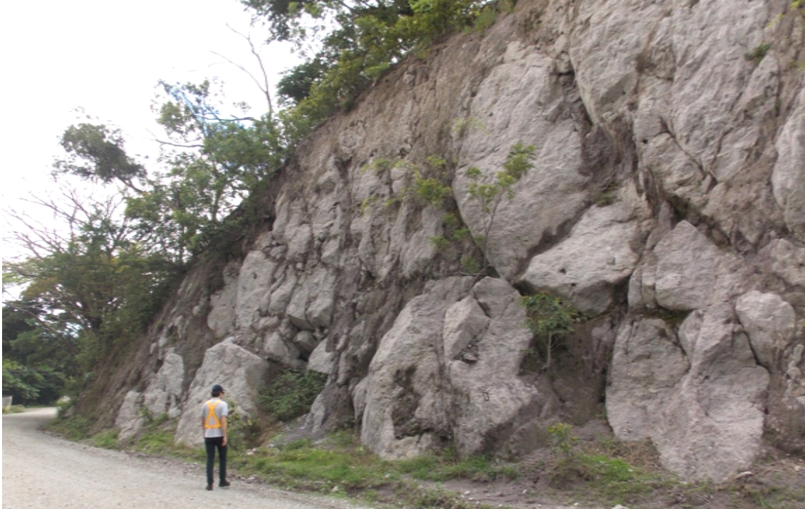
Figura 2. Talud de corte en estacionamiento km 10+700, lado izquierdo.
