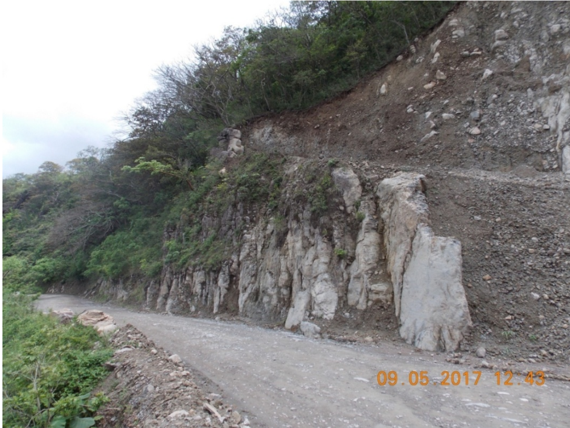
Figura 5. Talud de corte en estacionamiento km 13+500, lado izquierdo.
