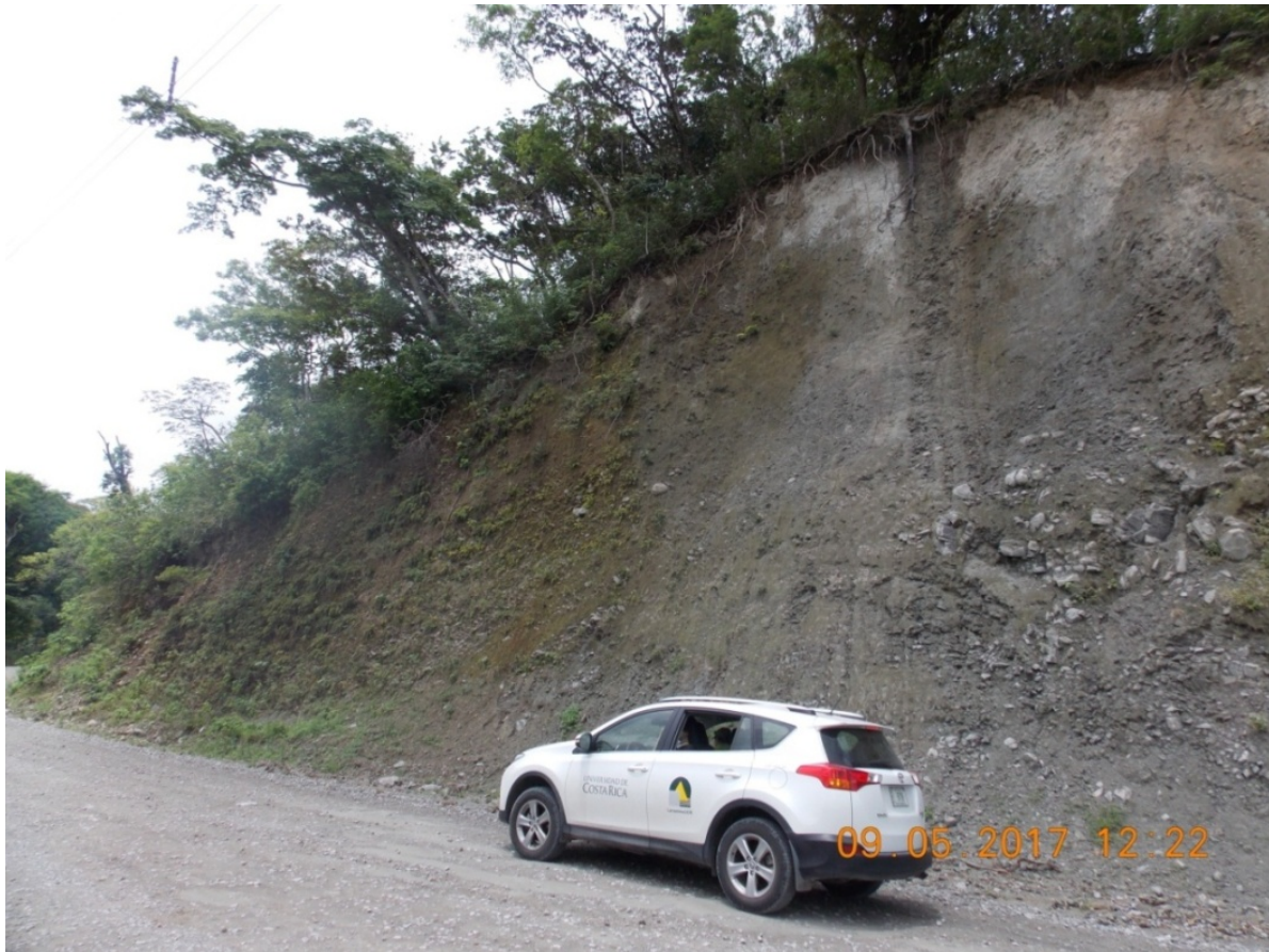
Figura 4. Talud de corte en estacionamiento km 12+950, lado derecho.
