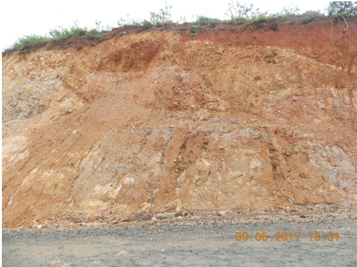
Figura 6. Talud de corte en estacionamiento km 15+774, lado izquierdo.
