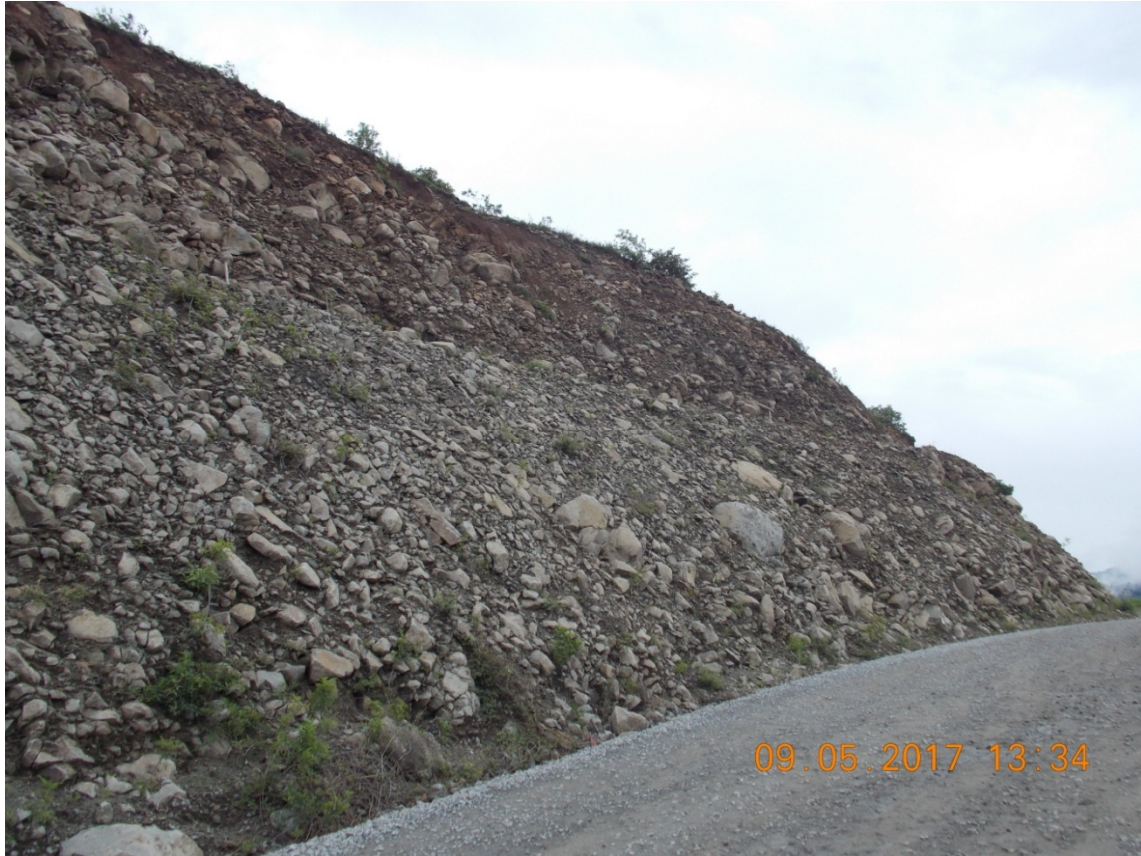
Figura 7. Talud de corte en estacionamiento km 16+260, lado izquierdo.
