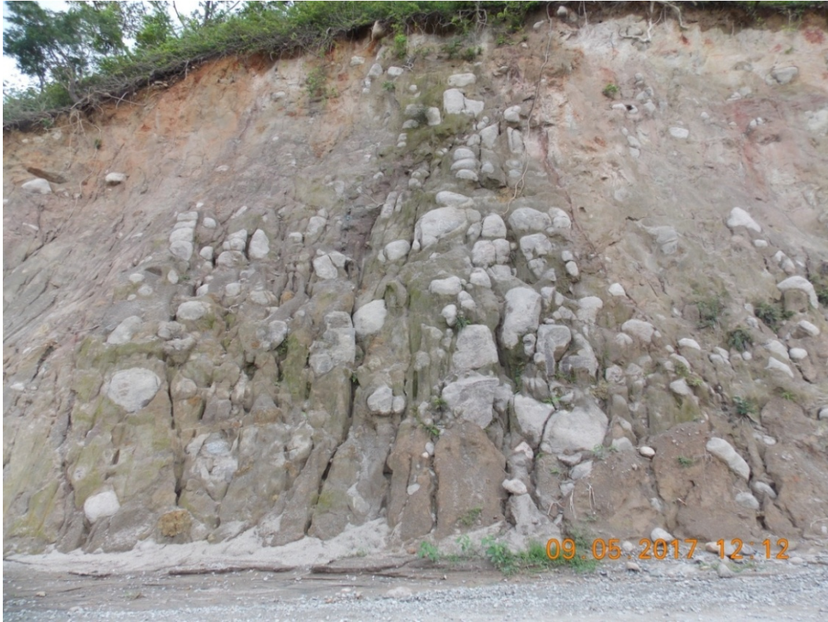
Figura 3. Talud de corte en estacionamiento km 12+000, lado izquierdo.
