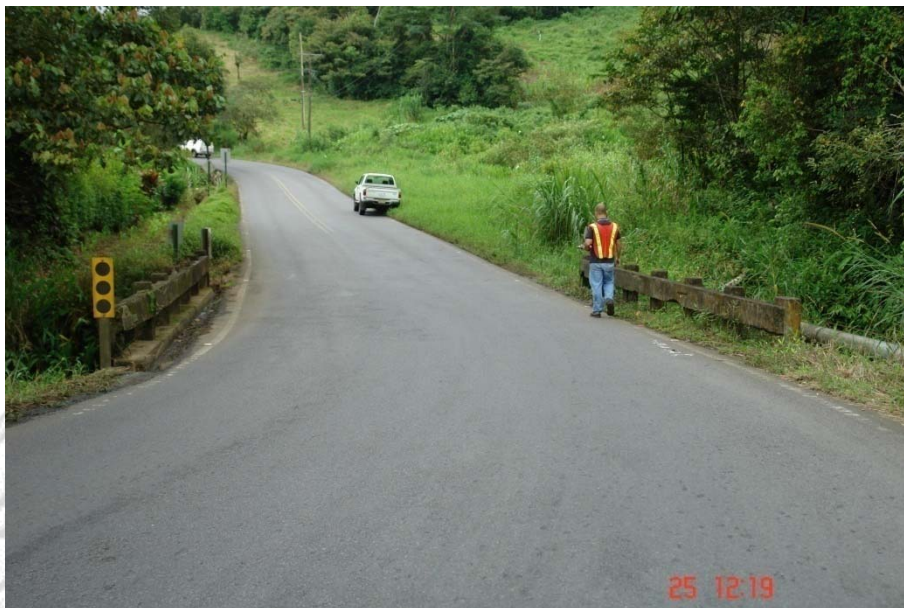
Figura 2. Vista a lo largo de la línea centro del puente sobre el río Leones.
