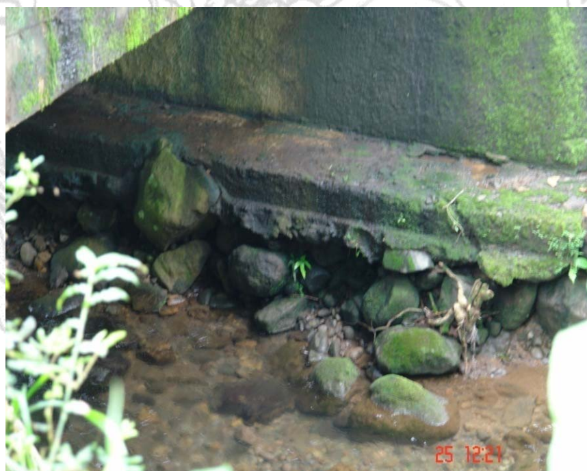
Figura 12. Socavación en la cimentación del bastión Oeste.
