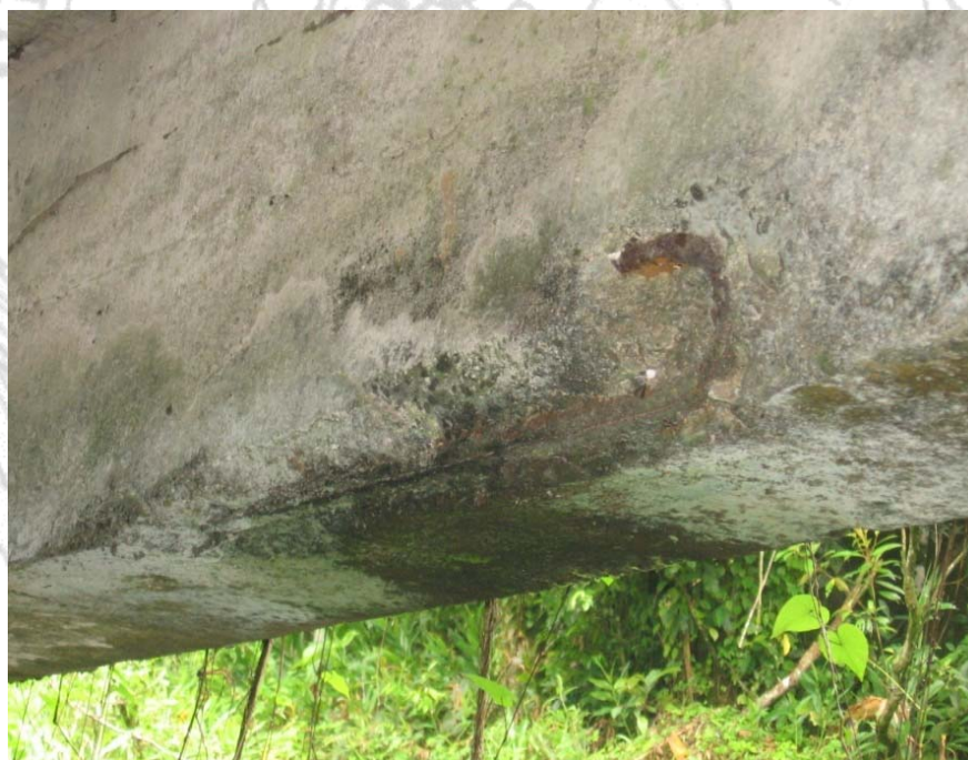
Figura 10. Acero expuesto por desprendimiento del concreto.
