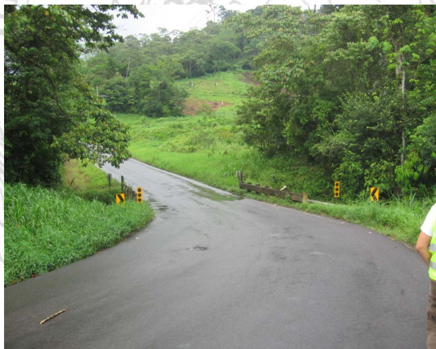
Figura 6. Señalización horizontal inexistente.
