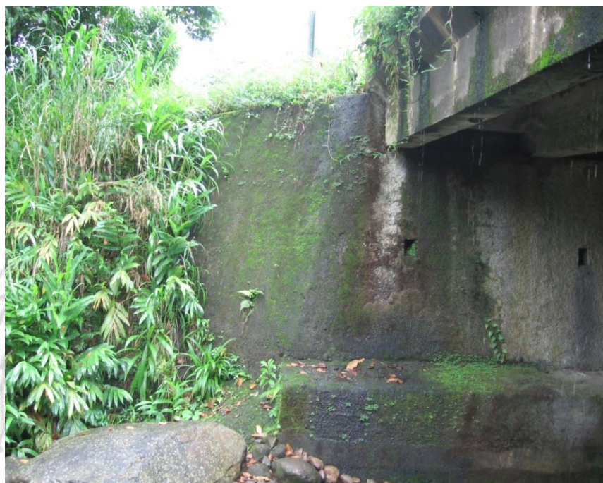
Figura 11. Presencia de humedad en bastiones y aletones debido a la inexistencia de un sistema de drenaje.
