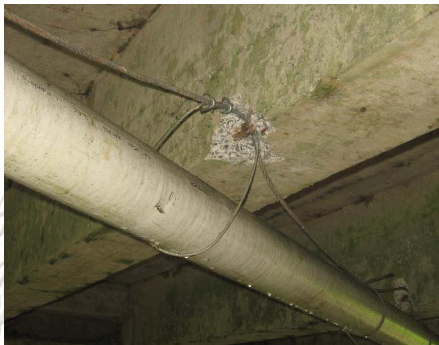
Figura 9. Tubería anclada en el acero de refuerzo de la viga.
