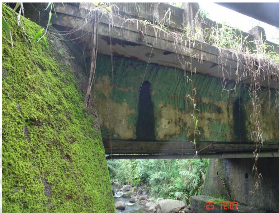
Figura 7. Drenajes de losa sobre las vigas externas.
