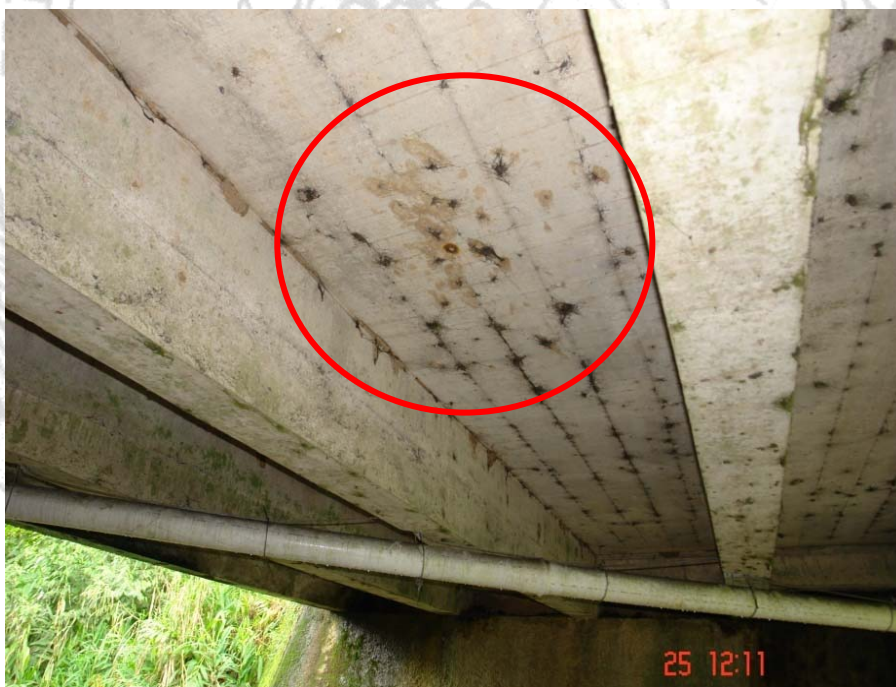
Figura 8. Manchas en la losa.
