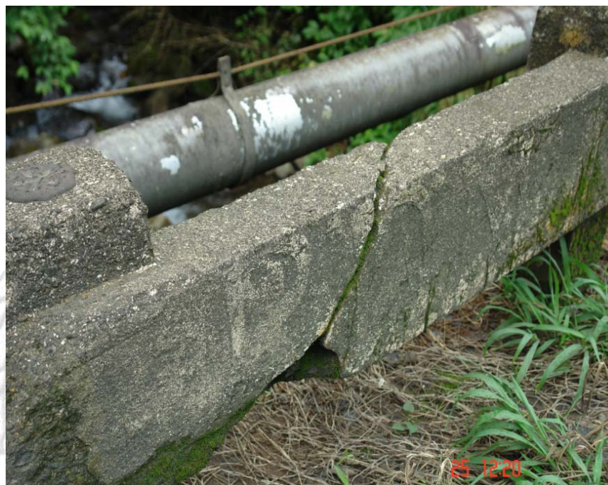
Figura 5. Agrietamiento en la baranda de concreto.
