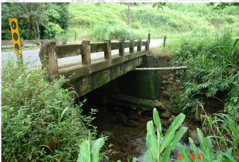
Figura 3. Vista lateral del puente sobre el río Leones.
