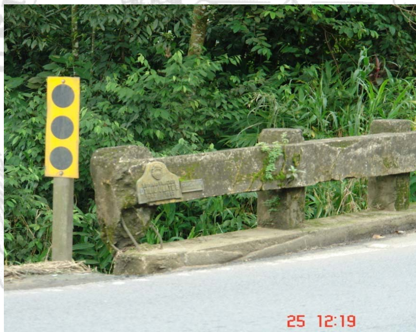
Figura 4. Daño en la baranda.
