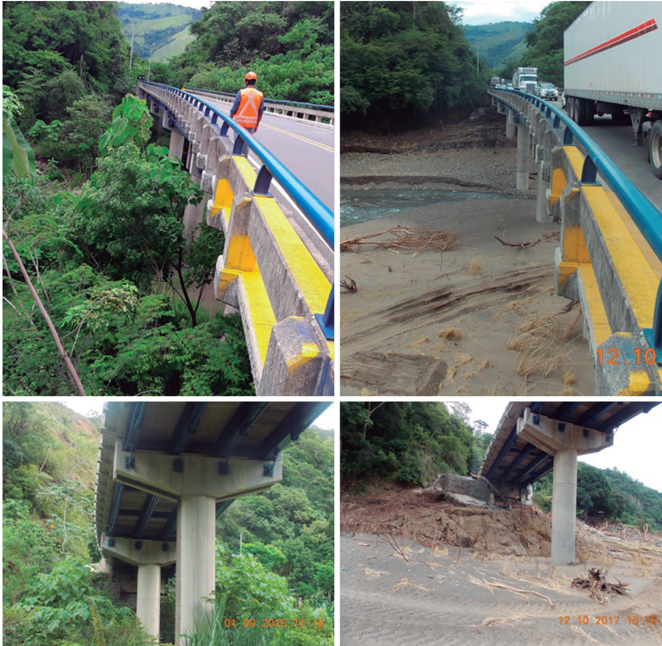
Figura 1. Fotografías comparativas entre un antes y un después de NATE, puente sobre el río Puerto Nuevo en RN 2
