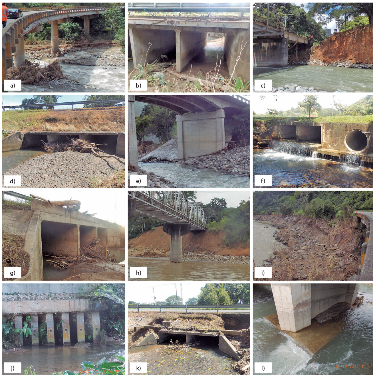
Figura 2. Tipo de afectaciones observadas: a) Afectación Cauce, b) Acumulación de Sedimentos Leve en Alc., c) Inestabilidad Terreno en Entorno, d) Obstrucción Alc., e) Daño en Protección Hidráulica, f) Socavación en Cimiento o Cabezal Alc., g) Agua Pasa sobre Alc., h) Inestabilidad frente a Bastión, i) Socavación en Relleno o Aletones, j) Socavación: Cimiento Profundo, k) Socavación y Daño en Alc., l) Socavación: Cimiento Superficial
