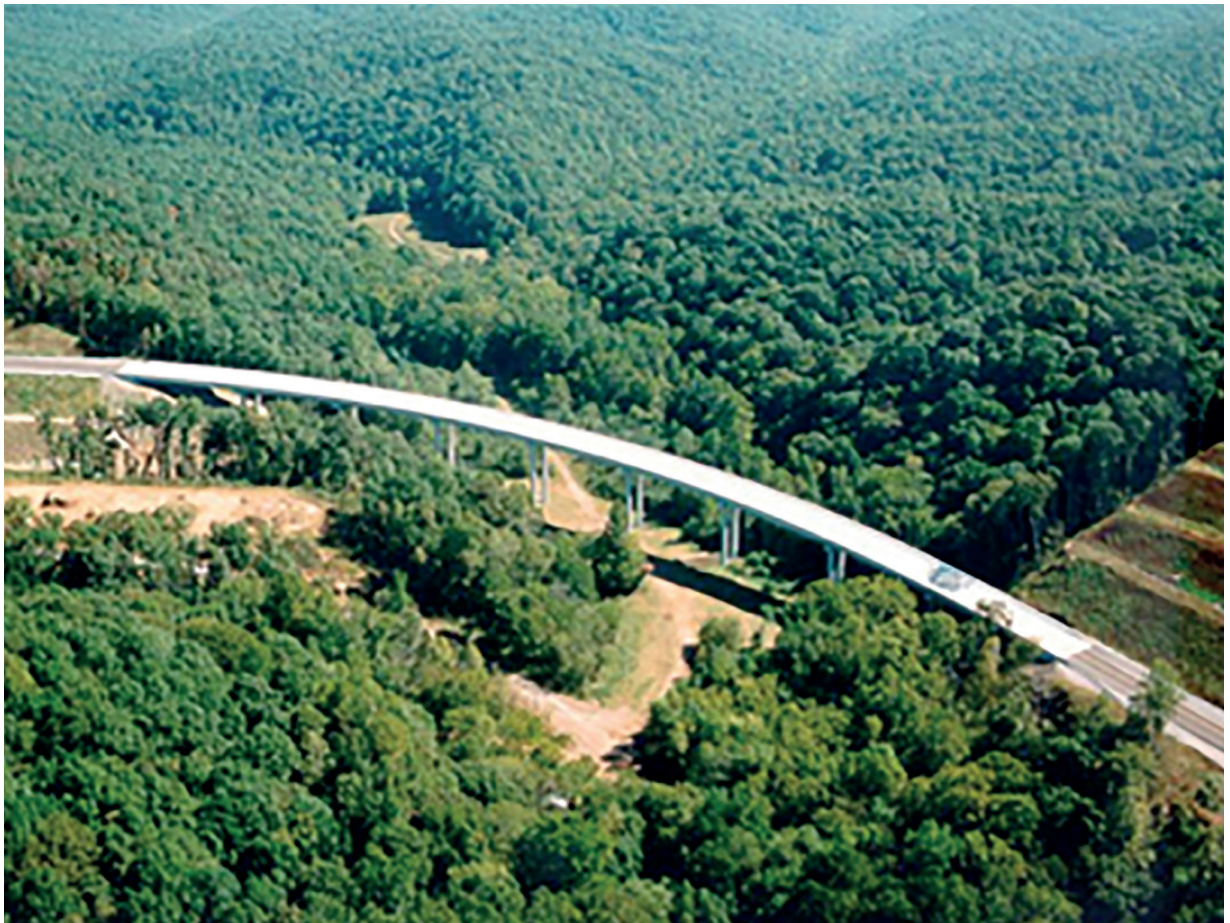
Figura 1. Puente integral Happy Hollow Creek en Tennessee, EUA. Estructura curva de concreto prefabricado con un largo de 358 m (Tomado de http://www.concretebridgeviews.com/i70/Article1.php )
