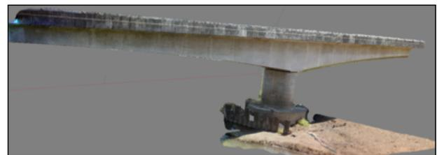
**Figura 3. Ejemplo de modelo 3D para pila del puente sobre el río Tárcoles resolución de imagen 8mm, resolución del modelo 1 m, Ruta Nacional 34**
