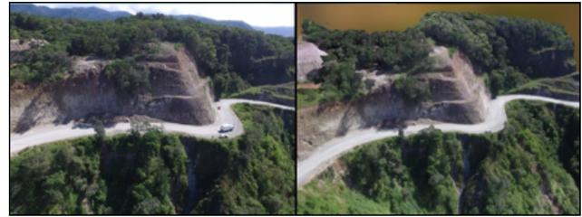
**Figura 9. A la izquierda fotografía oblicua de talud en la ruta nacional No 606 cerca de Santa Elena - Monteverde, a la derecha su reconstrucción en 3D con los datos obtenidos con el VANT, permitiendo reconocer y analizar en oficina los ángulos de los taludes y la pendiente de la ladera hacia el valle.**
