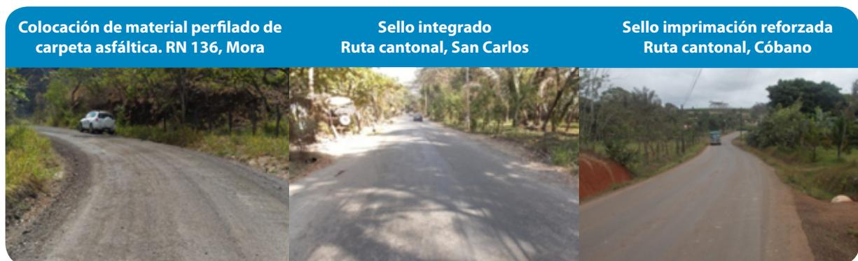
Figura 5. Productos asfálticos utilizados para impermeabilización, control de erosión y polvo.
