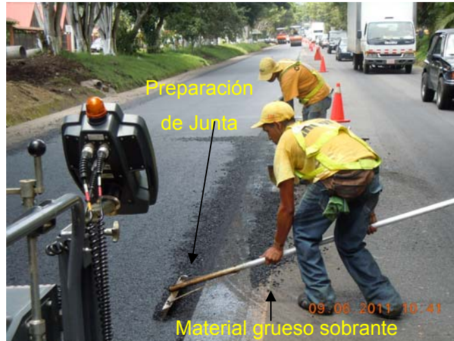
Fotografía 8. Preparación de junta longitudinal por medio de rastrillos. Fecha 6 de setiembre 2011. Sitio ubicado 300m hacia San José del cruce de Palmares. Fuente: Auditoría Técnica, LanammeUCR
