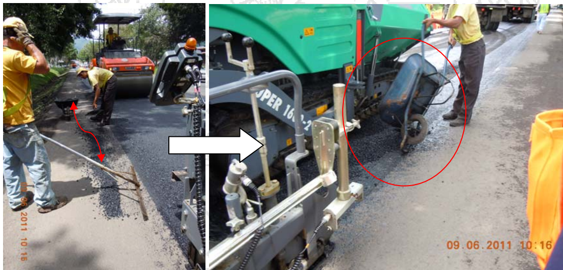
Fotografía 9. Depósito de material asfáltico sobrante delante de la pavimentadora. Fecha 6 de setiembre 2011. Sitio ubicado 300m hacia San José del cruce de Palmares. Fuente: Auditoría Técnica, LanammeUCR
