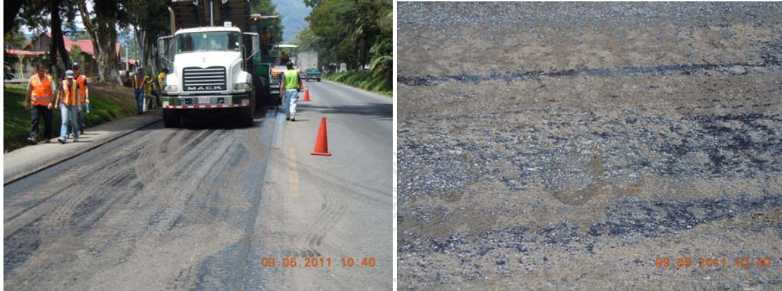
Fotografía 10. Riego de liga uniforme en la superficie antes de la colocación de la mezcla asfáltica. Fecha 6 de setiembre 2011. Sitio ubicado 300m hacia San José del cruce de Palmares. Fuente: Auditoría Técnica, LanammeUCR
