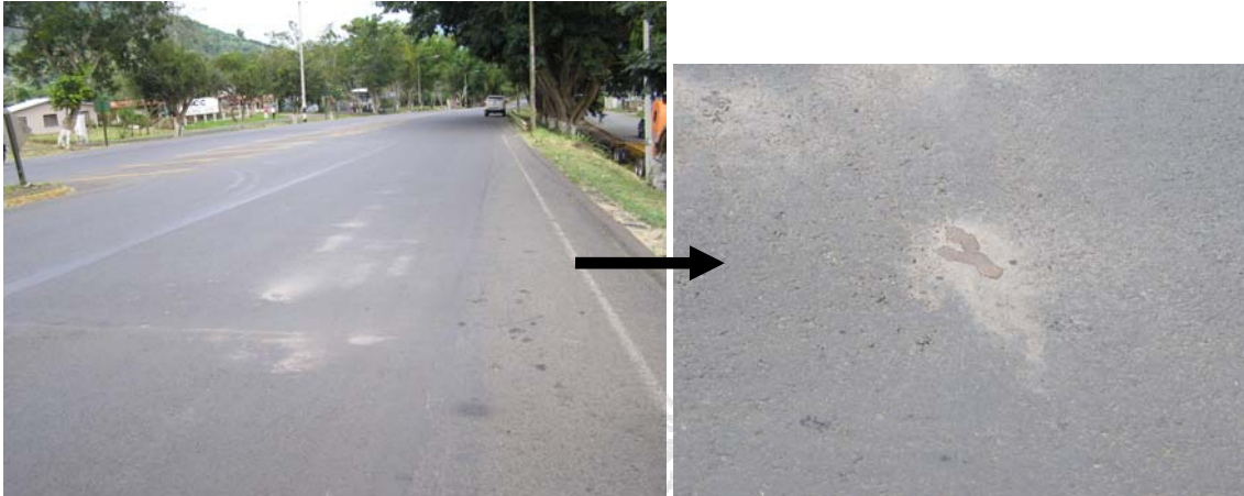
Fotografía 5. Condición de la superficie nueva luego de la colocación de la mezcla asfáltica sobre la superficie perfilada mostrada en la fotografía 4.
