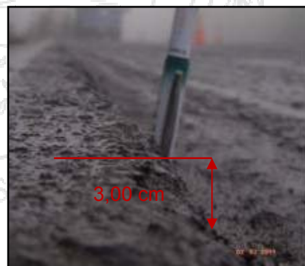
Fotografía 2. Profundidad de perfilado aproximada de 3,00 cm.
