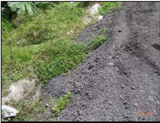
Fotografía 26: material de perfilado en cuneta obstaculiza flujo.
