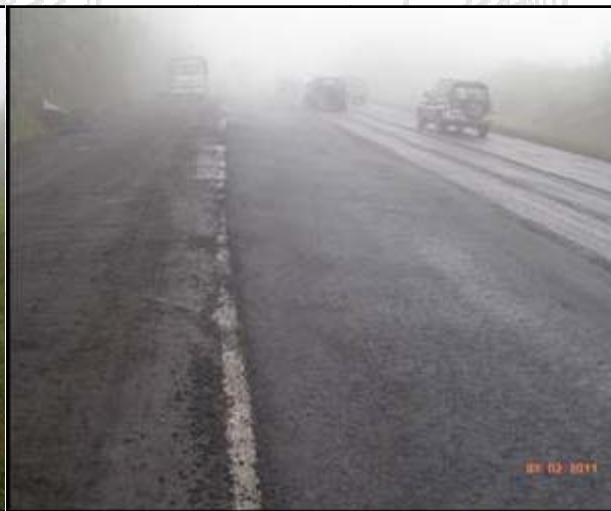
Fotografía 14. Mezcla asfáltica colocada el día anterior.
