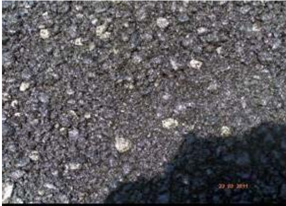
Fotografía 20. Mezcla contaminada con agregados del parqueo de un negocio privado.
