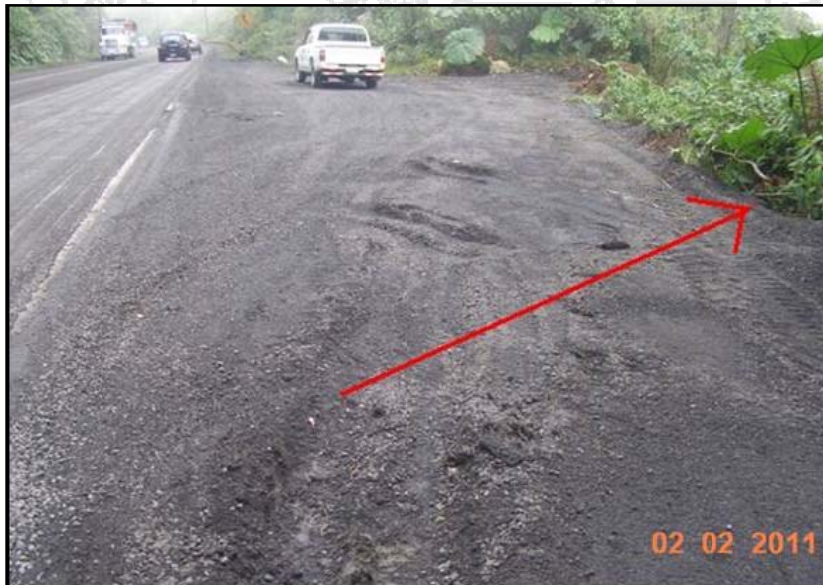
Fotografía 38. Zona de descanso no oficial, con material de perfilado.
