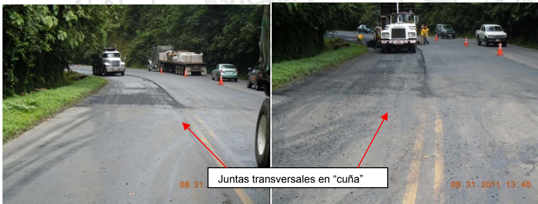
Fotografía 45: fotografías juntas transversales sin cortes verticales.
