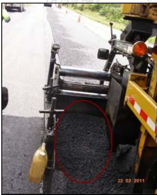
Fotografía 15. Extremo del distribuidor de mezcla donde se extrae material.
