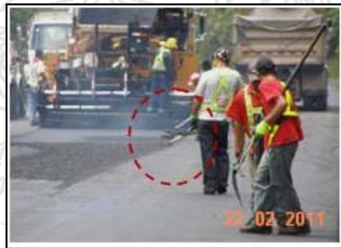
Fotografía 18. Trabajador lleva la pala con mezcla alterada al distribuidor de mezcla asfáltica.
