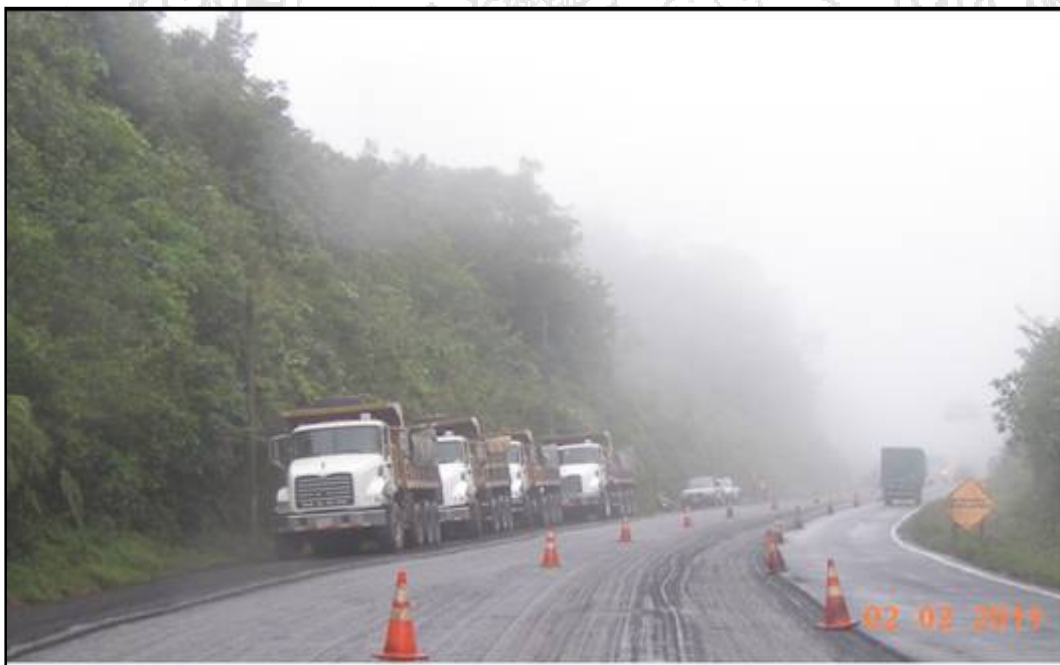
Fotografía 11. Cantidad de cuatro vagonetas con mezcla asfáltica, hora: 9:00am.
