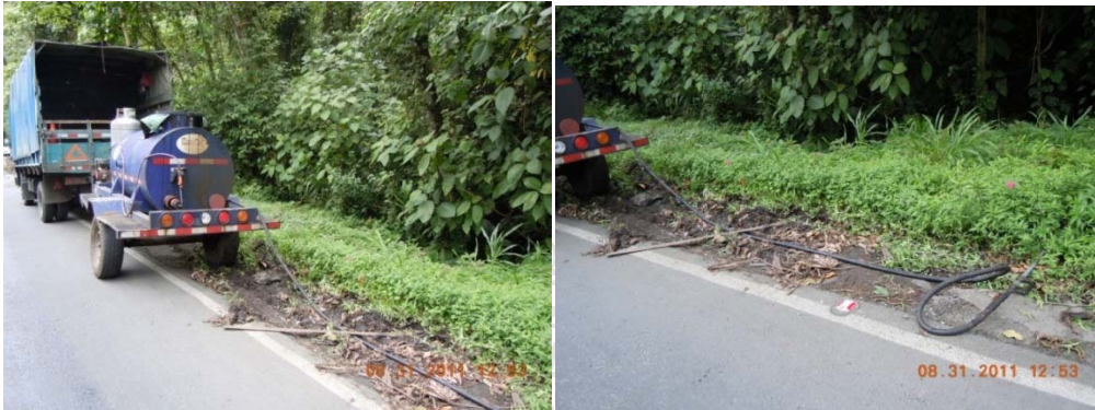
Fotografía 34: fotografías equipo utilizado para aplicar el riego de liga.
