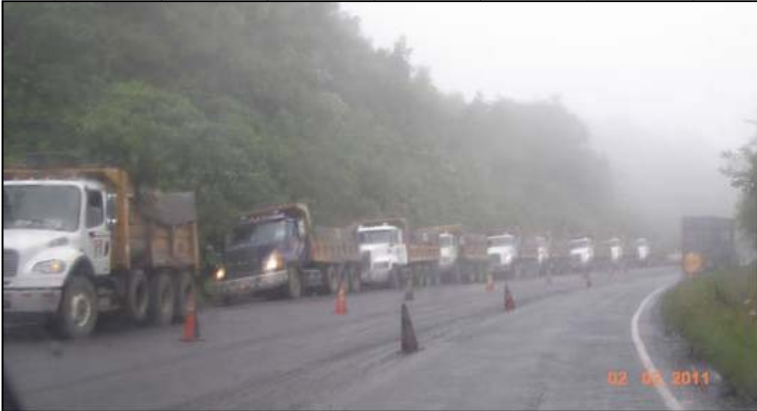
Fotografía 12. Cantidad de nueve vagonetas con mezcla asfáltica, hora: 12:00md.
