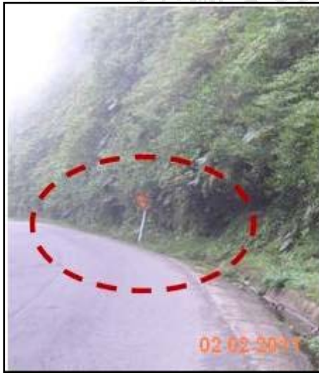
Fotografía 30: señal de "carril en construcción", oculta detrás de la vegetación.
