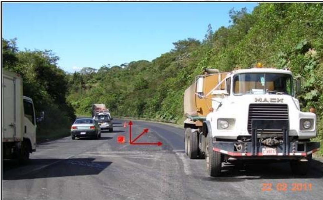
Fotografía 22. Carril del centro presenta una discontinuidad de peralte transversal.
