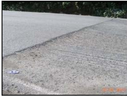
Fotografía 36. Cambio de nivel.
