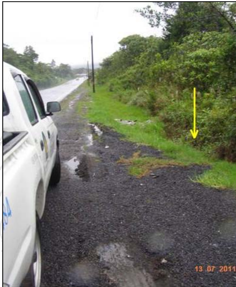
Fotografía 39. Zona de descanso no oficial, con material de perfilado y con una pendiente negativa pronunciada.
