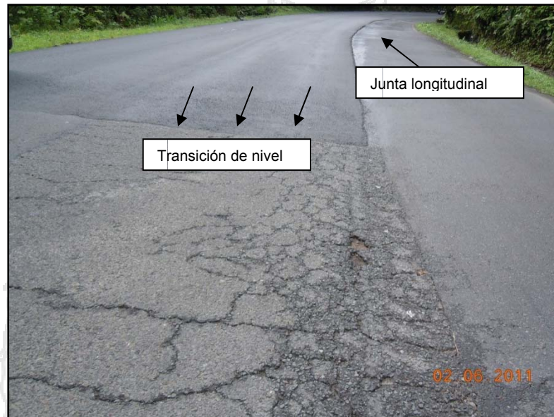
Fotografía 44: Transición de nivel al finalizar la colocación de una sobre capa.
