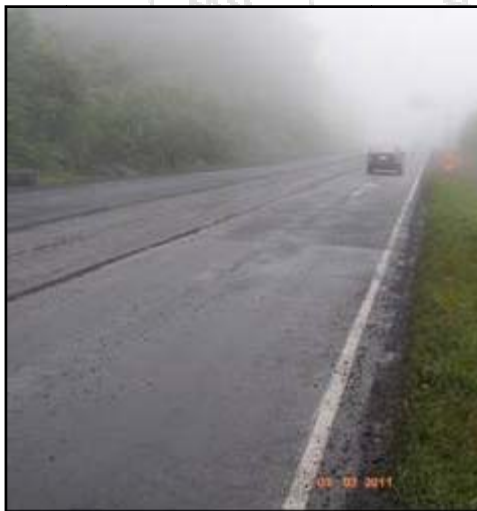
Fotografía 13. Mezcla asfáltica colocada el día anterior.
