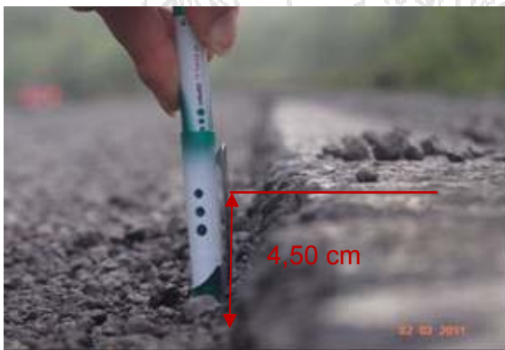
Fotografía 1. Profundidad de perfilado aproximada de 4,50 cm.
