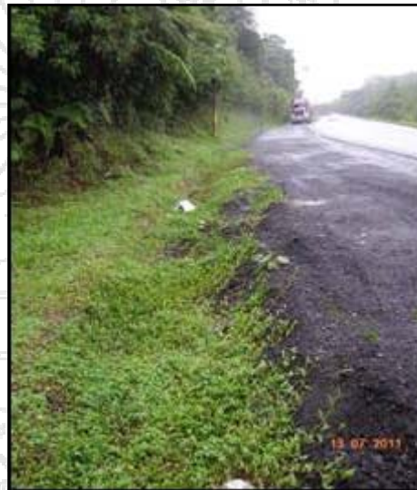
Fotografía 27: material de perfilado en la cuneta.
