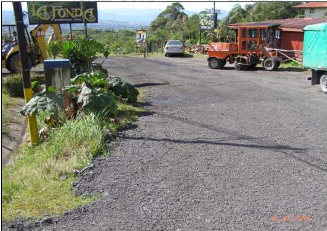
Fotografía 10. Parqueo privado donde se colocó material de perfilado.
