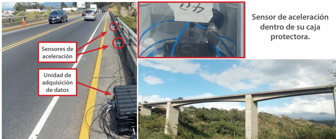
Figura 1. Toma de datos en el puente sobre el río Virilla en la Ruta Nacional No. 32. Nótese los sensores y las unidades de adquisición de datos de aceleración que se colocan sobre la acera y que no se interrumpe la operación del tránsito.
