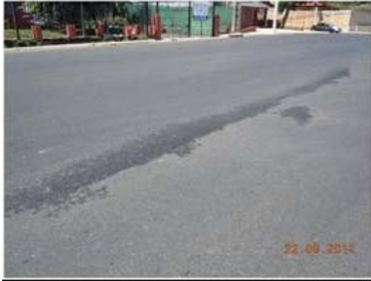
a. Mancha de agua de mayor extensión, estacionamiento 1+000, Fecha 22/set/2011
