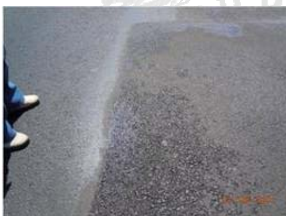
a. Mancha de agua, estacionamiento 1+900 Fecha 22/set/2011
