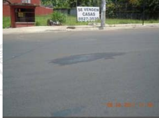
b. Mancha de agua, estacionamiento 1+185 Fecha 28/set/2011
