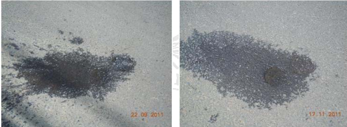
Figura 9. Imágenes de núcleo tapado con mezcla asfáltica por donde se produce filtración de agua.
