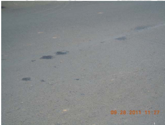
a. Mancha de agua, estacionamiento 2+703 Fecha 28/set/2011
