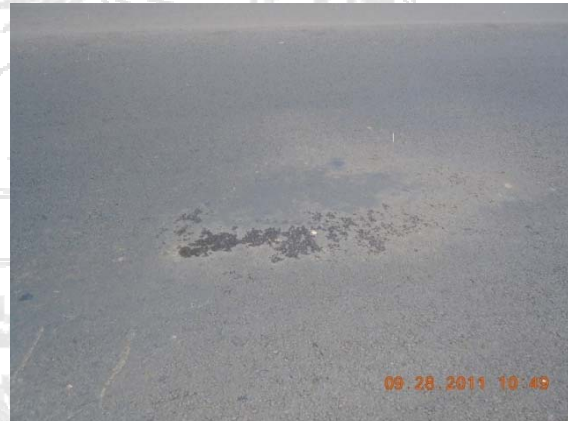
b. Mancha de agua, estacionamiento 3+600 Fecha 28/set/2011
