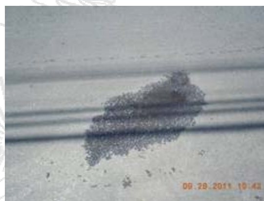
b. Mancha de agua, estacionamiento 4+370 Fecha 28/set/2011
