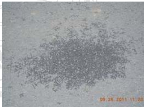
d. Mancha de agua, estacionamiento 2+703 Fecha 28/set/2011
