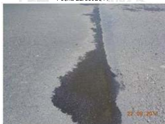
c. Mancha de agua, estacionamiento 1+900 Fecha 22/set/2011
