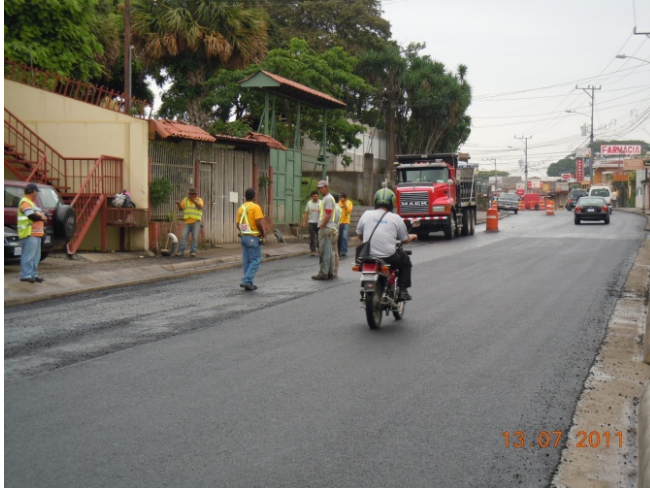
Fotografía 7 y 8. Colocación de carpeta asfáltica. Fecha de las visitas 13/07/2011 y 25/08/11
