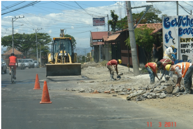
Fotografía 14 y 15. Frentes de trabajo sin zona de control temporal y canalización del tránsito Fecha 11/03/2011
