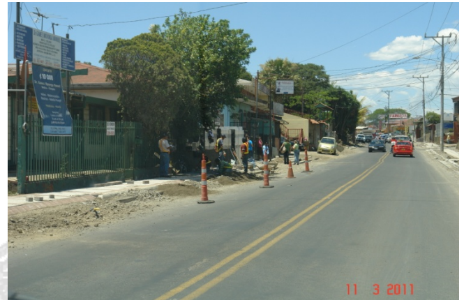
Fotografía 14 y 15. Frentes de trabajo sin zona de control temporal y canalización del tránsito Fecha 11/03/2011
