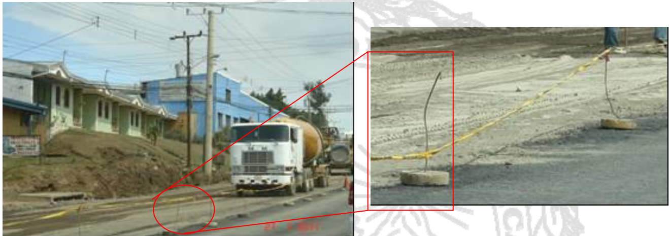
Fotografía 24 y 25. Elementos canalizadores. Fecha 27/01/2011
