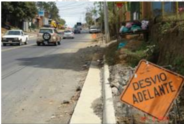
Fotografía 22. Señalización inconsistente. Estacionamiento 4+296 Fecha 27/01/2011
