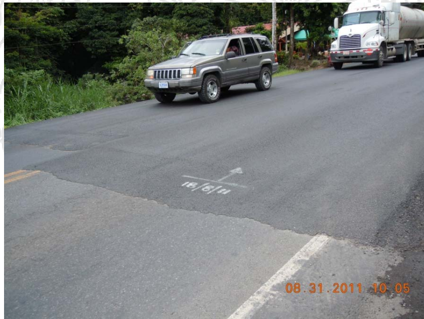
Fotografía 3. Inicio de la segunda sobrecapa de 1km de longitud. Fuente: Auditoría Técnica, LanammeUCR
