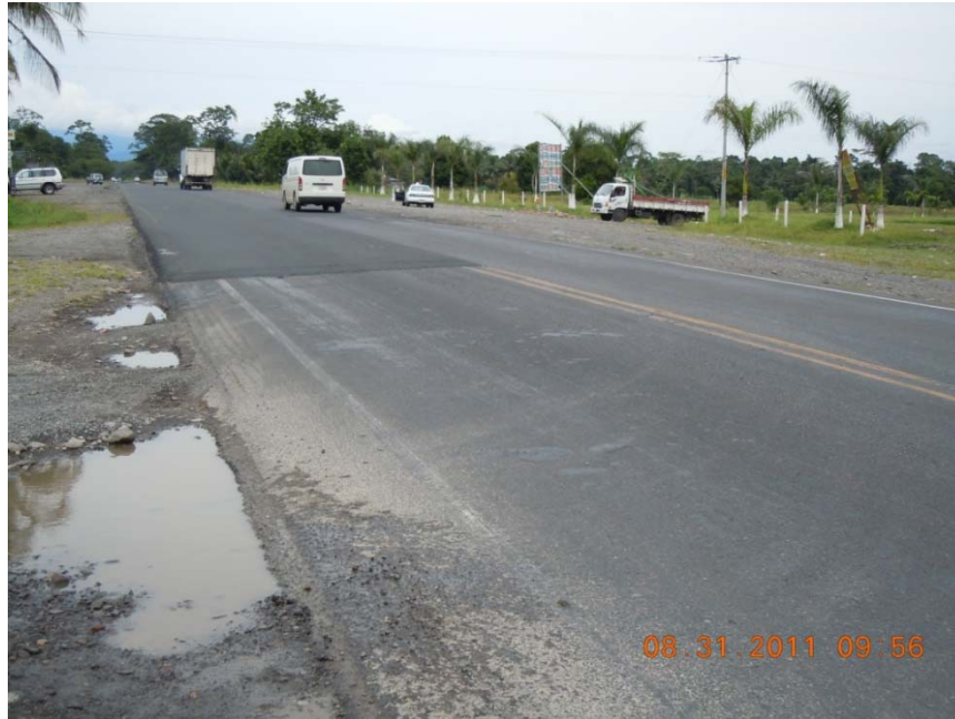
Fotografía 2. Final de primera sobrecapa de 10,80km de longitud. Fuente: Auditoría Técnica, LanammeUCR
