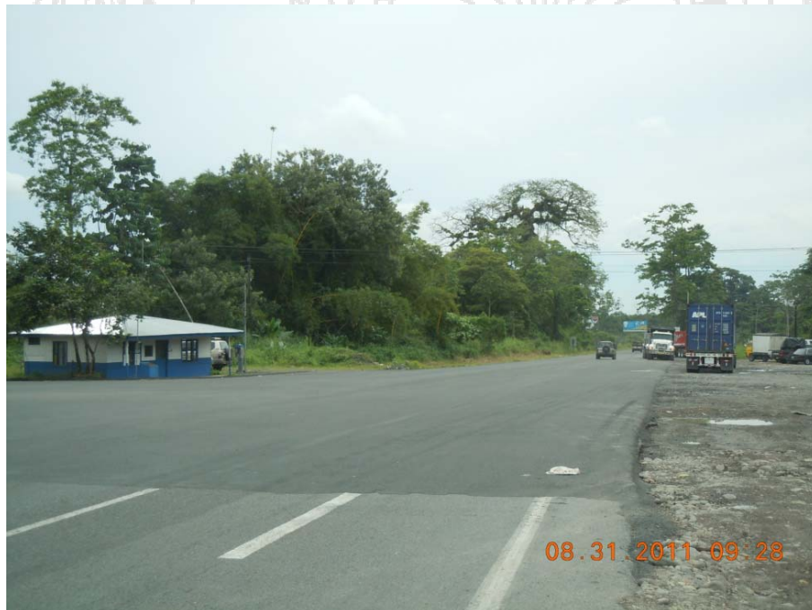
Fotografía 1. La intersección con la Ruta Nacional No.4 es el inicio de primera sobrecapa de 10,80km de longitud.
