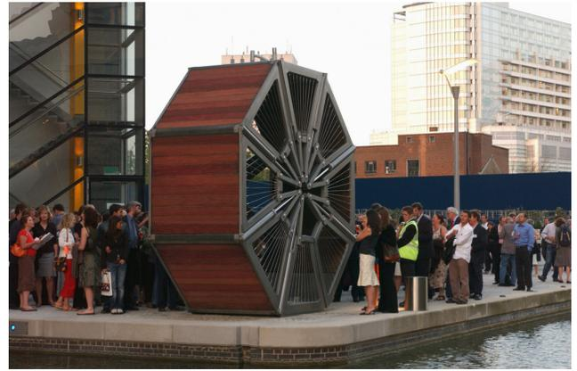
Figura 6. Configuración cerrada del puente, convergencia de los pasamanos
