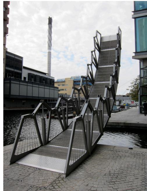
**Figura 3. Forma de arco del puente cuando éste se enrolla o desenrolla**
