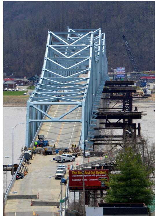
Figura 5. Reemplazo del puente Milton-Madison sobre el río Ohio con el método de construcción por deslizamiento
