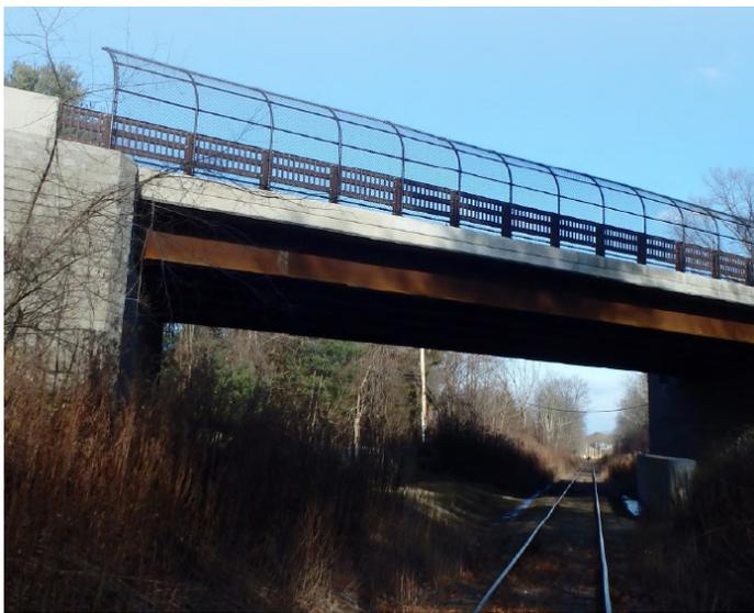
Figura 7. Puente de la Ruta Estatal 7A, Massachusetts, construido con la tecnología GRS-IBS
