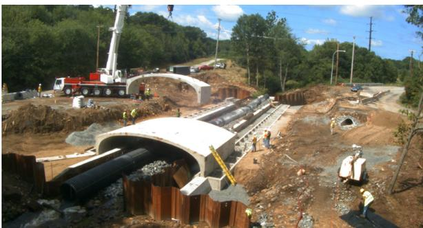
c) Colocación de elementos modulares de la nueva superestructura
