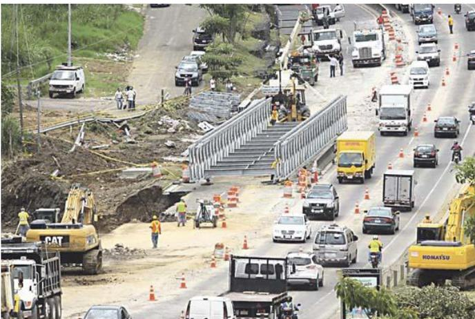
Figura 2. Falla en alcantarilla de la vía de Circunvalación, sector de Hatillo 8, San José, que obligó a colocar puentes Bailey
