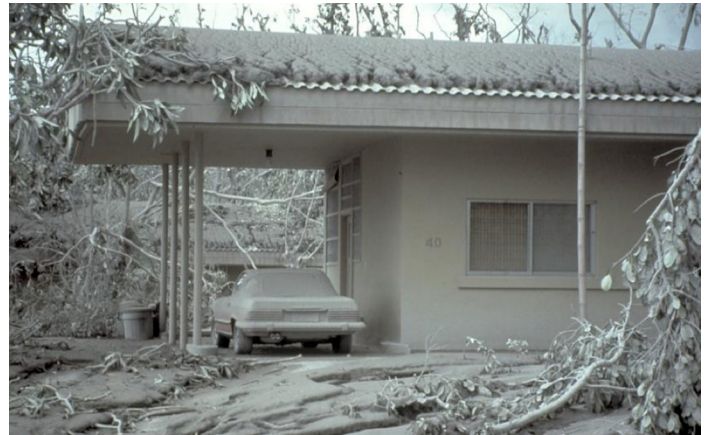
Figura 3. Techos de luz corta son menos propensos al fallo por acumulación de ceniza. Se muestra una casa de habitación, que no colapsó, por acumulaciones de ceniza por la explosión del volcán Pinatubo, Filipinas, 1991 Fuente: (USGS, 2010)
