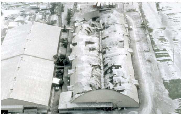
Figura 2. El colapso de techos por el peso de la ceniza durante la erupción del volcán Pinatubo, Filipinas, 1991, provocando la muerte de 300 personas Fuente: (USGS, 2010)
