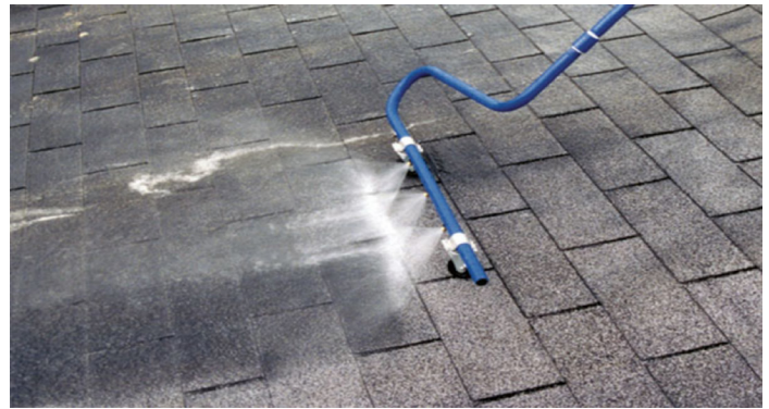
Figura 5. En exteriores, es recomendable remover los residuos finales de ceniza usando agua a presión controlada
