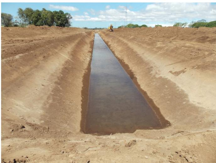
Figura 5. Excavación del canal
