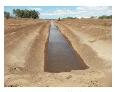
Figura 5. Excavación del canal
