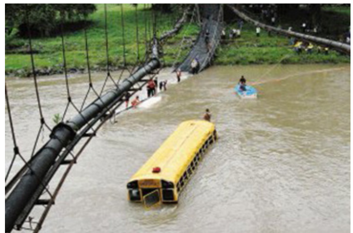
Figura 1. Colapso de Puente de Turrubares.
