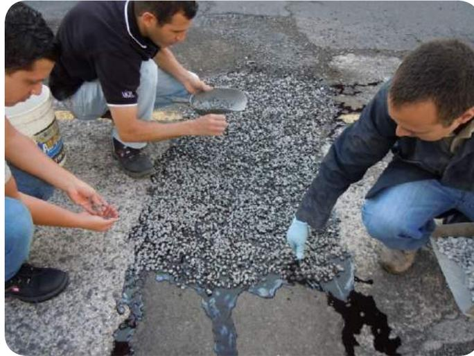
**Figura 4.** Tratamiento superficial simple construido con emulsión CRS-1 en las afueras del LanammeUCR
