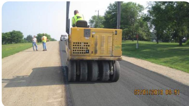
**Figura 14.** Compactación del material de secado
