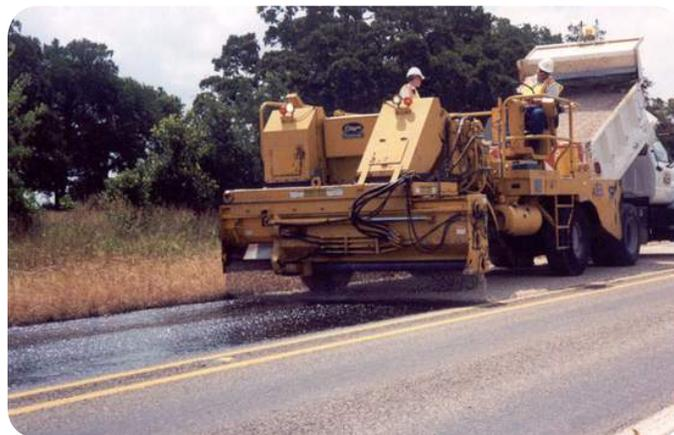
**Figura 10.** Equipo distribuidor de agregado
