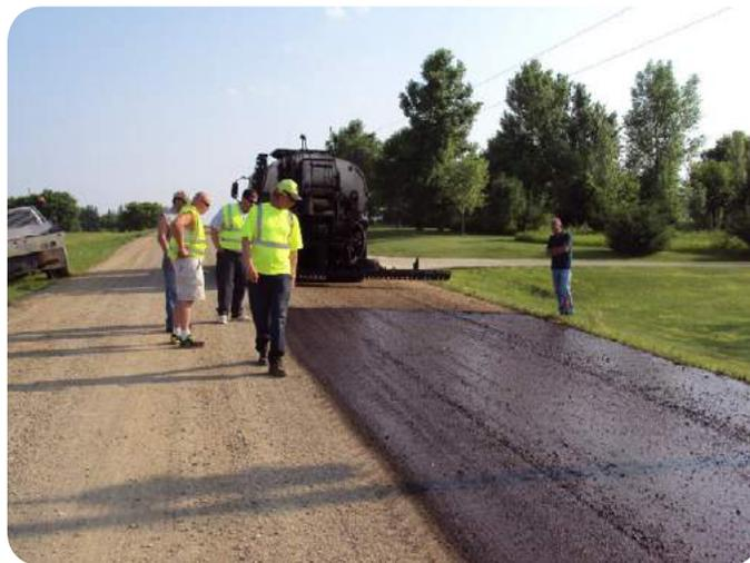
**Figura 8.** Aplicación de la capa de imprimación
