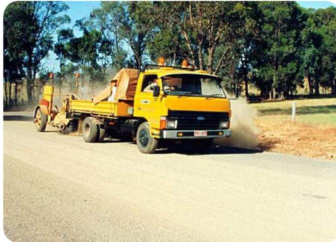
**Figura 7.** Barrido de la base, previo a la colocación de la capa de imprimación
