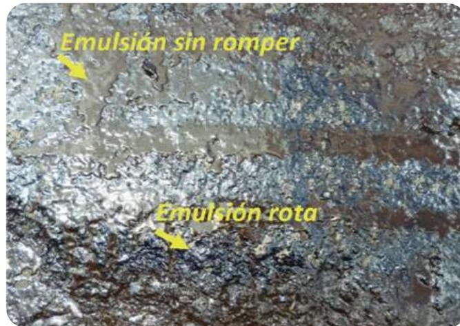
**Figura 9.** Emulsión asfáltica en proceso de curado
