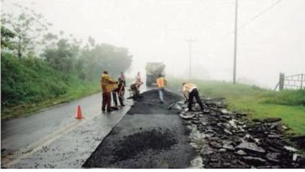
Nunca se debe colocar mezcla asfáltica bajo condiciones de lluvia.
