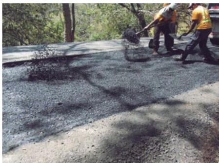
La mezcla asfáltica no se debe lanzar, ya que esto provoca segregación térmica y separa las partículas finas de las gruesas afectando la calidad y la durabilidad de la capa colocada.
