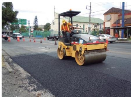
En caso de que el bache sea de grandes dimensiones se realizará la compactación mediante la utilización de un compactador vibratorio de rodillo. Se sigue el patrón de compactación y el proceso se realiza en franjas.
