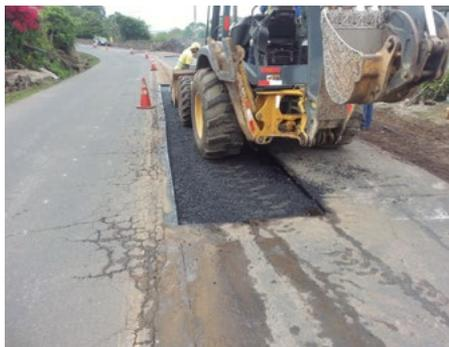
El "Back Hoe" circula encima de la mezcla asfáltica recién colocada. Las llantas contaminan y perjudican la adherencia entre las capas de mezcla asfáltica en caliente. Se nota el agrietamiento en las áreas adyacentes. Además cabe recalcar que ni el back hoe ni las vagonetas son equipo para la compactación de la mezcla asfáltica.
