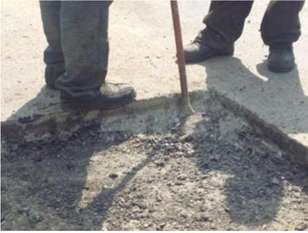
Se observa el afinado de esquinas y paredes del bache con una barra para que sean totalmente verticales, puede realizarse mediante un pico.
