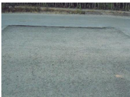
Malas condiciones de compactación de las diferentes capas del bache podrían provocar hundimientos importantes. La acumulación de agua puede ocasionar hidroplaneo.
