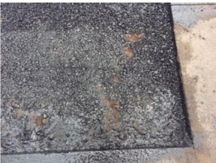
Bache colocado en 2 capas. Contaminación de la primera capa sobre la cual se colocará la segunda para completar el espesor total del bache. La adherencia entre capas de mezcla asfáltica se ve perjudicada y además el espesor no cumple el mínimo adecuado.
