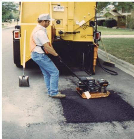
Compactación de mezcla asfáltica recién colocada mediante la utilización de una plancha compactadora.
