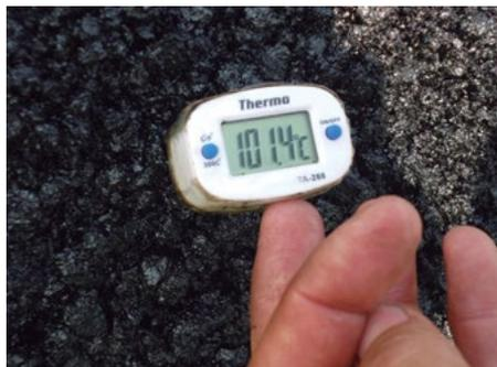
Comprobación de la temperatura de la mezcla asfáltica antes de la compactación se realiza en cada descarga. Cada comprobación de temperatura de la mezcla asfáltica caliente debe encontrarse dentro del rango establecido en el contrato.
