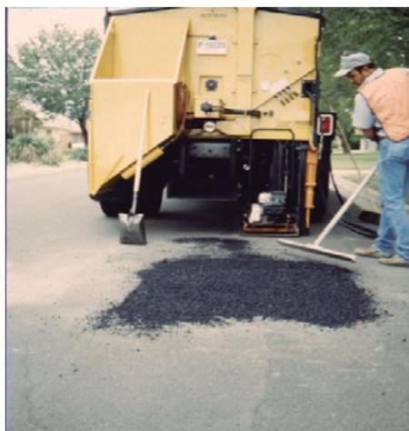
Afinado de la superficie del bache mediante un rastrillo, el cual debe limpiarse con un solvente. Para evitar que el solvente afecte la mezcla asfáltica se recomienda que el rastrillo u otro elemento como palas, picos o barras se utilicen completamente secos.
