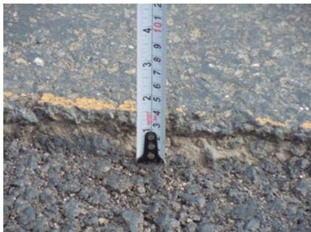
El bache terminado se encuentra aproximadamente 3 cm por debajo del nivel original de la superficie de rodadura. El bache debe mantener las condiciones originales de la superficie de la carretera, considerando incluso el bombeo necesario.
