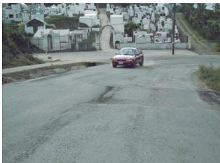
Superficie de ruedo irregular producto de la construcción de diferentes baches con mal acabado.
