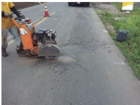
Equipo de sierra con disco de diamante para realizar el corte del bache.
