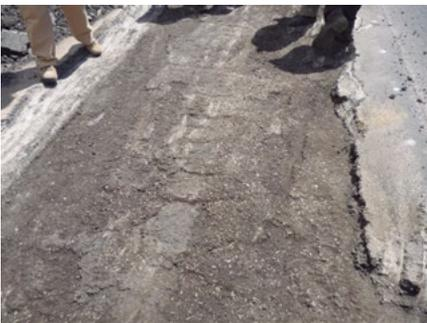
La superficie del bache es irregular. Además, los agrietamientos observados se pueden reflejar en la nueva mezcla asfáltica. Por otro lado, las paredes del bache no fueron cortadas adecuadamente. Es necesario verificar el espesor mínimo.
