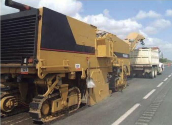
Figura 10. Escarificado de capa existente
