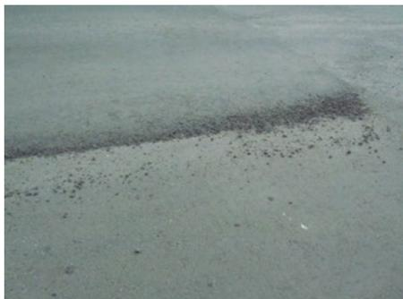
Se debe evitar que la mezcla sobresalga de la superficie original de ruedo. Se debe verificar el nivel mediante el uso de un codal.
