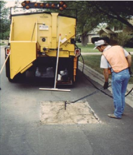
Limpieza de la superficie del bache mediante un compresor de aire.
