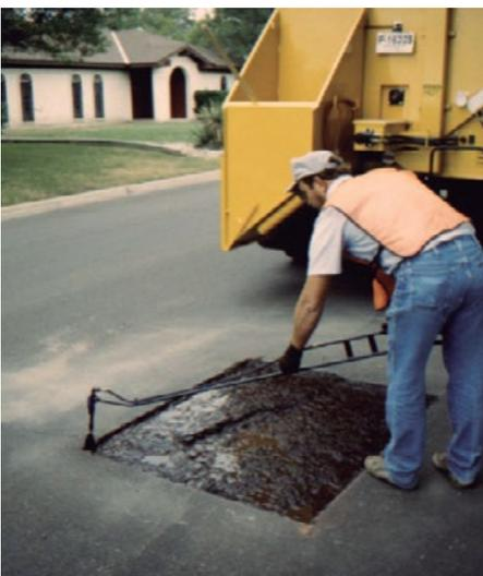
Aplicación del riego de liga. La aplicación es uniforme y homogénea. Verificar que las paredes del corte del bache queden impregnadas uniformemente del riego de liga.
