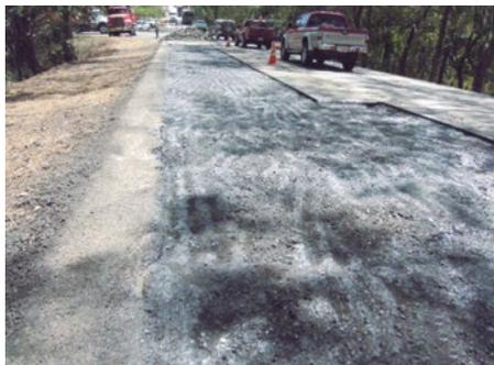
La superficie del bache es irregular. La superficie no está completamente limpia de material suelto. Al existir variaciones considerables de espesor, la compactación podría no ser homogénea.
