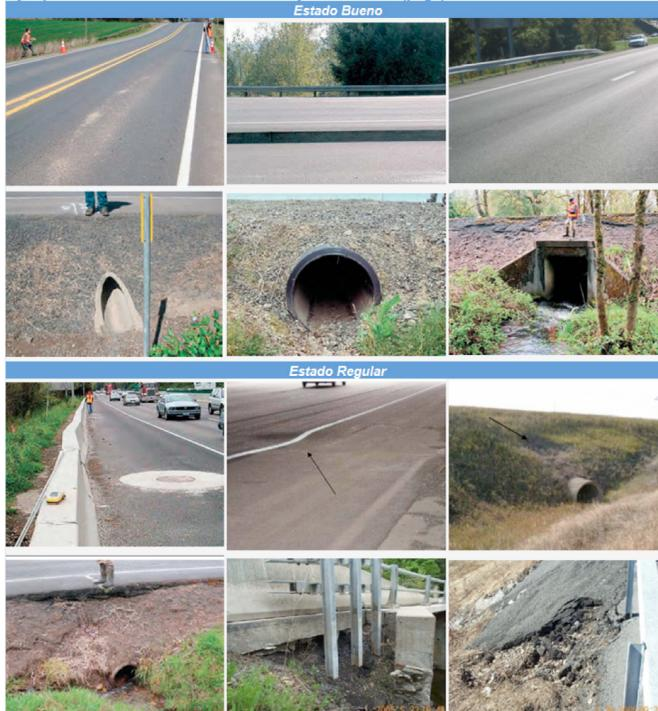
Figura 24. Complemento fotográfico para la inspección de la carretera y el terraplén(1).
