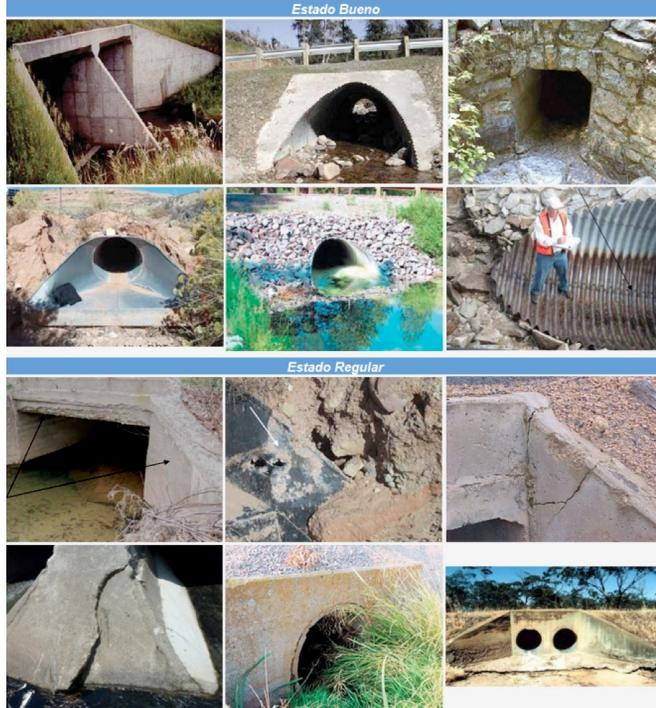
Figura 22. Complemento fotográfico para la inspección de obras de entrada y salida(1).
