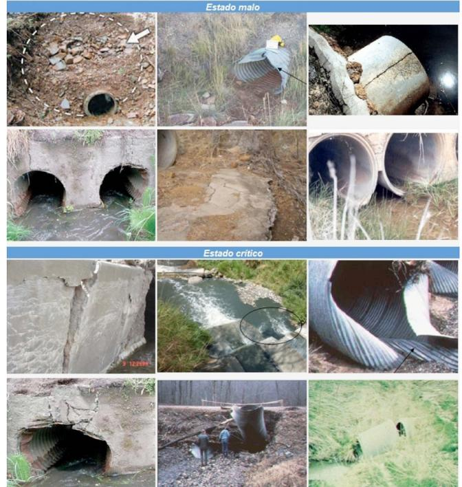
Figura 23. Complemento fotográfico para la inspección de obras de entrada y salida(2).
