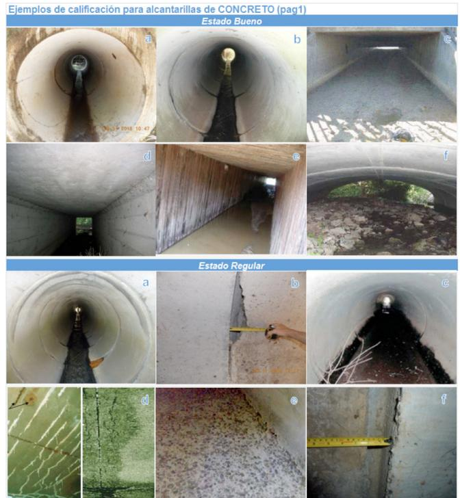
Figura 16. Complemento fotográfico para la inspección de tubos de concreto(1).
