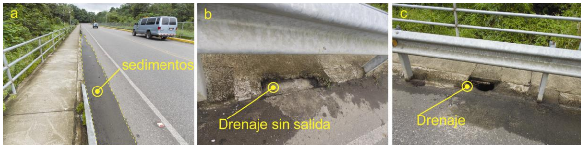
Figura 30: Puente sobre la quebrada Ignacia.
