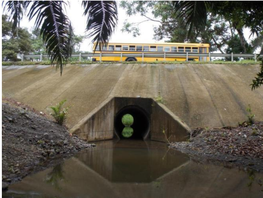
Figura 26: Alcantarilla en el estacionamiento 70+690.
