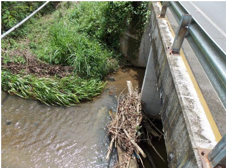
Figura 21: Puente sobre la quebrada Torrejones.
