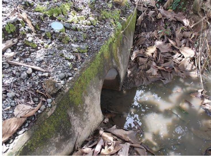
Figura 24: Alcantarilla en el estacionamiento 68+770.
