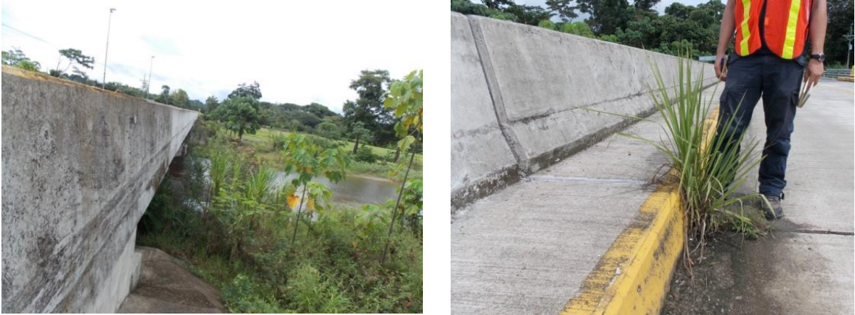
Figura 17: Puente sobre el río Conte.
