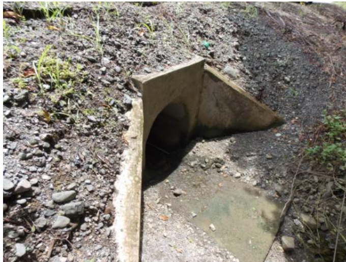
Figura 23: Alcantarilla en el estacionamiento 67+890.
