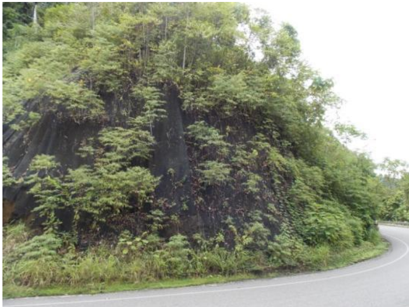
Figura 32: Talud del estacionamiento 43+600.
