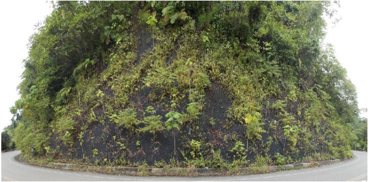
Figura 31: Talud del estacionamiento 43+510.
