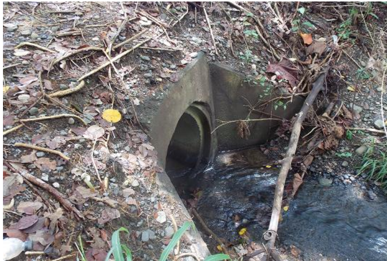
Figura 25: Alcantarilla en el estacionamiento 69+715.
