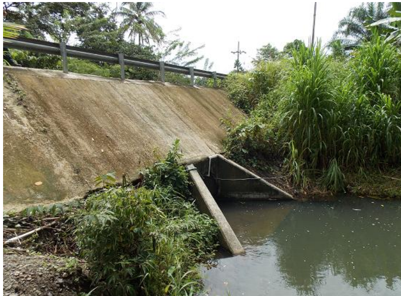
Figura 18: Alcantarilla en el estacionamiento 58+740.
