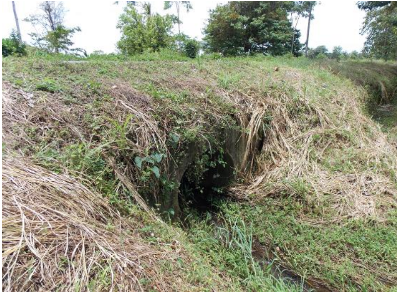
Figura 22: Alcantarilla en el estacionamiento 67+240.
