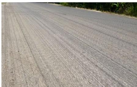
El perfilado debe eliminar la superficie agrietada o deteriorada.
