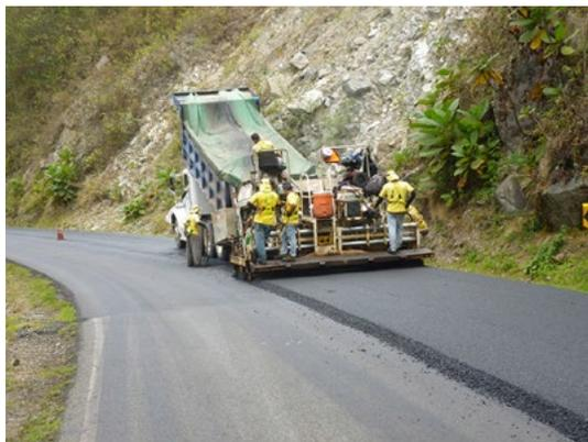
Figura 9. Colocación de capa asfáltica con pavimentadora
