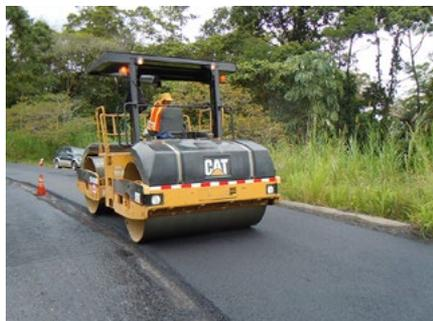
Equipo de compactación de dos rodillos. Verificar que el patrón de compactación se cumpla de acuerdo a la franja de control, sin excederse y se realice con el equipo definido para el patrón de compactación.
