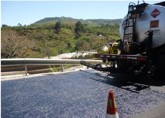
Figura 7. Riego de liga uniforme sobre la superficie
