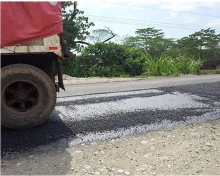
Colocación de “traba” para que la vagoneta pueda circular encima del riego de liga. Este material se enfría y tiene una temperatura diferente al material que se coloca encima, por lo que la compactación no será adecuada y se formará un plano de falla. Por otro lado, las llantas se encuentran sucias, por lo que la adherencia con capas superiores también será deficiente.
