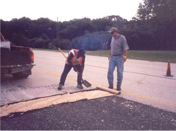
Figura 13. Juntas de construcción para colocación de transición tipo cuña
