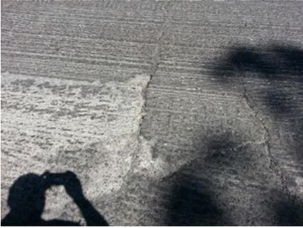
Se observa un perfilado insuficiente. La superficie se encuentra agrietada por lo que debe eliminarse.
