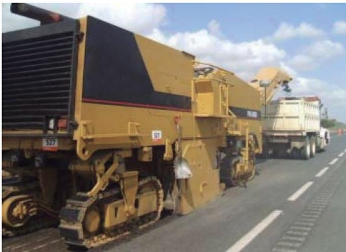
Figura 3. Perfilado de capa existente
