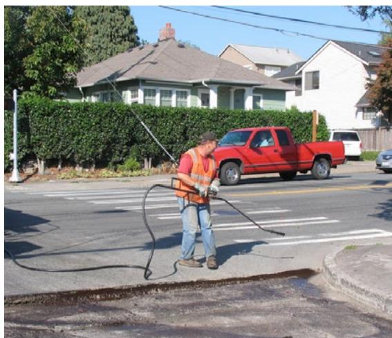
Figura 12. Riego de liga en juntas
