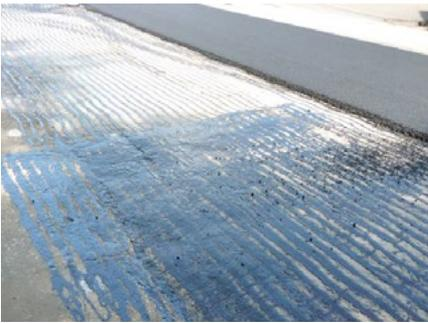
El riego de liga no es uniforme sobre la totalidad de la superficie. Verificar que las boquillas del dispensador de liga se encuentren limpias y en buen estado, la altura correcta de la barra, la presión de bombeo aplicada y la velocidad del camión distribuidor para que se aplique una dosificación correcta y uniforme.
