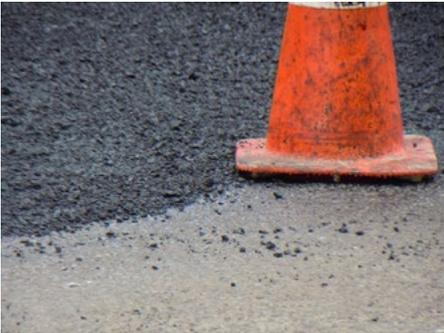
No se deben colocar capas de espesores inferiores a 3 veces el tamaño máximo nominal del agregado.
