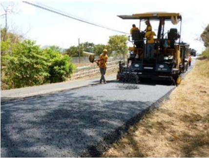
No se recomienda segregar la mezcla lanzándola encima de la superficie acabada por la pavimentadora.
