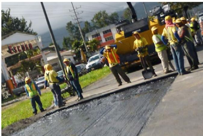
Figura 11. Preparación de paredes verticales en la junta
