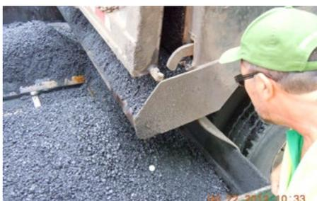
Verificar que la temperatura de mezcla asfáltica en caliente en la descarga de la vagoneta a la pavimentadora cumpla con la especificación.
