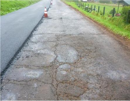
No se debe colocar mezcla sobre superficie agrietada y en malas condiciones.
