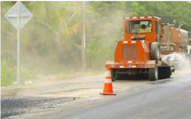
Figura 5. Limpieza de superficie con barredora mecánica
