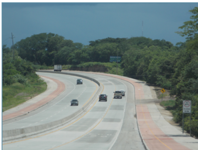
Fotografía 5. Ruta 1, sección Cañas – Liberia, 2016. Fuente: LanammeUCR
