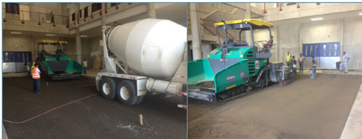
Fotografía 4. Proceso de colocación de base estabilizada en PaveLab, 2013. Fuente: LanammeUCR
