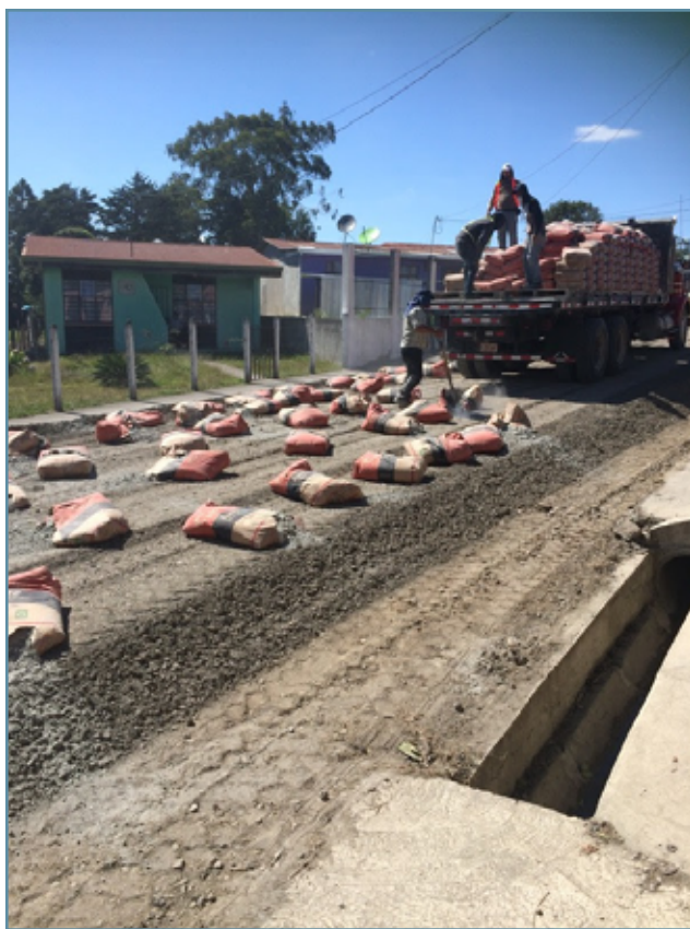
Fotografía 3. Tramo de prueba de base estabilizada ubicado en Cartago, 2015. Fuente: LanammeUCR
