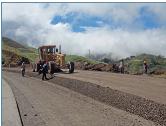
Fotografía 6. Colocación de base estabilizada con cemento en proyecto Sifón – La Abundancia. Fuente: LanammeUCR
