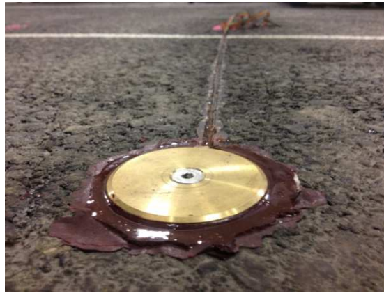
Figura 3 Aspecto superficial de la instalación concluida
