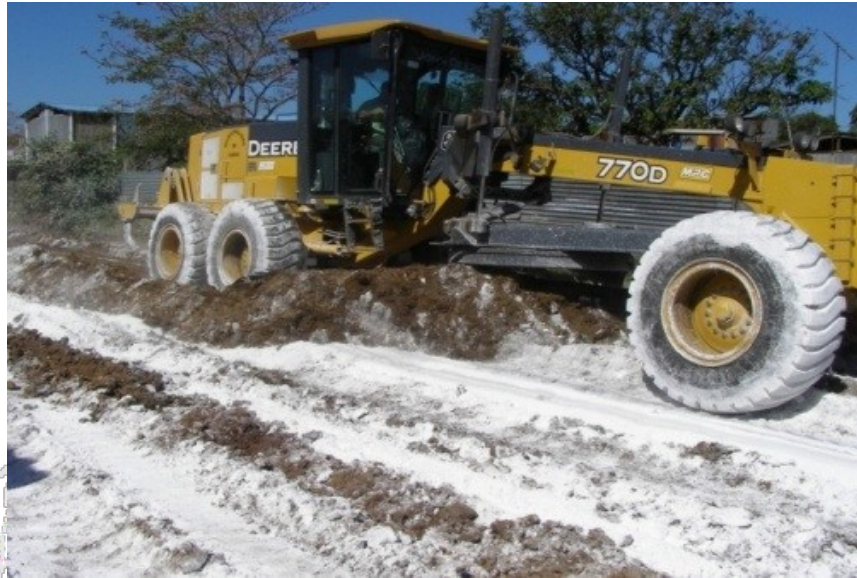
Figura 5. Construcción de un tramo estabilizado con cal.
