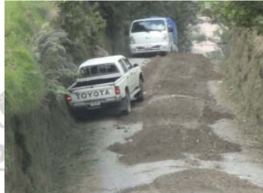
Fotografía N°1: Ruta Nacional N° 402, Cot (Iglesia)-Pacayas (R.230). Trabajos de bacheo mecanizado: primero conformación y luego relastrado según indicaciones del Inspector de la zona.
