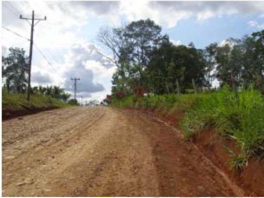
Fotografía N° 2: Ruta Nacional N° 752, San Bosco (Iglesia)-Santa Rosa (R.35). Estación 17+000. Trabajos de relastrado: conformación (izquierda) previos al relastrado (derecha), sin embargo se pagan por separado ambas actividades.
