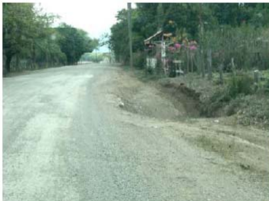
Fotografía N° 12: Izquierda: Ruta Nacional N° 152, Veintisiete de Abril (R.160)-Villarreal (R.15). Derecha: Ruta Nacional N° 335, Santa Eduvigis (Iglesia)-Los Ángeles. Socavación con pérdida de área de calzada.
