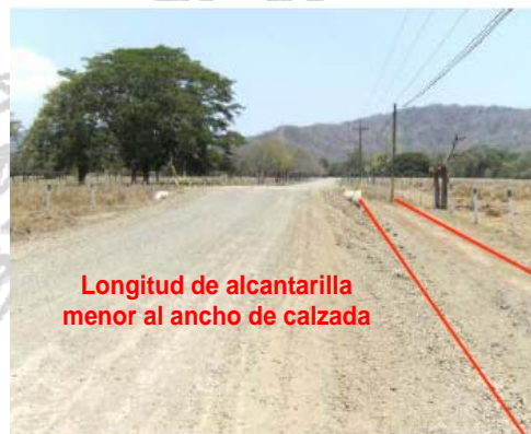
Fotografía N° 13: Ruta Nacional N° 910, Cartagena (Iglesia)-Tempate (Iglesia). Alcantarilla con longitud menor al ancho de calzada, sin señalamiento preventivo que indique estrechez de calzada Fuente: Unidad de Auditoría Técnica, LanammeUCR. Visita: 20 de abril del 2010.
