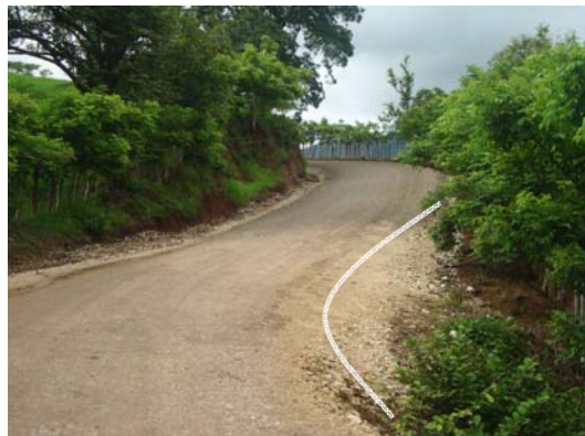
Fotografía N° 23: Ruta Nacional N° 925, Jabilla Abajo (R.1)-Lte. Cantonal Cañas/Tilarán (Río Higuerón Último Paso). Estación 5+215 Terraplén sin señalización preventiva, ni sistema de contención vial. Fuente: Unidad de Auditoría Técnica, LanammeUCR. Visita 8 de junio del 2010.
