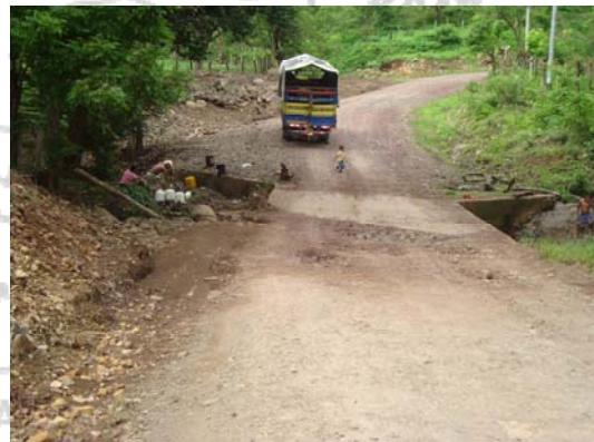
Fotografía N° 24: Ruta Nacional N° 925, Jabilla Abajo (R.1)-Lte. Cantonal Cañas/Tilarán (Río Higuerón Último Paso). Vados sin señalización preventiva, ni poste vertical o mojón indicador de la profundidad del agua a la que se permite el paso por esta estructura. Fuente: Unidad de Auditoría Técnica, LanammeUCR. Visita 6 de mayo del 2010.
