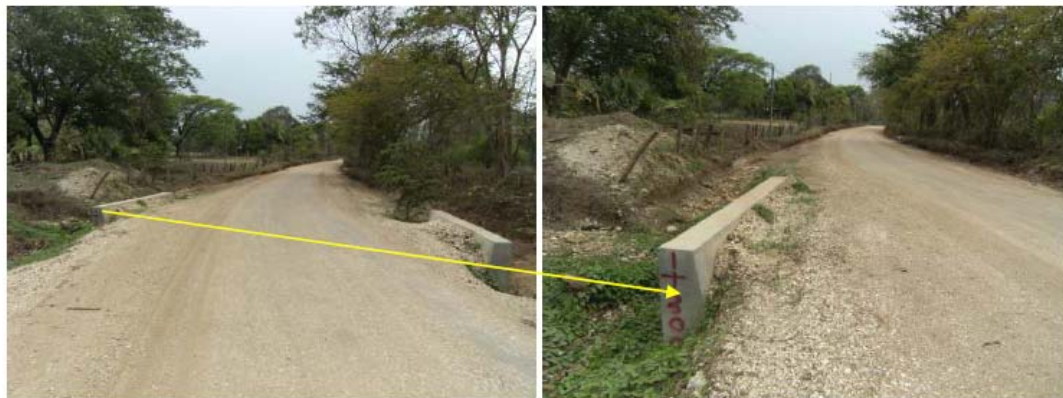
Fotografía N° 14: Ruta Nacional N° 907, Corralillo (R.906)- Queb. Honda (R.18), Alcantarilla con longitud cuyos cabezales se encuentran desalineados longitudinalmente respecto de la calzada.
