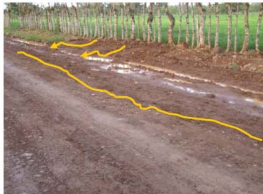
Fotografía N° 17: Ruta Nacional N° 733, Santa Fé (San Martín Iglesia) San Rafael de Guatuso. Escombros en calzada la cuneta sin retirar, producto de trabajos anteriores a la fecha de la visita.
