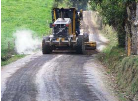
Fotografía N°1: Ruta Nacional N° 402, Cot (Iglesia)-Pacayas (R.230). Trabajos de bacheo mecanizado: primero conformación y luego relastrado según indicaciones del Inspector de la zona.
