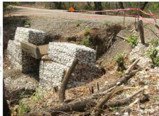
Fotografía N° 11: Izquierda: Ruta Nacional N° 907, Corralillo (R.906)-Queb. Honda (R.18), Derecha: Ruta Nacional N° 931, Lte. Cant. Santa Cruz/Nicoya (Queb. Taburete)-Chira (R.150) Socavación con pérdida de área de calzada.
