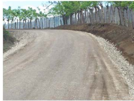
Fotografía N° 3: Ruta Nacional N° 925, Jabilla Abajo (R.1)-Lte. Cantonal Cañas/Tilarán (Río Higuierón Último Paso), Tramo entre 4+960 y 5+318. Material calizo del Tajo San Buena que en presencia de humedad, muestra baja resistencia al deslizamiento, colocado en curvas con pendiente vertical importante.
