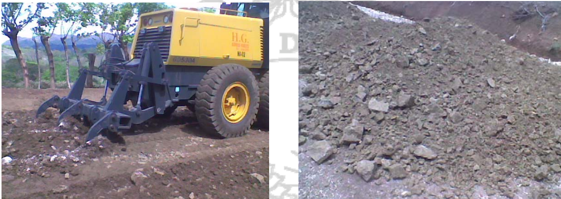
Fotografía N° 4: Ruta Nacional N° 925, Jabilla Abajo (R.1)-Lte. Cantonal Cañas/Tilarán (Río Higuerón Último Paso). Medida correctiva donde se coloca y mezcla material del Tajo Líbano con el del Tajo San Buena, colocado el día anterior.
