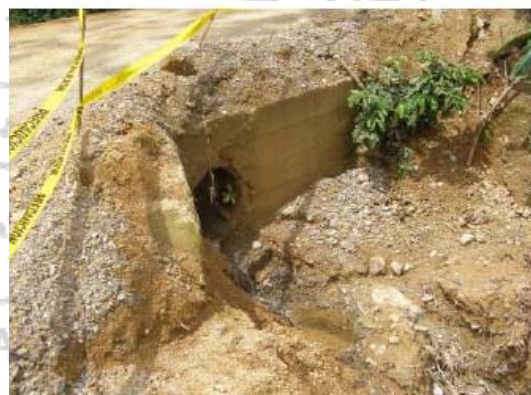
Fotografía N° 12: Izquierda: Ruta Nacional N° 152, Veintisiete de Abril (R.160)-Villarreal (R.15). Derecha: Ruta Nacional N° 335, Santa Eduvigis (Iglesia)-Los Ángeles. Socavación con pérdida de área de calzada.
