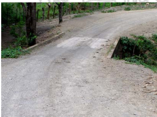
Fotografía N° 24: Ruta Nacional N° 925, Jabilla Abajo (R.1)-Lte. Cantonal Cañas/Tilarán (Río Higuerón Último Paso). Vados sin señalización preventiva, ni poste vertical o mojón indicador de la profundidad del agua a la que se permite el paso por esta estructura. Fuente: Unidad de Auditoría Técnica, LanammeUCR. Visita 6 de mayo del 2010.
