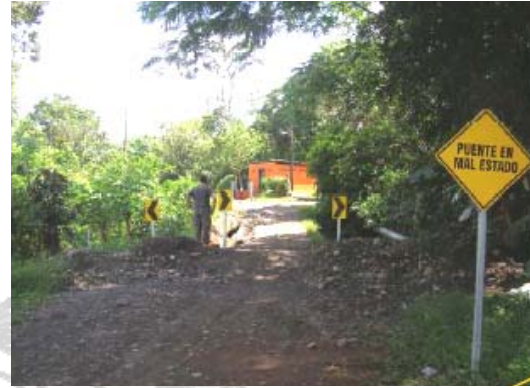
Fotografía N° 21: Ruta Nacional N° 752, San Bosco (Iglesia)-Santa Rosa (R.35). Puente de troncos de madera sobre el Río Pocosol, con señalización preventiva inadecuada sobre todo en uno de los accesos.
