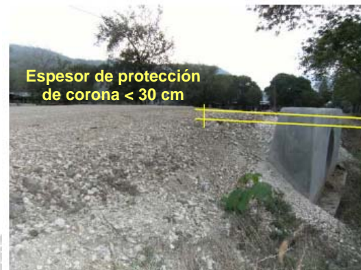
Fotografía N° 15: Ruta Nacional N° 907, Corralillo (R.906)-Quebrada Honda (R.18) Alcantarilla con sobre nivel, con rampa de inadecuada transición longitudinal y poco espesor de protección en la corona.
