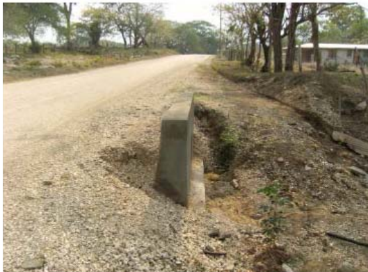
Fotografía N° 11: Izquierda: Ruta Nacional N° 907, Corralillo (R.906)-Queb. Honda (R.18), Derecha: Ruta Nacional N° 931, Lte. Cant. Santa Cruz/Nicoya (Queb. Taburete)-Chira (R.150) Socavación con pérdida de área de calzada.
