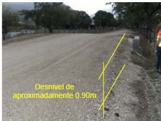
Fotografía N° 15: Ruta Nacional N° 907, Corralillo (R.906)-Quebrada Honda (R.18) Alcantarilla con sobre nivel, con rampa de inadecuada transición longitudinal y poco espesor de protección en la corona.
