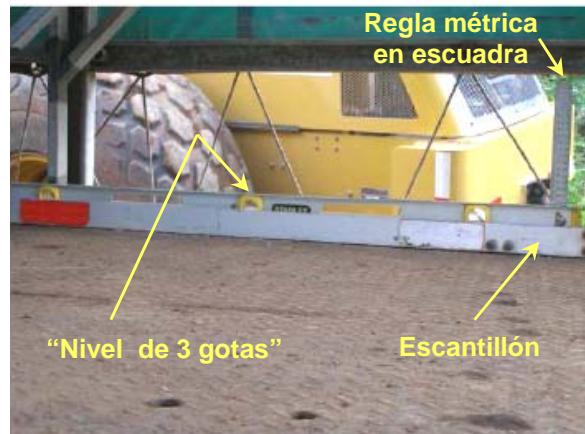
Fotografía N° 7: Ruta Nacional N° 752, San Bosco (Iglesia)-Santa Rosa (R.35). “Nivel de 3 gotas” apoyado en un escantillón complementado con una regla métrica en escuadra, para determinar espesores de lastre y pendiente transversal de la calzada.
