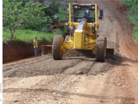
Fotografía N° 2: Ruta Nacional N° 752, San Bosco (Iglesia)-Santa Rosa (R.35). Estación 17+000. Trabajos de relastrado: conformación (izquierda) previos al relastrado (derecha), sin embargo se pagan por separado ambas actividades.
