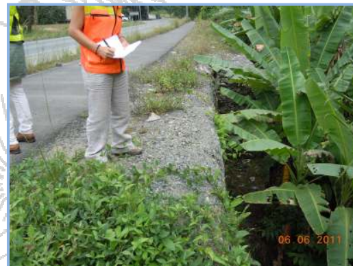
Estación 0+360 (06-jun-2011) Zona sin sistema de contención.
