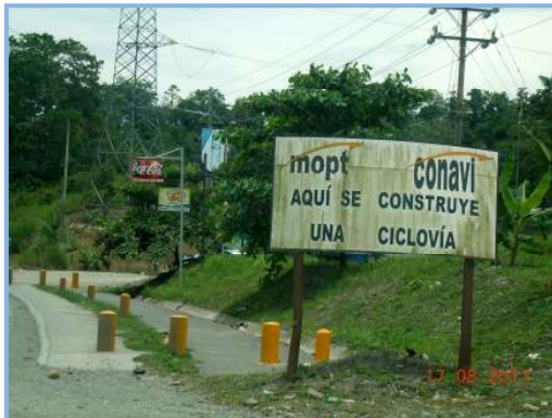
Estación 0+000 (17-ago-2011) Inicio de ciclovia.
