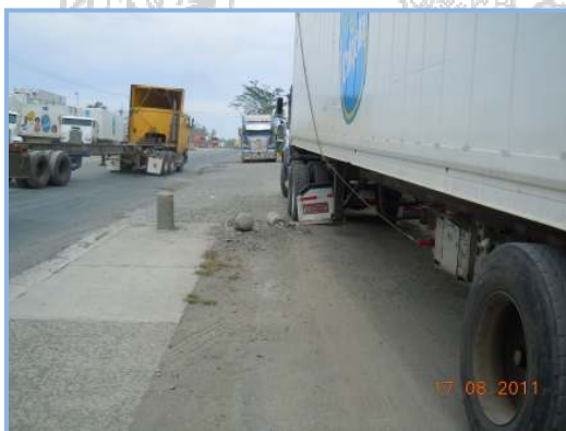
Fotografías N° 7: Estación 1+460 a 1+650, Vehículos pesados estacionados sobre la ciclovía, incluso pasando por encima de los bolardos. Fuente: Unidad de Auditoría Técnica, LanammeUCR. (17-ago-2011)
