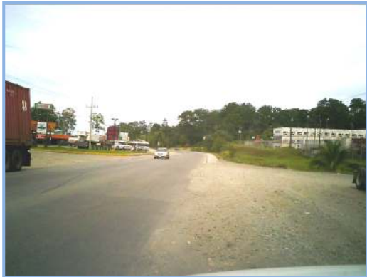
Estación 2+300 (17-ago-2011) Intersección sin señalización.
