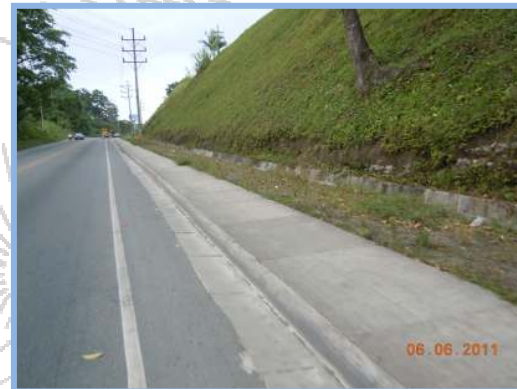
Estación 0+800 (06-jun-2011) Obras de acera y cordón de caño, además material granular colocado para ciclovía.
