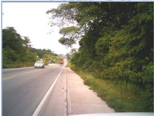
Estación 2+700 (17-ago-2011) Solo obras de acera y cordón de caño.
