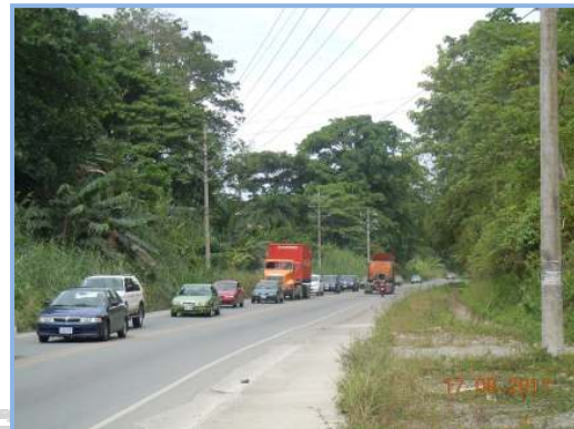
Estación 0+510 (17-ago-2011) Obras de acera y cordón de caño, además material granular colocado para ciclovía.
