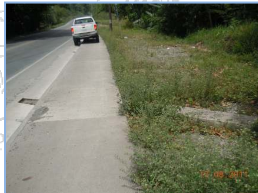
Estación 0+500 (17-ago-2011) Material granular colocado.
