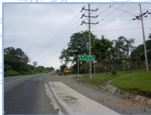
Estación 1+100 (06-jun-2011) Obras de acera y cordón de caño, además material granular colocado para ciclovía.
