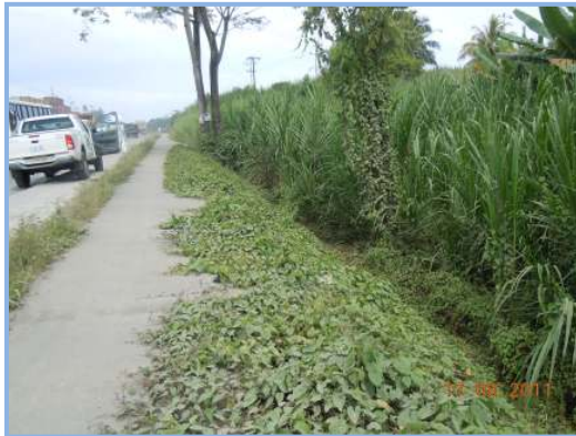
Fotografías N° 6: Estación 1+680, Zona sin barrera de contención en sector con talud. Fuente: Unidad de Auditoría Técnica, LanammeUCR. (17-ago-2011)
