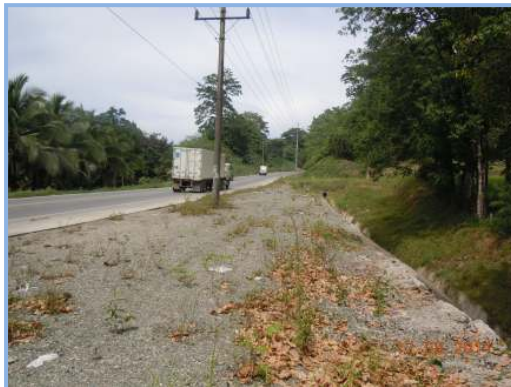
Estación 0+510 (17-ago-2011) Obras de acera y cordón de caño, además material granular colocado para ciclovía.
