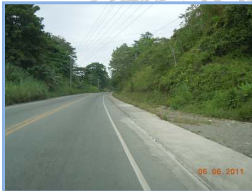
Estación 0+800 (06-jun-2011) Obras de acera y cordón de caño, además material granular colocado para ciclovía.
