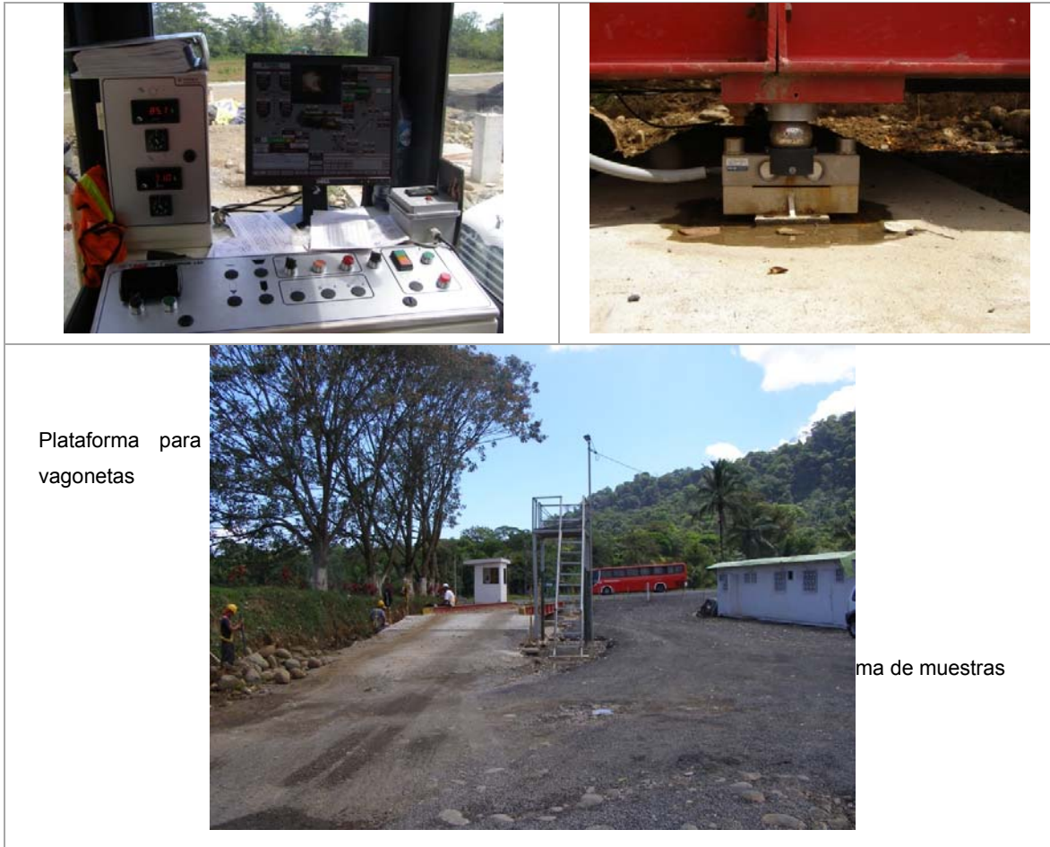
Fotografía 3 Cabina de control y plataforma de pesaje.
