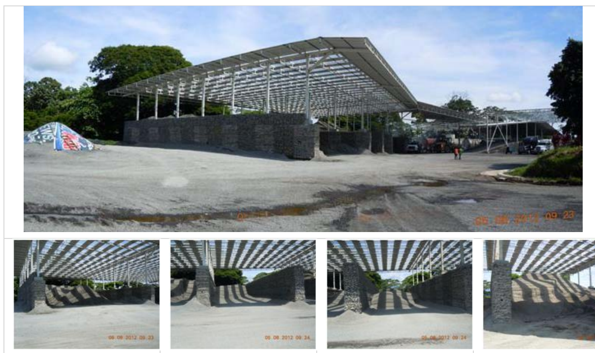
Fotografía 7 Zona de apilamientos de agregados.
